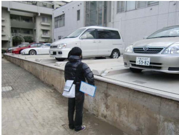
ここもピット式の駐車場。浮上がり量は約1m。 この部分が何階式かは聞けなかった。
