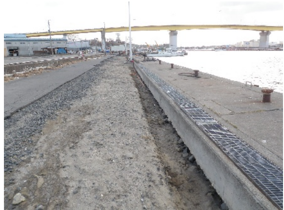
写真4 八戸漁港。津波による舗装の被害。北緯40度31分49秒，東経141度31分33秒
