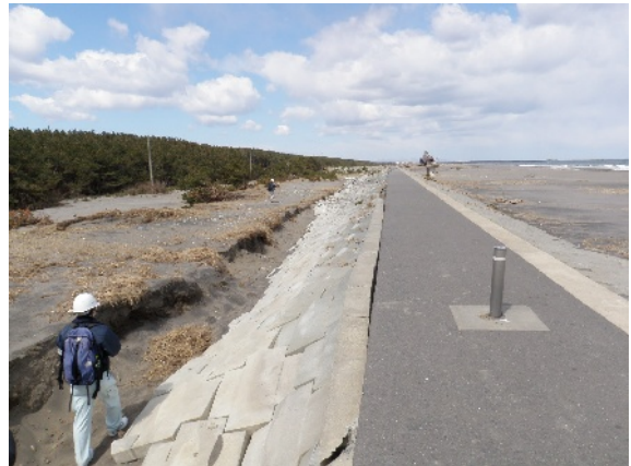
写真2 百石海岸。海裏側の法尻が洗掘を受けている。北緯40度39分15秒，東経141度26分34秒
