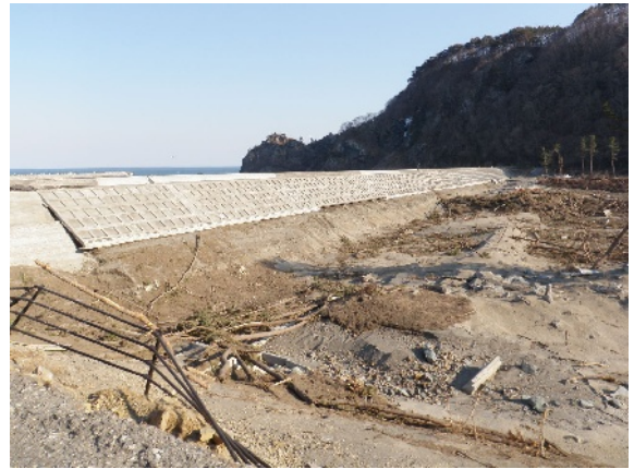
写真9 小本港防潮堤の洗掘. 北緯39度50分58秒, 東経141度58分21秒
