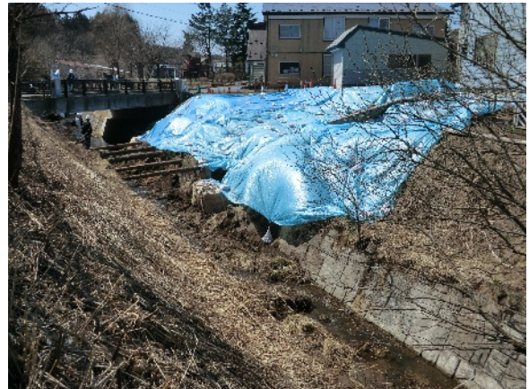
写真14 田子町河川法面崩壊現場。北緯40度 20分09秒，東経141度03分32秒
