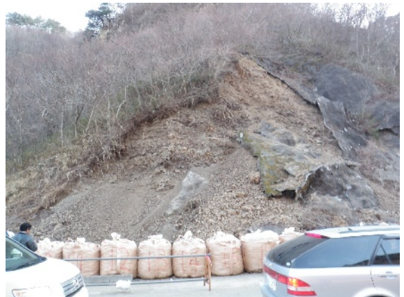
写真11 田野畑村机の法面崩落状況. 北緯39度57分09秒, 東経141度57分21秒.
