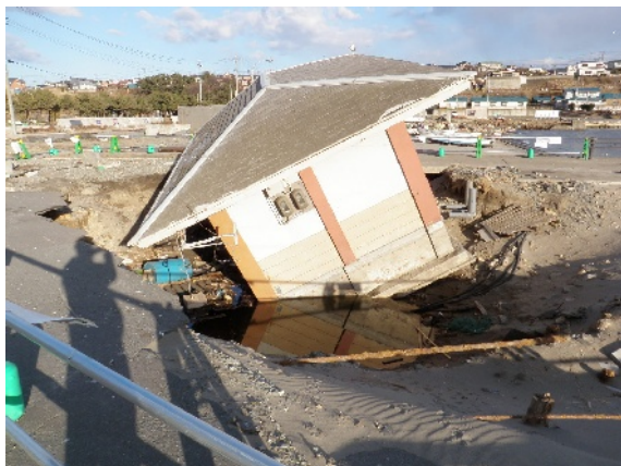
写真5 蕪島。洗掘による沈下。北緯40度32分15秒，東経141度33分26秒
