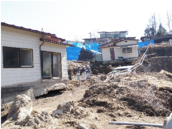
写真13 二戸市宅地盛土崩壊現場。北緯40度 15分40秒，東経141度17分41秒
