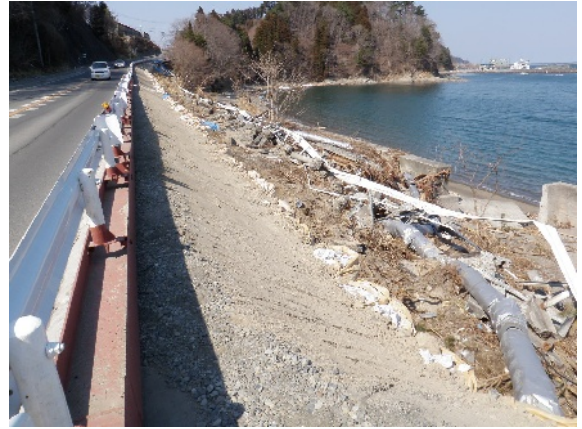
写真7 宮古市国道45号線. 北緯39度36分48秒, 東経141度57分43秒
