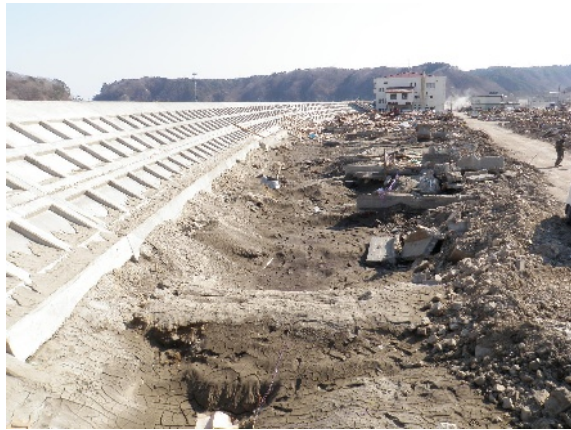
写真8 田老町防潮堤崩壊現場. 北緯39度44分24秒, 東経141度58分23秒,
