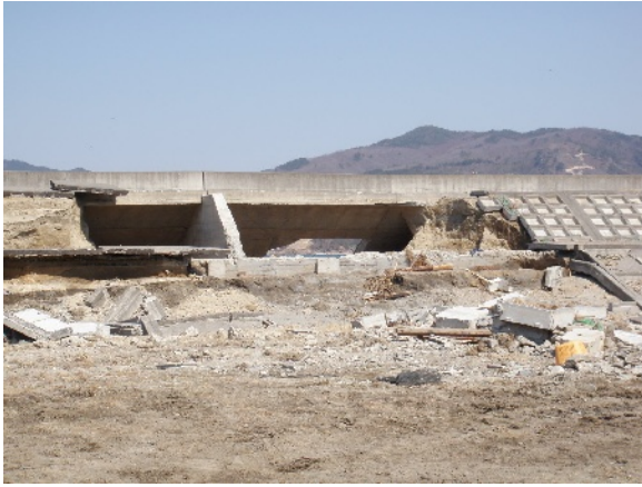
写真6 宮古市防潮堤崩壊現場. 北緯39度35分33秒, 東経141度56分46秒
