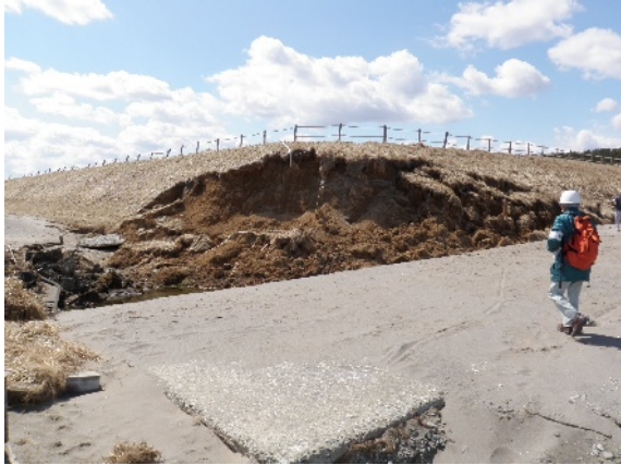
写真1 三沢漁港で見られた津波による浸食を受けた盛土。北緯40度40分44秒，東経141度26分06秒
