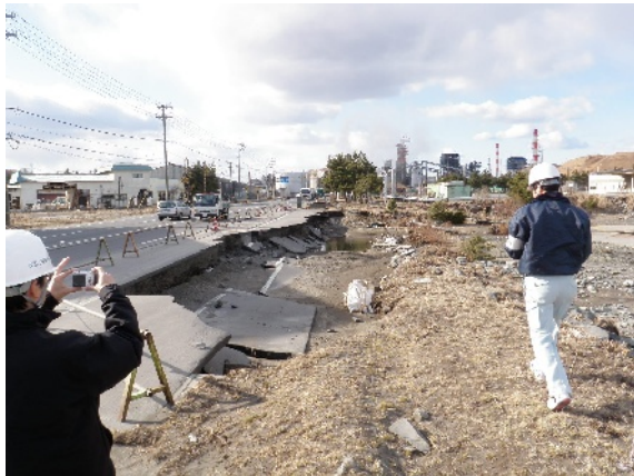
写真3 八戸港，上北沼。津波による道路被害。北緯40度33分39秒，東経141度29分00秒
