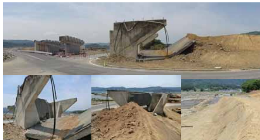
沼田跨線橋の橋台背面盛土の流出状況
