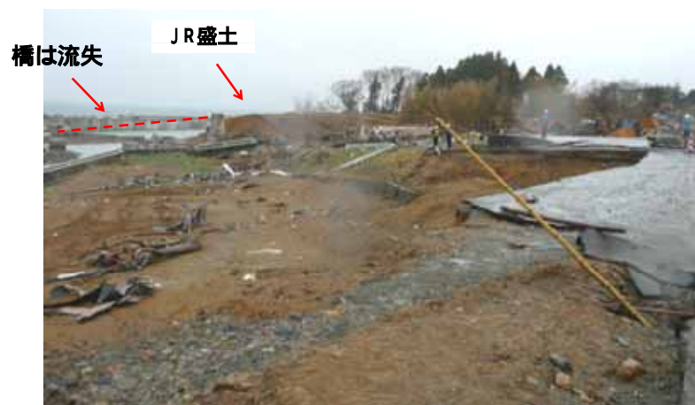
道路盛土の流出状況
