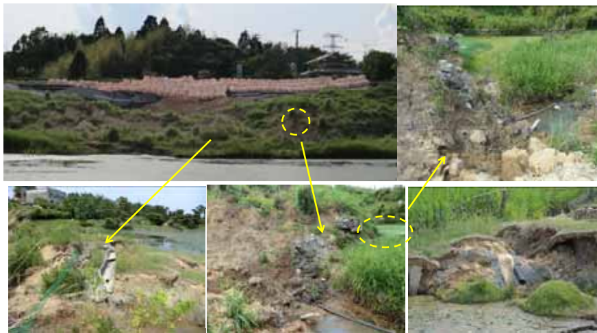
被災箇所全景およびのり尻部の状況
