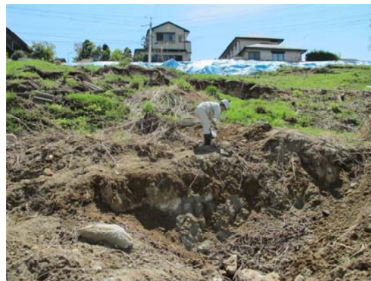
写真-4 長大法面の被害 (北中山)
