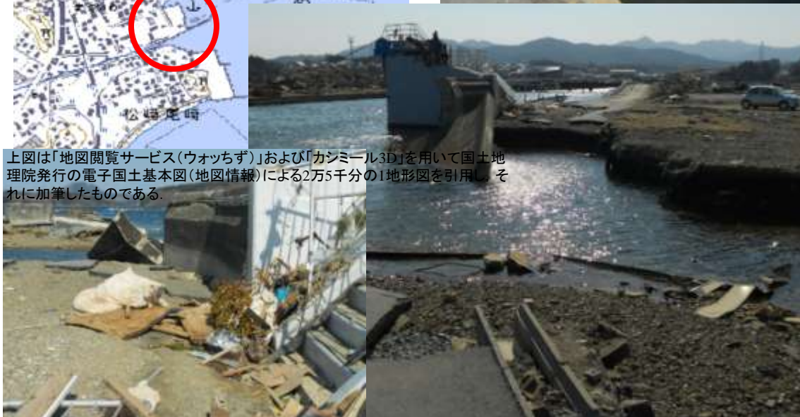
海岸堤防の傾斜・転倒, 周辺道路の流失
