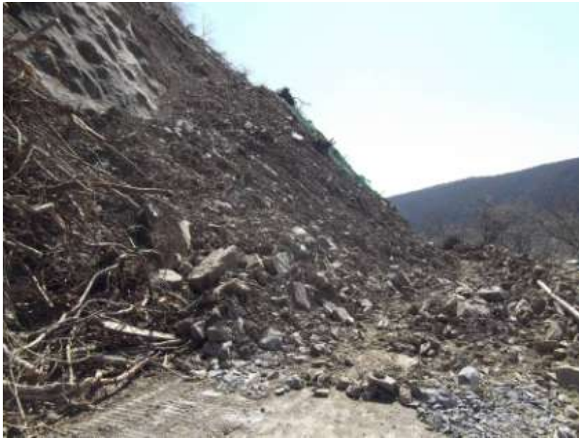
写真 2.2 崩壊地の近景
