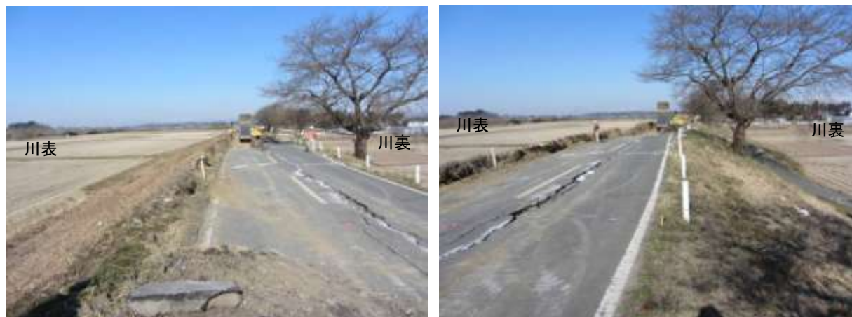
写真 1.1 左岸側の堤防の状況(地点 1)
