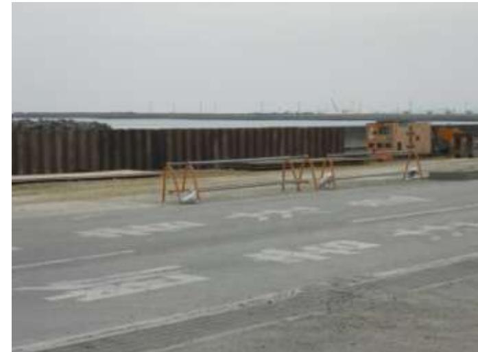
堤防背面の洗掘(奥行き約20m)
