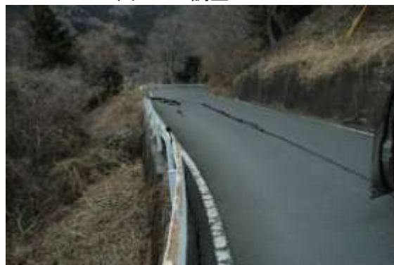
写真 3.1 道路盛土部での被害事例
