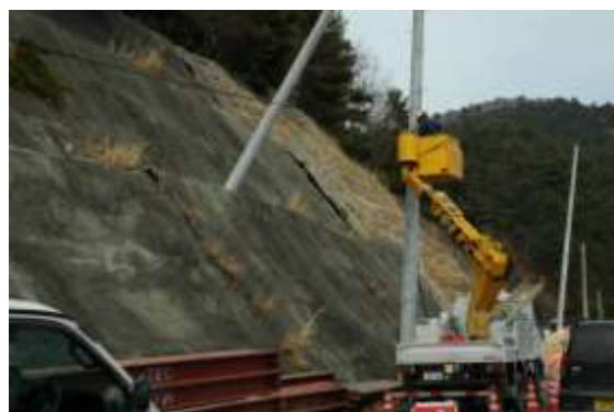
写真 3.3 道路切土法面での被害事例 2
