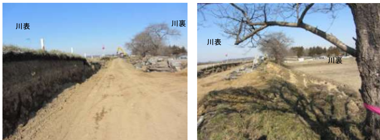
写真 1.2 左岸側の堤防の状況(地点 1)
