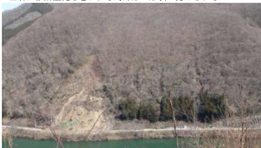
写真 2.1 崩壊地の全景
