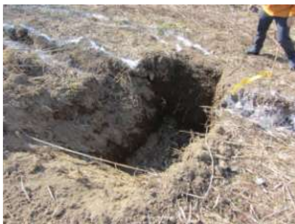
写真 1.3 右岸側の堤防の状況(地点 2)
