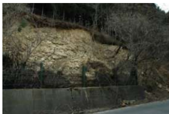
写真 3.2 道路切土法面での被害事例 1
