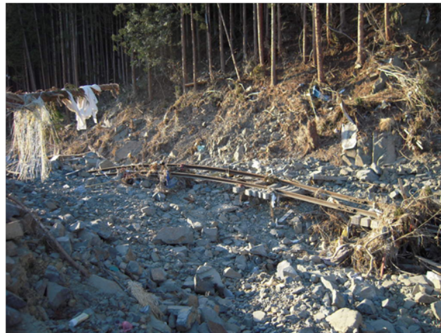
被害状況（陸前戸倉駅）
