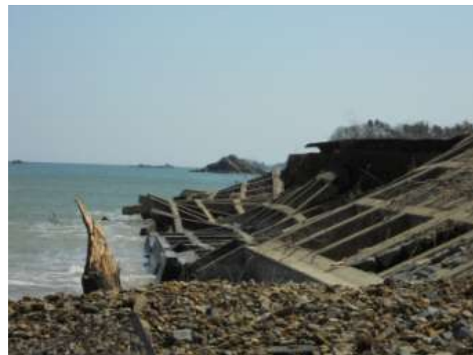
津谷川河口左岸側の 堤防先端の損傷・流失
