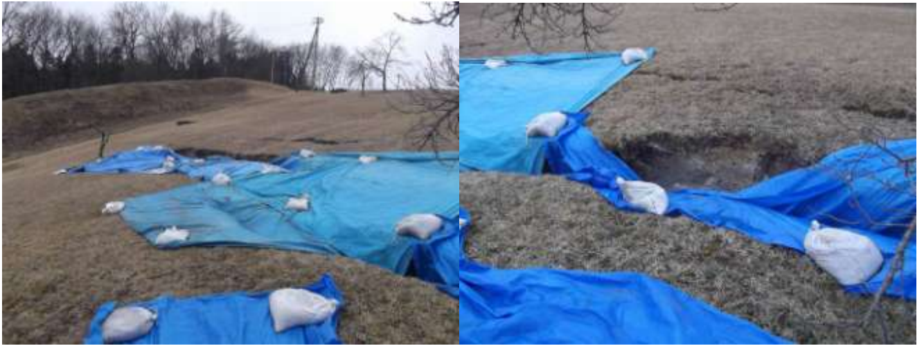
写真 4.2 盛土の変状状況 (2 盛土変状箇所)
