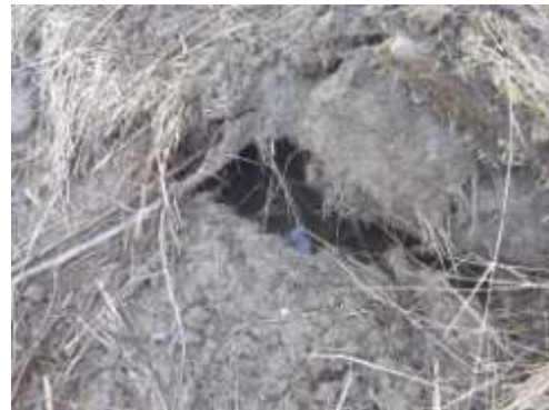
平坦部のクラックの状況
