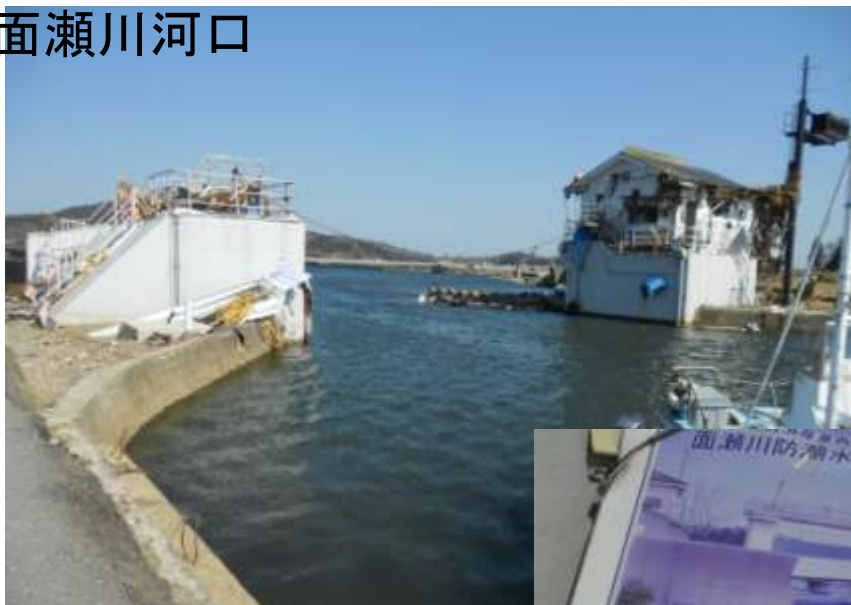
面瀬川河口防潮水門の流失
