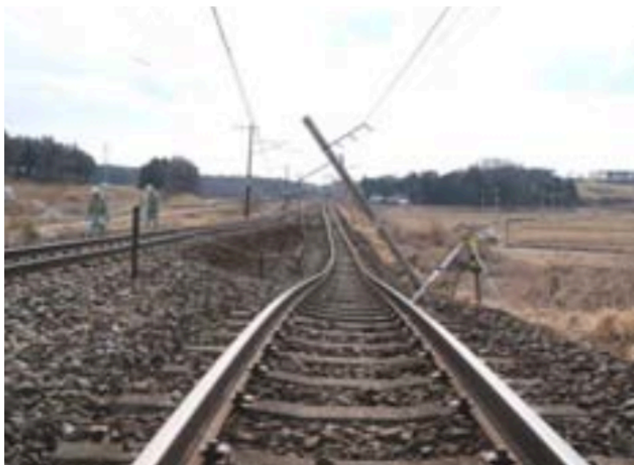
被害状況（JR東日本HPより）
