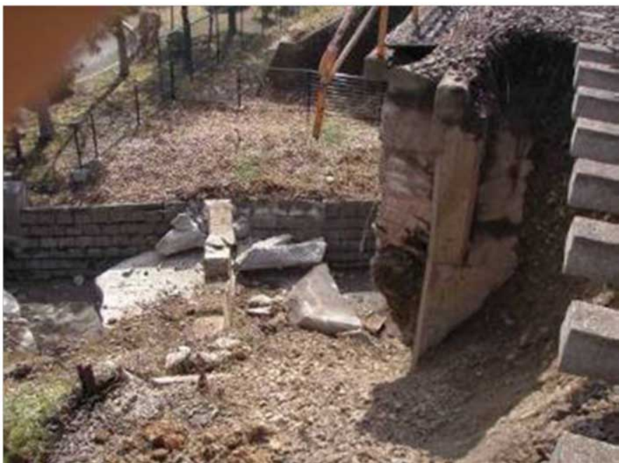
被害状況（JR東日本HPより）
