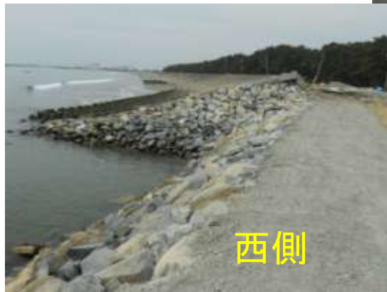
堤防背面の洗掘 (目測で奥行き50m, 深さ2m程度)
