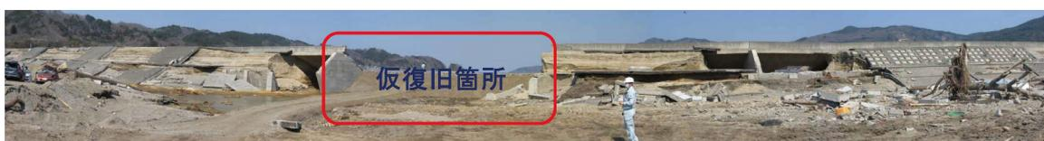
口絵写真一四 宮古市での防波堤背面からの被害状況(写真中央の仮復旧箇所は、津波により破壊されたと考えられ、その周辺の防波堤背面コンクリートの剥離と土砂の浸食・洗掘が顕著である。)
