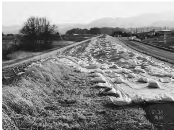
写真一七 角田市野田地区河川堤防 (位置⑥) 被害状況
