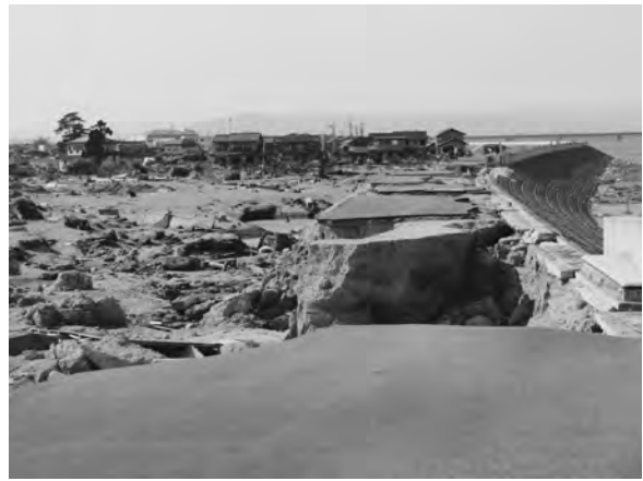
写真一六 亙理町荒浜地区河川堤防 (位置③) 被害状況
