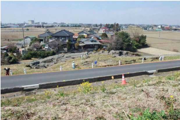
口絵写真一20 幸手市西関宿江戸川右岸のすべり (東京電機大学安田進教授撮影)
