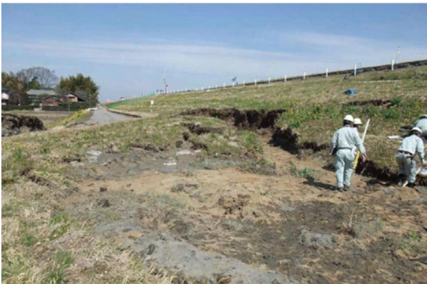
口絵写真一21 幸手市西関宿江戸川右岸すべり部の噴砂 (東京電機大学安田進教授撮影)
