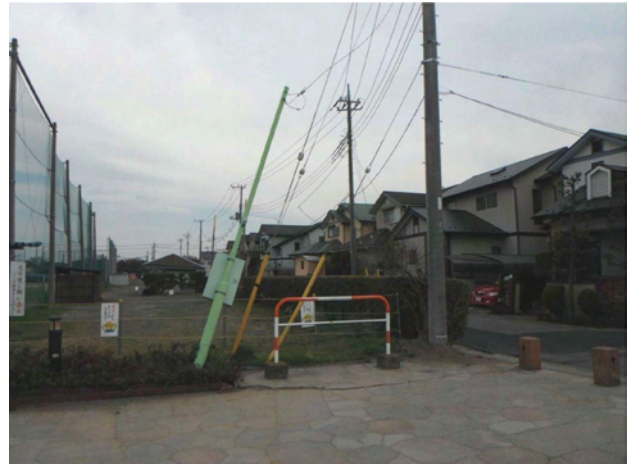
口絵写真一22 久喜市南栗橋における液状化被害
