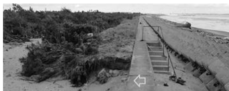
写真一14 直立防潮堤の背面で残った盛土：井土浜③
