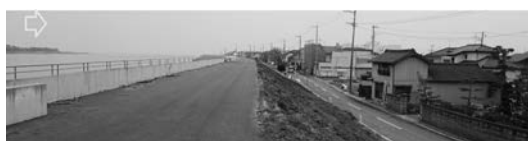
写真-25 越流が見られない河川堤防：阿武隈川右岸⑬
