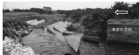
写真一33 写真一31の横からの状況：三川 E
