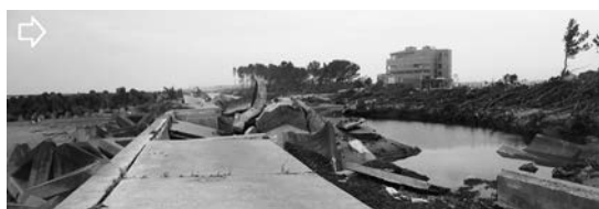
写真一10(a) 波返しと前面天端の組構造の防潮堤被害：荒浜⑤
