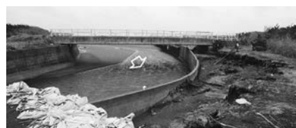
写真-28 河口からの越流での河川護岸の背面侵食：三川 E
