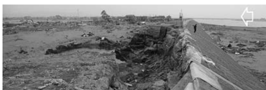
写真六 裏法の侵食による天端までの侵食：荒浜④
