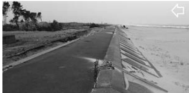
写真二 緩傾斜堤（低い）：荒浜①
