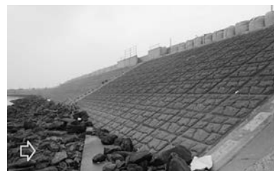
写真-29 損傷が無いブロック張りの河川護岸の表法面：阿武隈川右岸⑩
