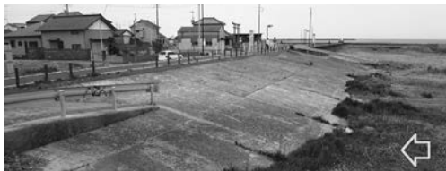
写真一 緩傾斜堤（高い）：下永井 G
