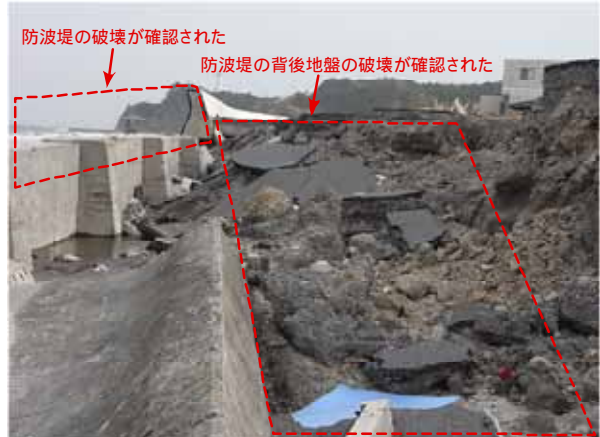
図—6 防波堤および背後地盤の破壊状況
