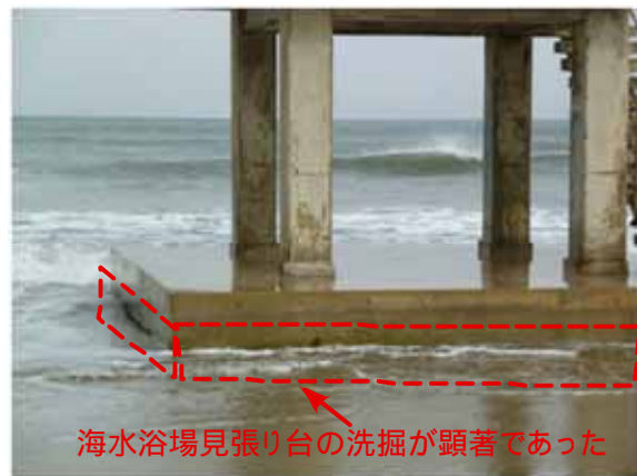
図—8 防波堤の後背地部分と見張り台基礎の洗掘状況
