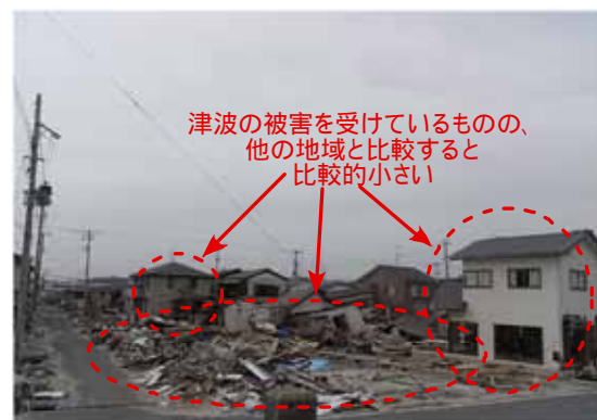
図-3 防波堤の背後地の被災状況
