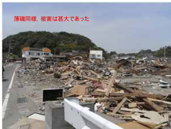
図-12 豊間の防波堤の後背地の被災状況
