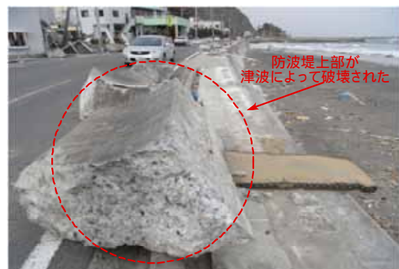
図—10 豊間の防波堤の被災状況
