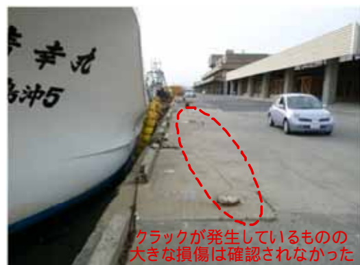
図-14 2011年5月2日現在の小名浜港の岸壁の状況
