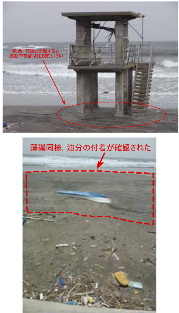
図-13 見張り台の洗掘状況と砂浜の油分付着状況
