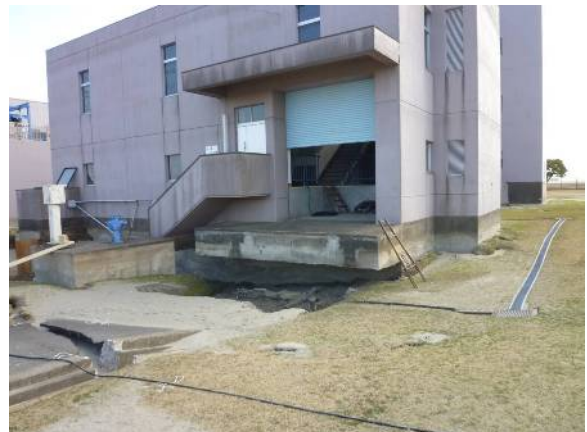
図-2 共同溝継手の開口（左手）とポンプ棟周辺の液状化による地面の沈下
