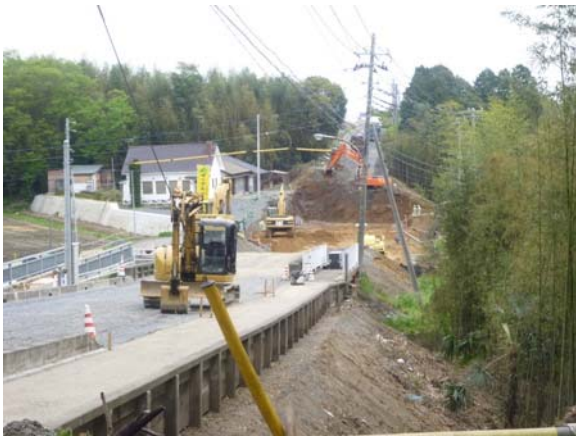
図-17 水戸勝田那珂湊線の道路盛土復旧
