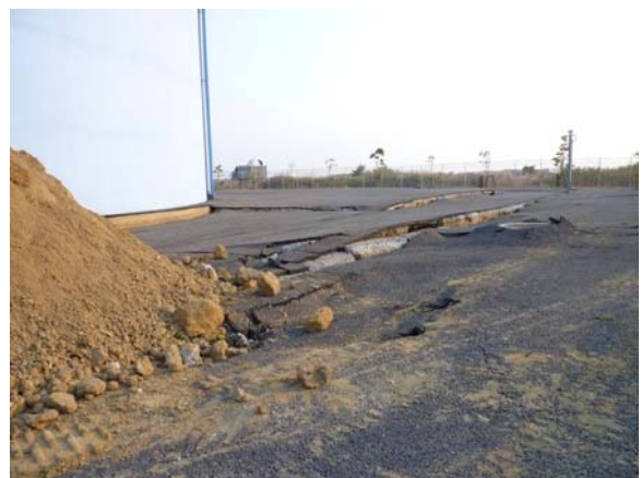
図-6 配水場北側の液状化による路面亀裂
