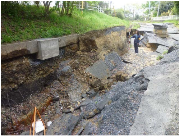
図-16 液状化によって2m近く路面が陥没（ひたちなか市）
