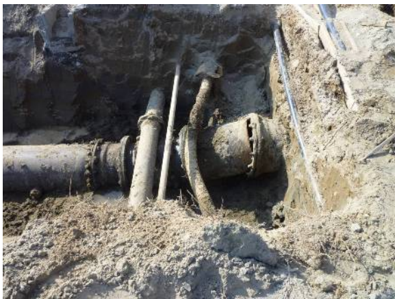
図-3 ポンプ棟取り合い部の継手抜け(φ600DIP)
