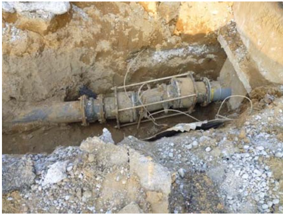
図-7 配水池取り合いの伸縮可撓管
