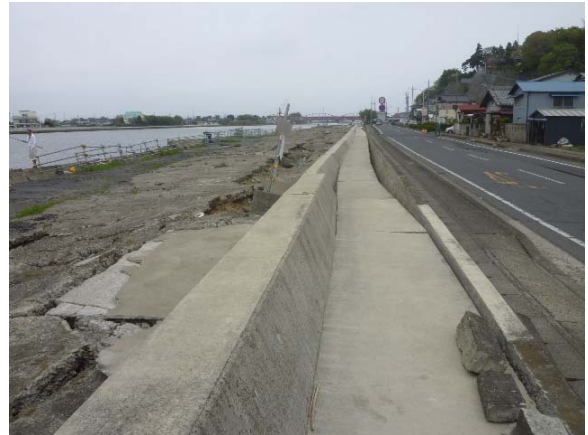
図-19 液状化によって2m近く路面が沈下（ひたちなか市海門町2丁目）
