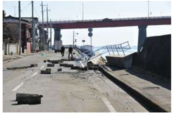
図-18 那珂川護岸の崩壊（ひたちなか市海門町2丁目） 2)
