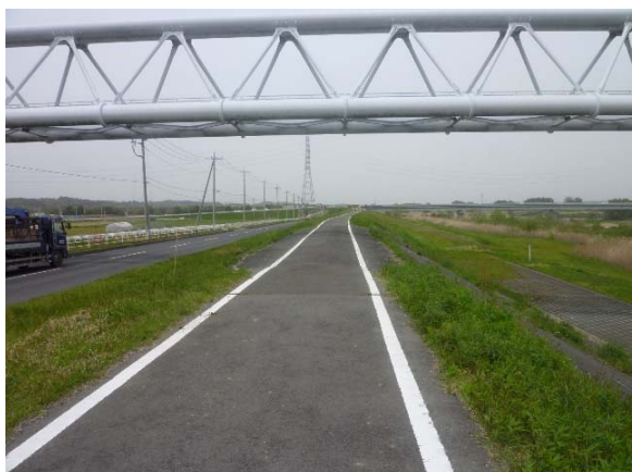
図-14 那珂川水管橋右岸単純トラス下の河川堤防(水戸市)
