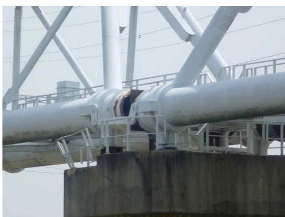
図-13 那珂川水管橋の継手抜け(水戸市)
