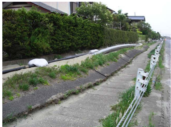
図-10 下水・水道管の浮上（潮来市日の出）
