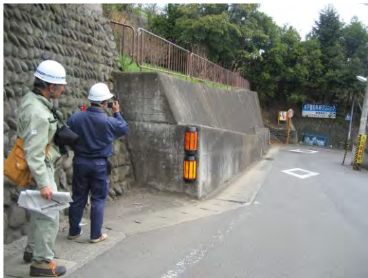
写真-3.1.2 2号緑地下端部の擁壁
