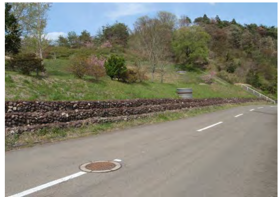
写真-3.15.1 ふとんかご敷設状況と集水井
