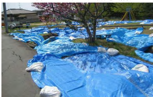
写真-3.14.6 団地西側公園内の亀裂
