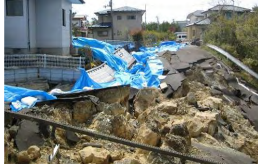
写真-3.14.8 団地西部の崩壊
