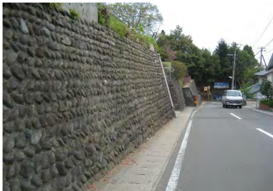
写真-3.1.8 玉石積擁壁
