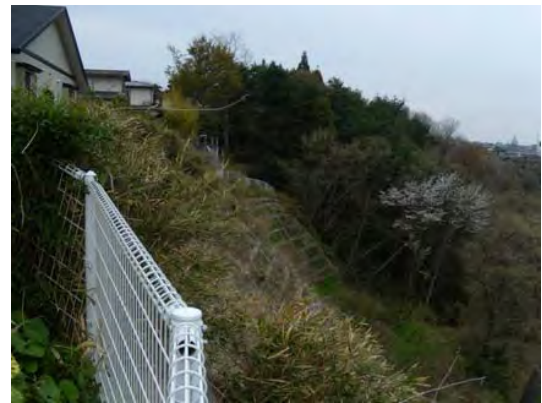
写真-3.6.5 東黒松の1急傾斜崩壊危険区域の対策済の隣接斜面
