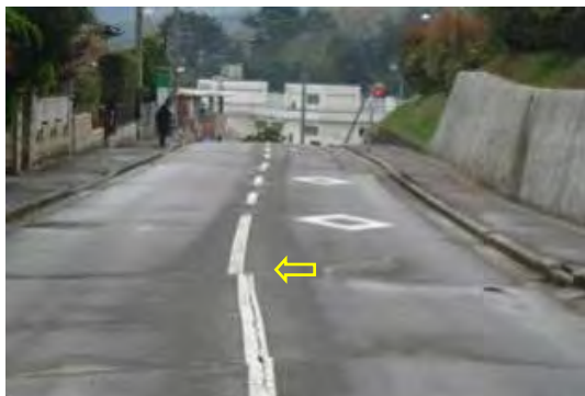
写真－3.10.6 B 地区の道路
