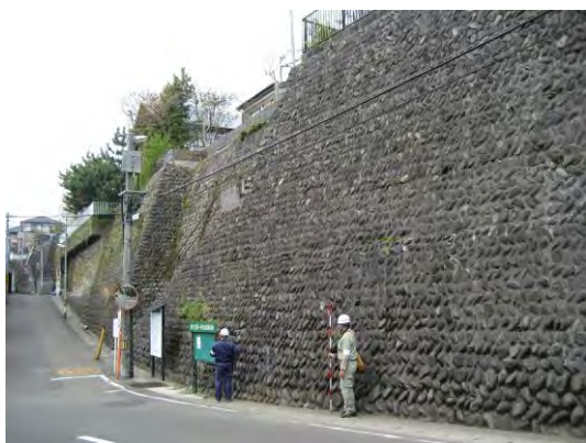
写真-3.1.10 高さ7m以上の玉石積擁壁
