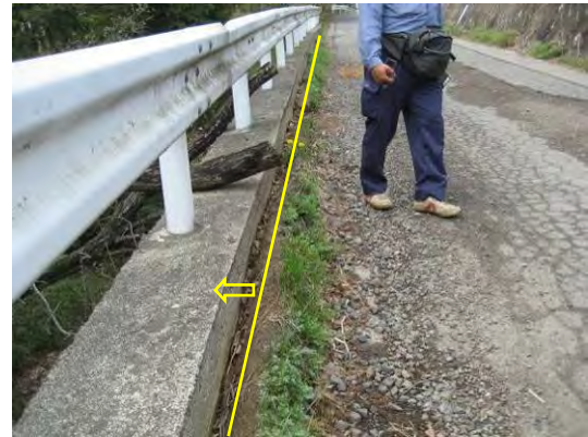
写真-3.12.6 路肩部の移動
