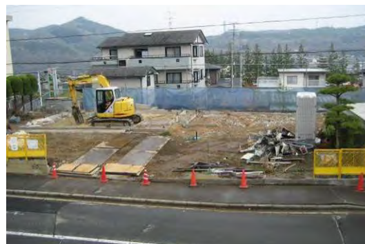
写真-3.10.4 B 地区住宅棟前の宅地 (撤去後)
