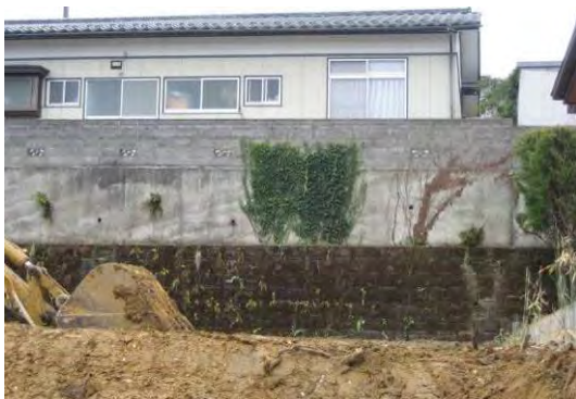
写真－3.10.5 B 地区周辺の擁壁
