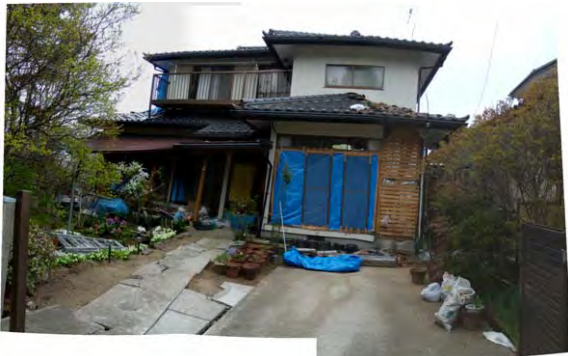
写真-3.6.3 1列目の人家の被災状況
