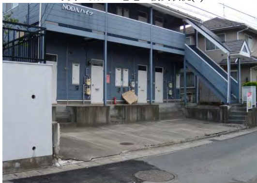
写真－3.8.5 道路を隔てたアパートの被災状況
