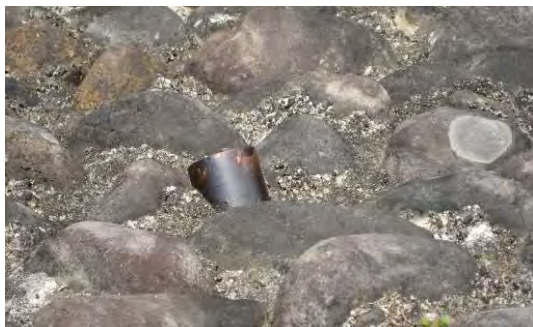
写真-3.1.9 土管の排水孔
