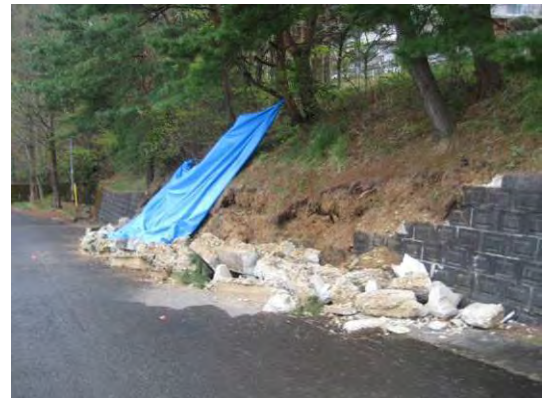
写真-3.9.10 移動土塊最下端
