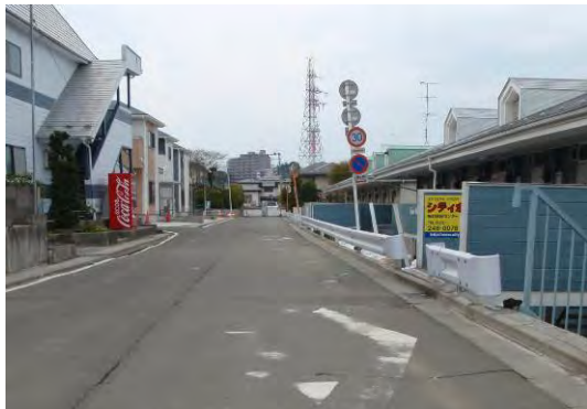
写真-3.5.4 ブロック積擁壁天端道路の状況
