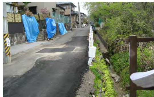
写真-3.2.5 盛土末端のスランプ形状
