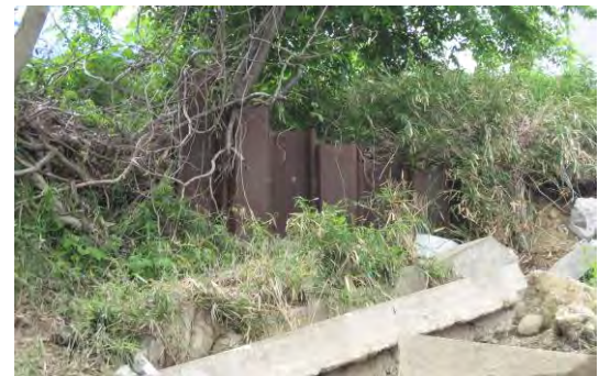
写真－3.8.8 階段付近で確認された鋼矢板
