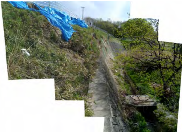
写真-3.16.2 道路下部のブロック積擁壁の状況
