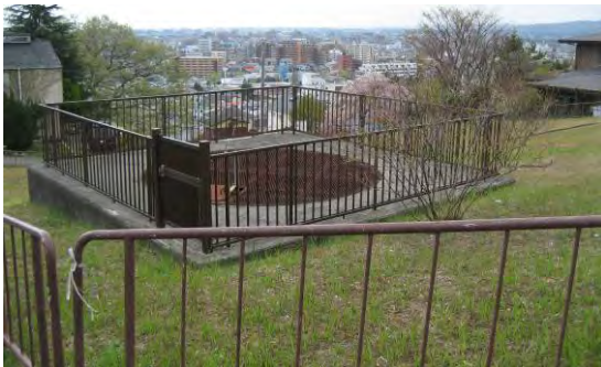
写真-3.1.3 2号緑地の集水井
