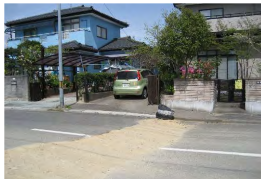
写真-3.14.10 団地内部の道路段差
