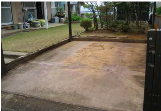
写真-3.9.5 駐車場の噴砂痕跡
