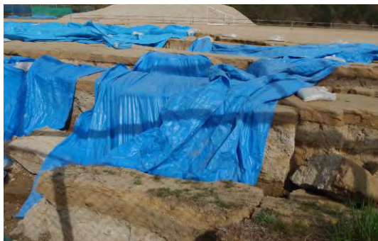
写真-3.16.3 道路上部の運動場の変状
