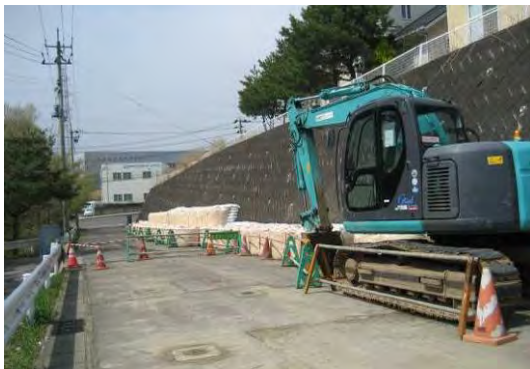
写真-3.12.3 大型土嚢による押さえ盛土
