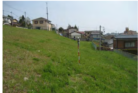
写真-3.1.5 1号緑地の全景(ポールおよび人は杭頭の位置)
