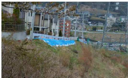
写真－3.11.4 南側盛土のり面
