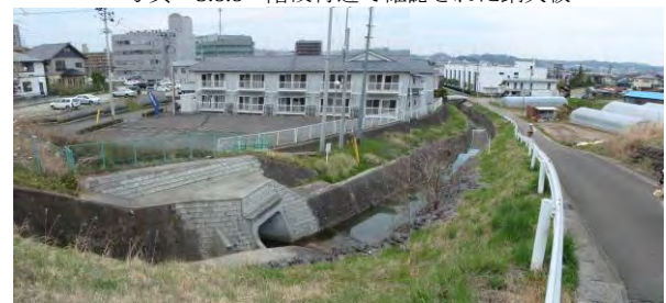
写真－3.8.9 対岸のアパートと駐車場の変状
