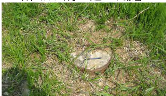
写真-3.1.11 1号緑地に施工されていた鋼管杭
