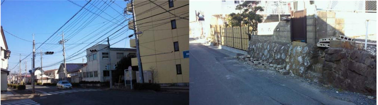
図6 常陸多賀周辺（左：不通の信号機，右：小規模の壁の崩壊）
