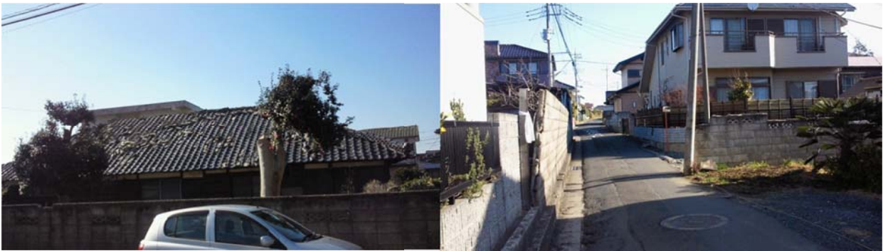
図5 大学周辺の被災状況（右：瓦屋根の被害，右：ブロック塀の傾斜）
