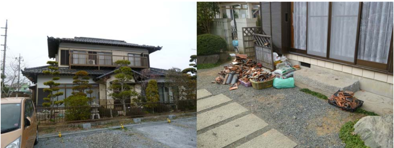
図11 左：小峯秀雄の自宅（瓦が所々、壊れている），右：回収した破壊された瓦（すべてではない）
