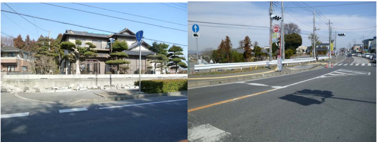
図10 左：家屋のブロック塀が倒壊，右：歩道がうねり，マンホールが浮き上がっている。
