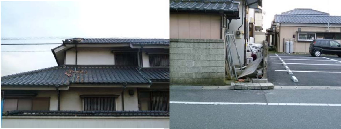
図4 家屋の被災状況（右：瓦屋根の被害，右：ブロック塀の倒壊）
