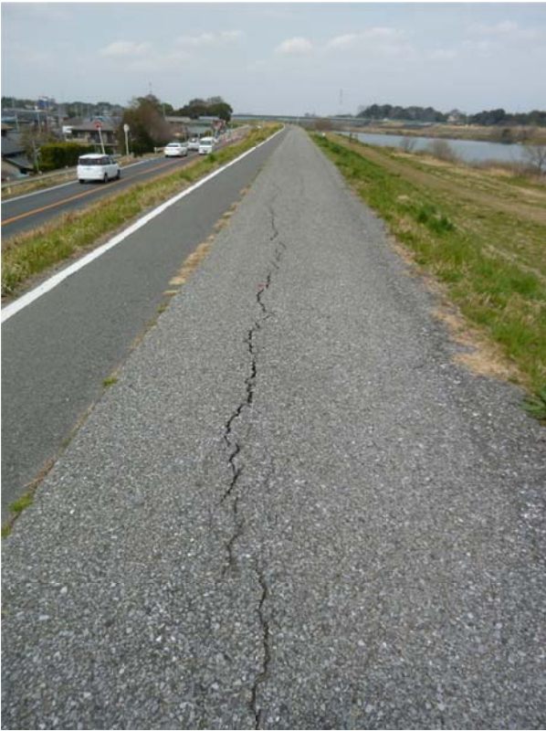
図 10 堤防天端部に亀裂は確認されるものの噴砂の確認されない地点
