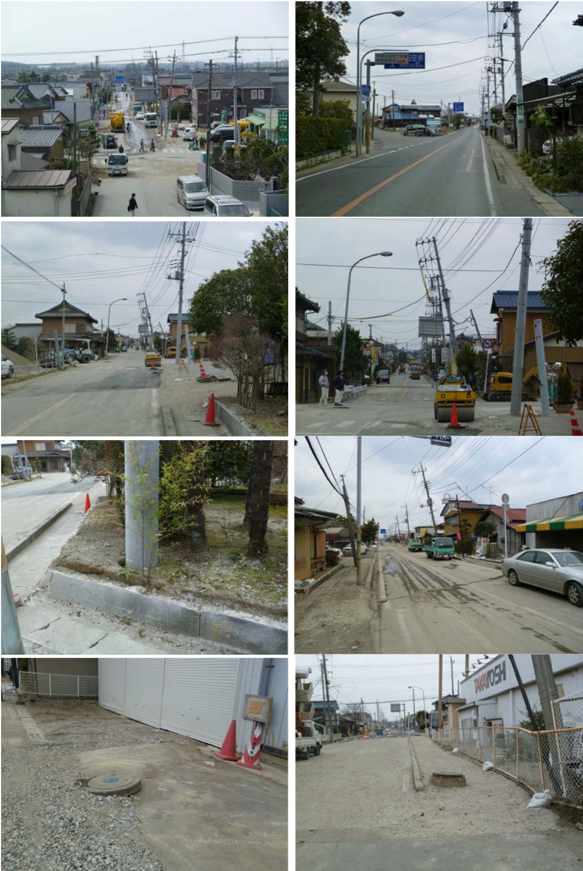
図 12 我孫子市内の液状化による被災状況
