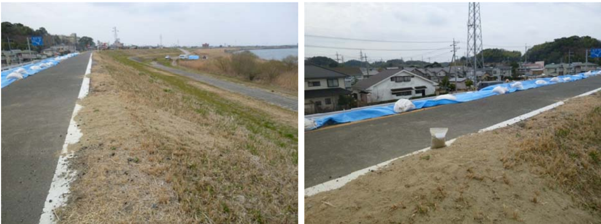
図 9 堤防天端から斜面にかけて確認された噴砂の状況，河口から 73 km 付近
