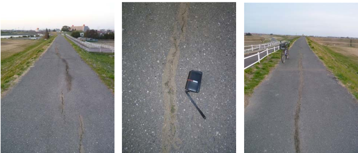
図4 小貝川堤防天端の液状化の痕跡
