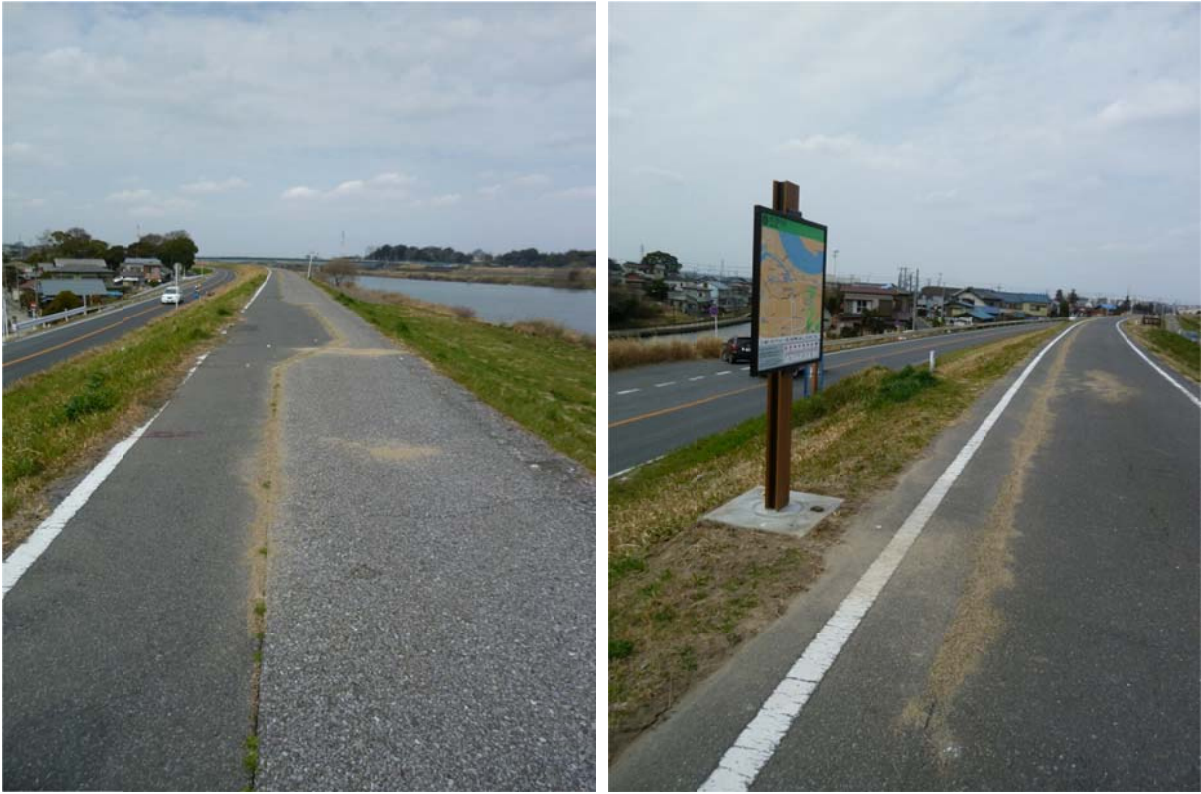
図 8 サンプル No. 2 採取地点から No. 3 採取地点にかけて堤防天端部に噴砂の確認された状況
