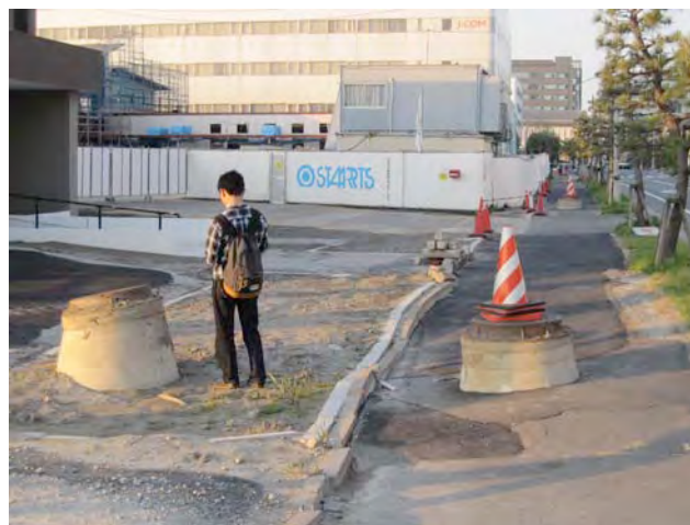
(2) マンホールの浮上
