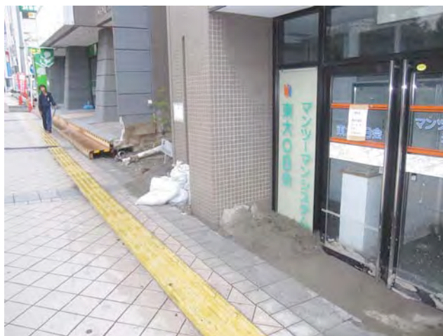
(1) 建物の抜け上がりと沈下
