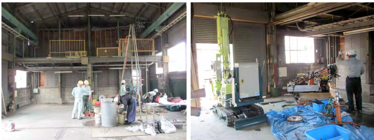
写真-3. 2. 6 大阪市鶴町の試験状況
