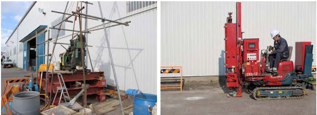
写真-3.2.3 浦安市鉄鋼通りでの試験状況
