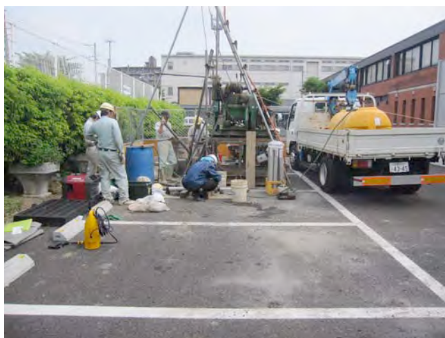
写真-3.2.1 大阪市東中浜での試験状況
