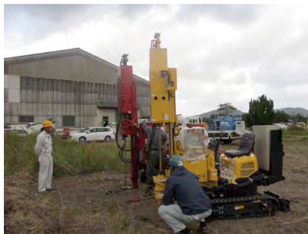
写真-3.2.9 唐津市岸山の試験状況
