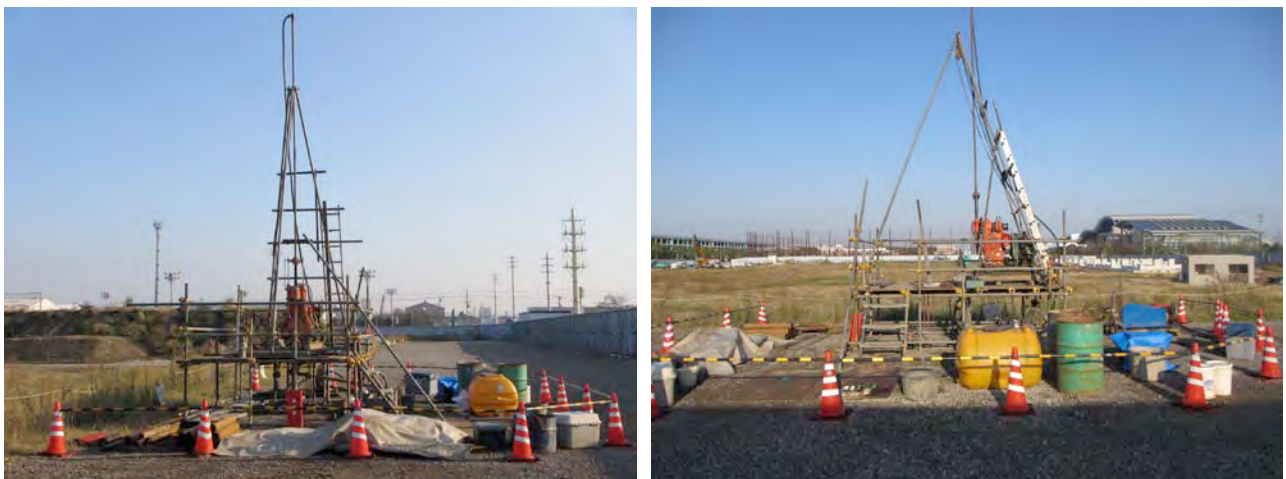
写真-3.2.3 浦安市運動公園での試験状況
