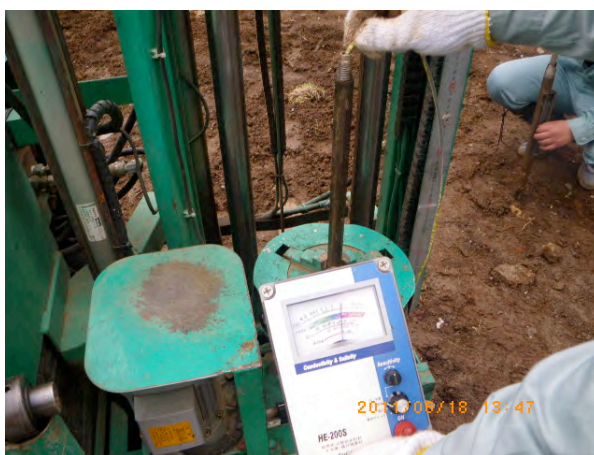
写真-4.2.5 地下水位測定状況
