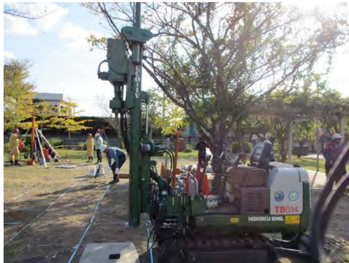
写真-4.2.8 自動式バイブロサンプリング機 (ECO-1V)
