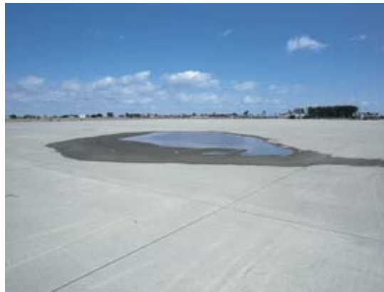
図3-2 仙台空港での地盤液状化によるエプロン部の沈下（地盤液状化未対策部）（港湾空港技術研究所提供）
