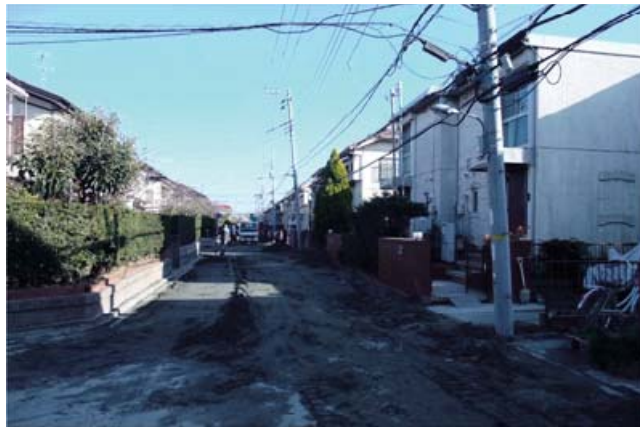
図 3-18 地盤の液状化による家屋・道路の被害(安田進)
