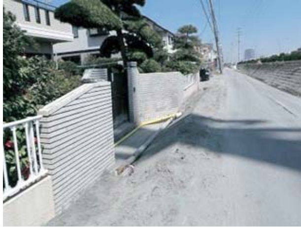
図 3-21 浦安市での宅地と道路の不同沈下（石原雅規）
