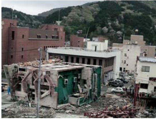
図 3-10 女川町における津波により転倒した RC 建築物（小高猛司）
