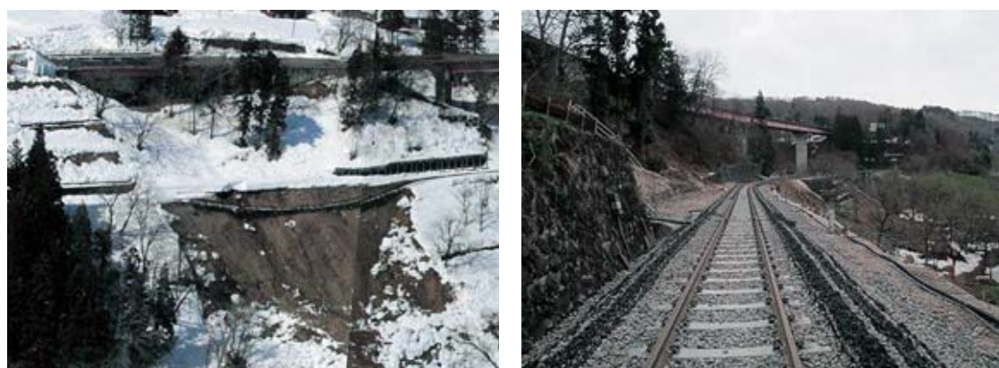
図 3-12 JR 東日本飯山線横倉～森宮野原間の盛土の崩壊と剛で一体の壁面工を持つジオテキスタイル補強土擁壁で強化復旧（JR 東日本提供）
