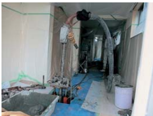
図 3-20 浦安市での CPG による地盤の直下改良 (安田進)
