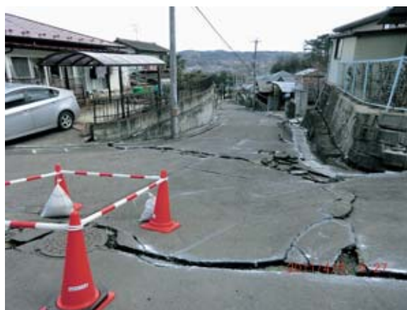
図 3-14 宅地の被災例（仙台市青葉区折立）（風間基樹）
