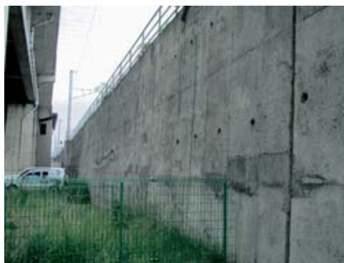
図 2-8 東北本線名取川橋梁に隣接するジオシンセティック補強土擁壁（今回の地震で無被害、岡本正広）
