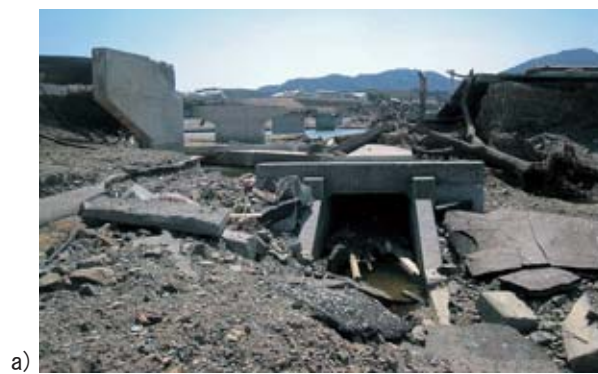
図 3-8 北上川河口部、内容：津波による越流、決壊、水門損傷）： a) 右岸 4.0 km 堤防破堤； b) 左岸 3.0 km 堤防の崩れ； c) 右岸破堤した堤防； d) 左岸 0.0 km 月浜第二水門の損傷（東北地方整備局提供）
