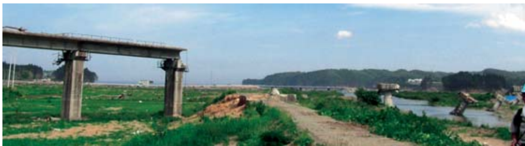
図 3-9 a) 宮城県気仙沼市本吉町津谷川左岸： 橋台上流部での河川堤防が決壊、右岸でも同様に橋台上流部が決壊。左岸の決壊幅は約 16 m であり、橋樋管などの構造物があった形跡があることから、それが弱部になり決壊した可能性もあるが、橋台上流側のみが決壊した原因は不明である。また、橋台下流側では橋台背面が浸食されていたが、それより下流側の堤防には目立った被害はみられなかった（渦岡良介）； b) 上流側か見た JR 東日本気仙沼線本吉駅陸前小泉駅間の津谷川橋梁（橋げた流失、橋脚損壊：津波は高架橋の桁を越流）（龍岡文夫）
