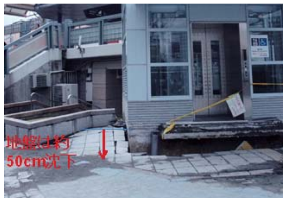
図 3-27 浦安市における地盤の液状化による地盤の沈下 (安田進)
