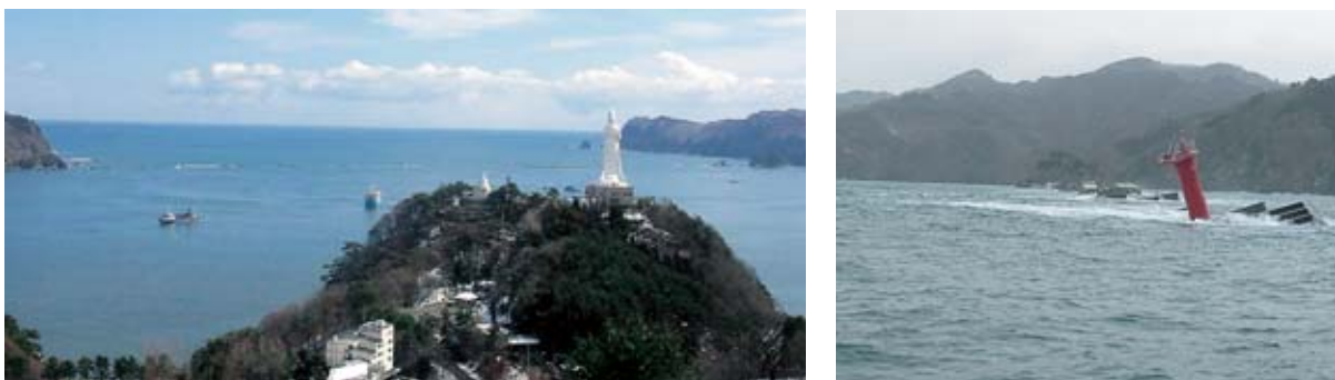
図 3-6 釜石港の津波による防波堤の被害（港湾空港技術研究所提供）
