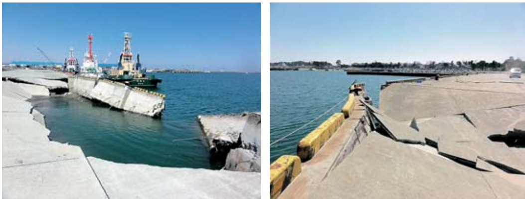
図 3-7 相馬港における矢板式岸壁の被害（港湾空港技術研究所提供）
