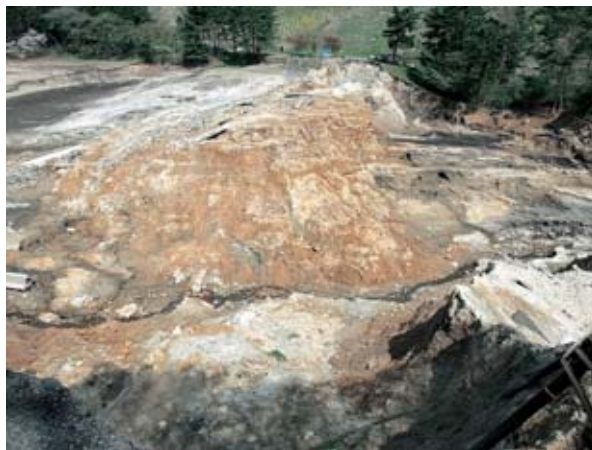
図 3-4 藤沼ダム（須賀川市）北東側の堤体決壊箇所（安田進）
