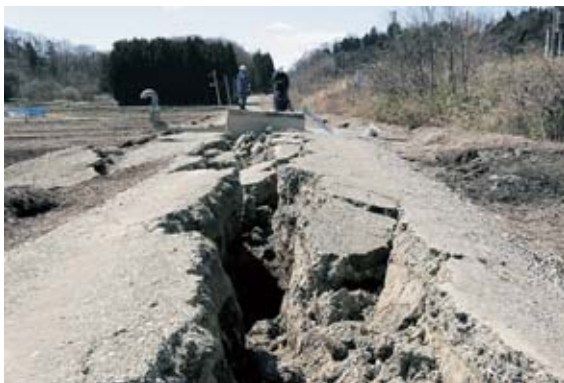
図 15 農業用幹線パイプラインの埋戻し土液状化に浮上 (毛利栄征)
