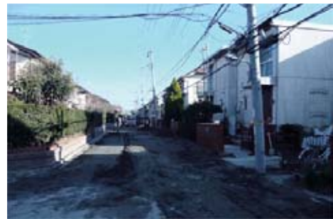
図 1 地盤に液状化が発生した推定範囲(安田進、原田健二) 図 2 地盤液状化による家屋・道路の被害(安田進)
