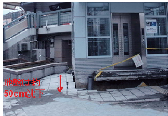
図12 浦安市、地盤の液状化による沈下(安田進)
