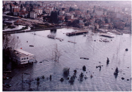
図11 トルコ・コジャエリ地震によるギョルチュックの冠水状態(安田進)
