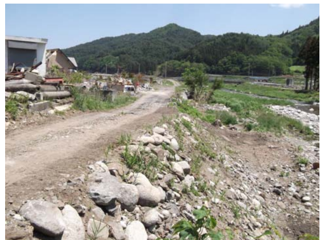
写真-33 石積み護岸の変状（熊野川左岸, 荒川橋下流50m付近）
