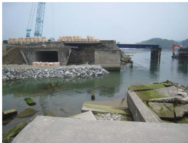
写真-2 気仙大橋橋台上流部（気仙川左岸，気仙大橋上流側）
