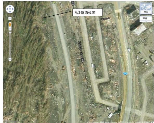
写真-10 地震後の状況 (気仙川左岸, 国道 340 号高架橋付近)
