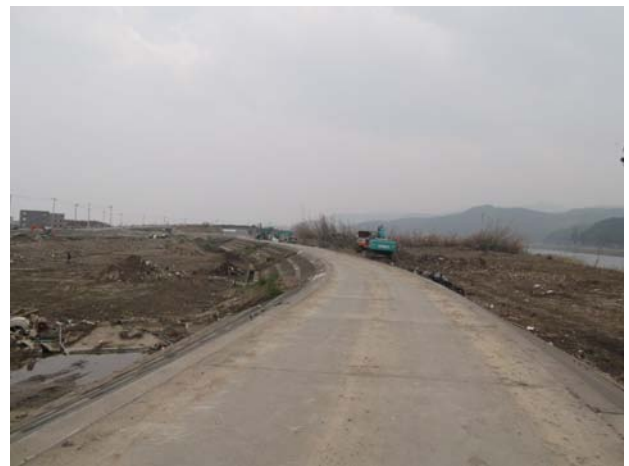
写真-11 断面計測部付近 (気仙川左岸, 国道 340 号高架橋上流約 100m 地点)
