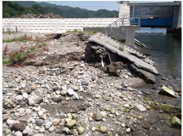
写真-27 樋門上流側の破堤(熊野川左岸, 河口水門付近, 図-11中の219, 樋門上流部)
