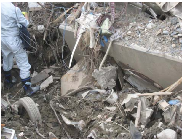
写真-13 橋台基礎杭の損傷（気仙川左岸、栃ヶ沢付近、図-5中の212）
