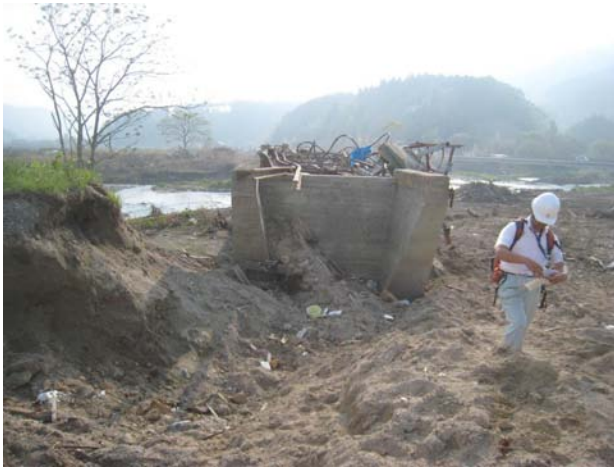
写真-22 鉄道橋台背面土の流出（鉄道橋左岸橋台の取り付け盛土）
