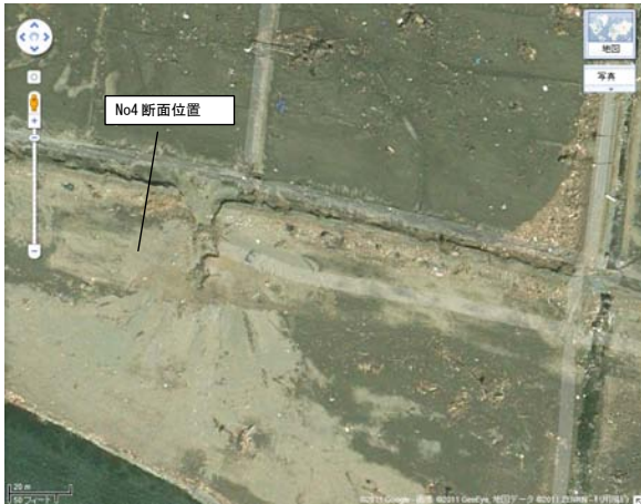
写真-17 地震後の破堤状況（気仙川左岸，竹駒駅付近）
