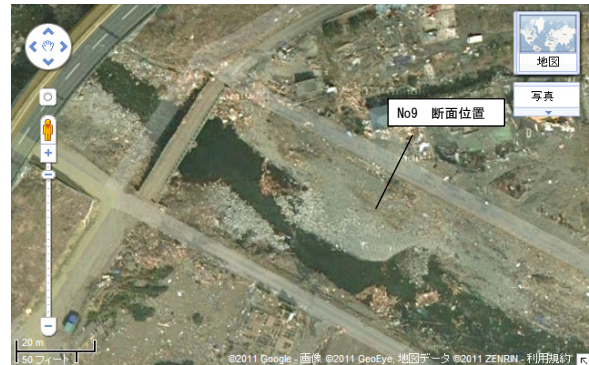
写真-32 地震後の状況（熊野川左岸, 荒川橋付近） 熊野川左岸護岸 代表断面（あらかわ橋下流50m付近）
