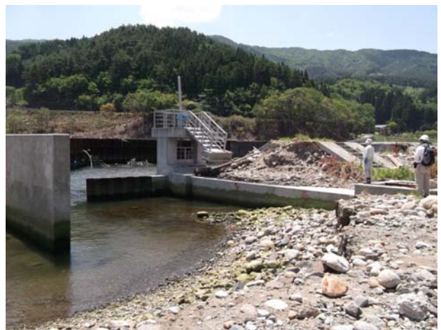
写真-28 樋門下流側の破堤(熊野川左岸, 河口水門付, 図-11中の219, 樋門下流部)
