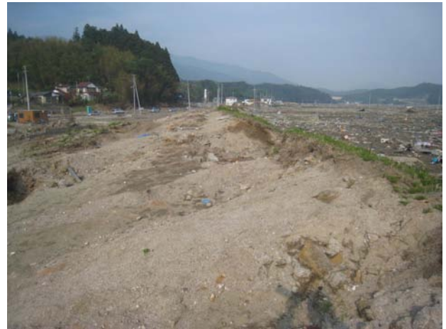
写真-21 鉄道盛土の裏のり面の侵食（鉄道橋左岸への取り付け盛土）
