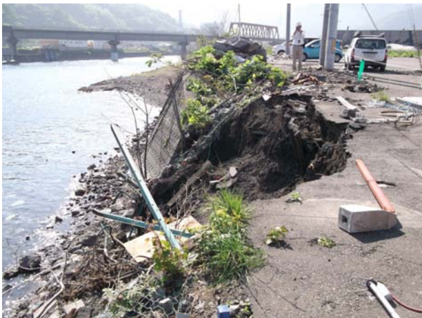
写真-43 護岸の変状 (甲子川左岸, 矢ノ浦橋付近)
