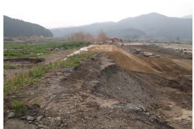
写真-16 堤体裏のり面の侵食と破堤（気仙川左岸、竹駒駅付近、図-7中の215および217）
