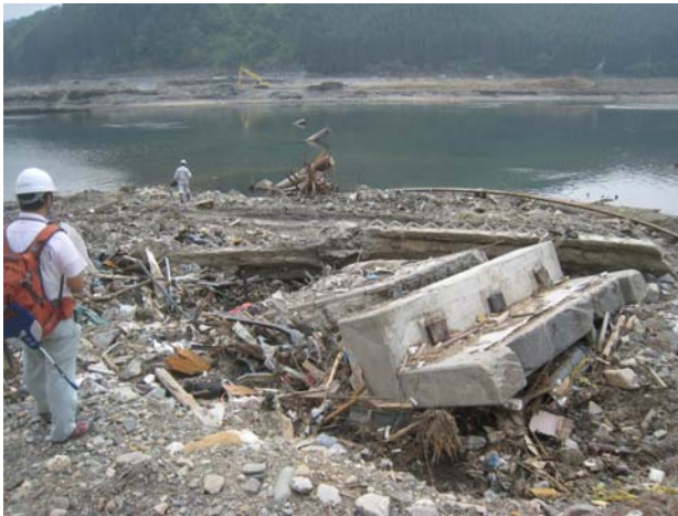
写真-12 橋脚および橋台の損傷（気仙川左岸、栃ヶ沢付近、図-5中の212）
