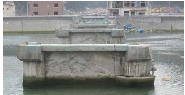
写真-6 姉齒橋橋脚（気仙川左岸）
