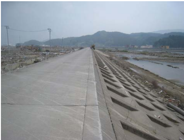
写真-9 堤防天端の削痕 (気仙川左岸, 姉齒橋上流部, 図-3 中の 211)
