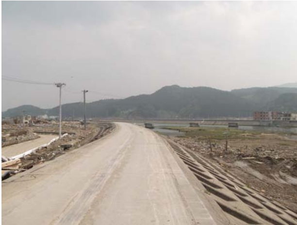
写真-8 断面計測部付近 (気仙川左岸, 姉齒橋上流部)
