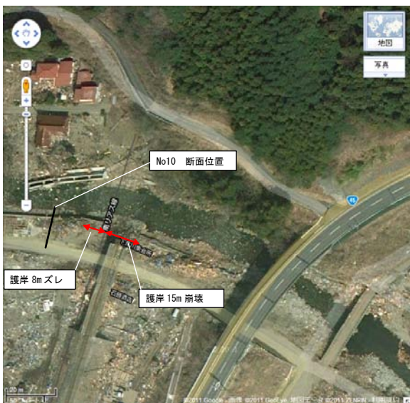
写真-34 地震後の状況(熊野川右岸, 鉄道橋付近) 熊野川右岸護岸 代表断面 (JR鉄橋下)
