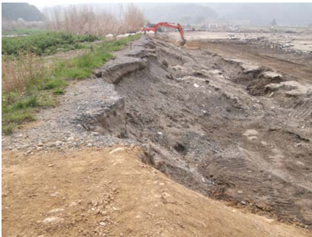
写真-18 堤体裏のり面の侵食と洗掘（気仙川左岸，断面計測位置，図-7中の216）
