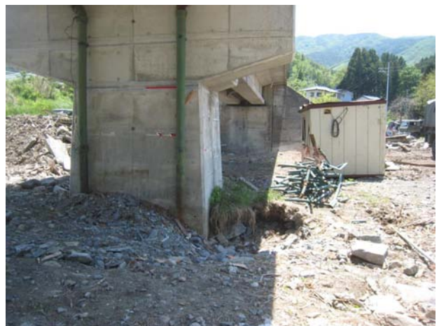
写真-37 鉄道高架橋橋脚周辺の洗掘(熊野川右岸, 鉄道橋付近)
