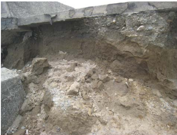
写真-4 堤体断面（気仙川左岸，気仙大橋上流部）
