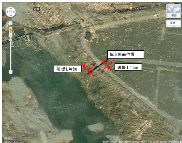
写真-23 地震後の破堤状況（気仙川左岸，鉄道橋付近） 気仙川左岸堤防 代表断面（JR鉄橋下流≒60m）
