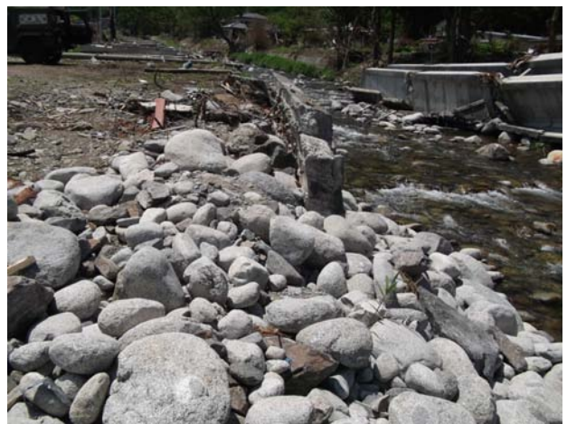
写真-36 護岸の変状(熊野川右岸, 鉄道橋付近, 図-11 中の 220)
