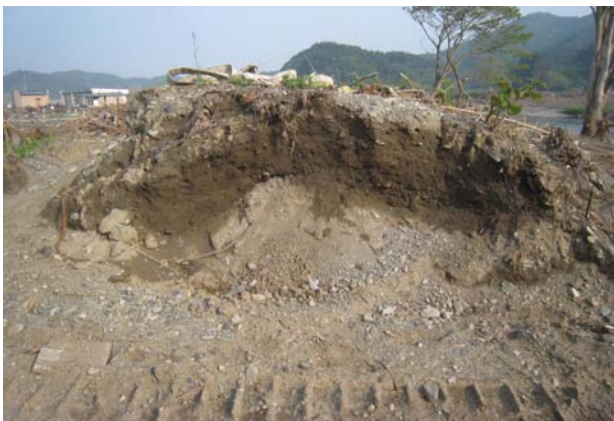
写真-24 堤体断面（気仙川左岸，鉄道橋付近）
