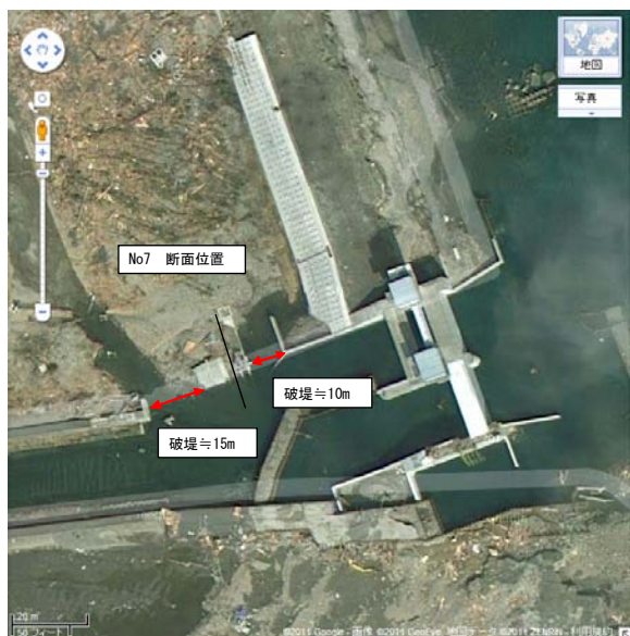
写真-26 地震後の状況(熊野川左岸, 河口水門付近)
