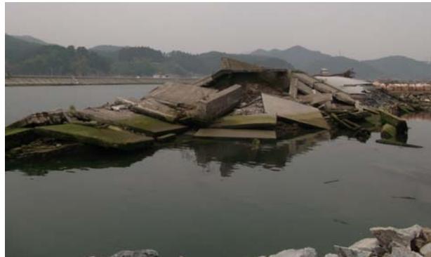
写真-1 破堤部（気仙川左岸，気仙大橋上流側）
