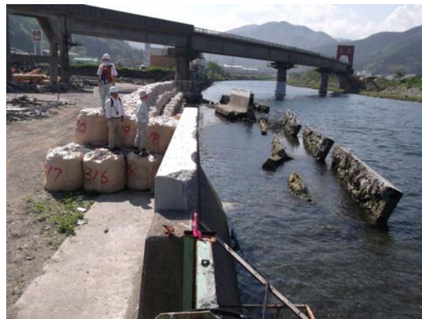
写真-40 護岸の変状(甲子川右岸, 鉄道橋付近)
