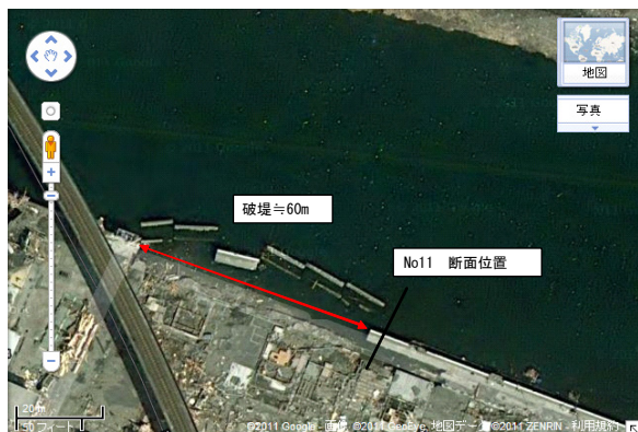
写真-38 地震後の状況(甲子川右岸, 鉄道橋付近) 大渡川右岸堤防 代表断面(JR鉄橋下)
