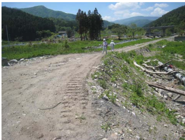
写真-31 道路橋左岸上流側
