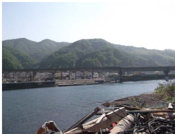
写真-39 護岸の変状(甲子川右岸, 鉄道橋付近)
