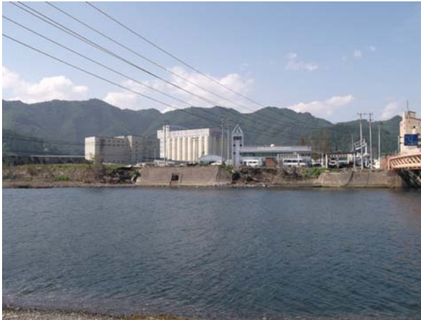
写真-42 護岸の変状 (甲子川左岸, 矢ノ浦橋付近)
