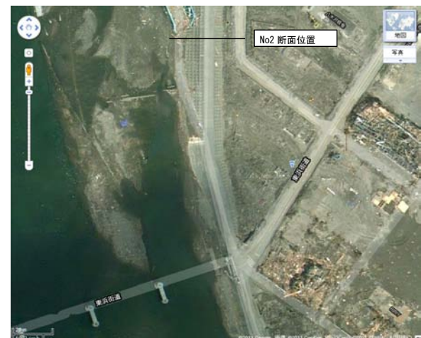
写真-7 地震後の状況（気仙川左岸，姉齒橋上流部）
