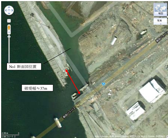
写真-3 地震後の状況（気仙川左岸，気仙大橋上流側）
