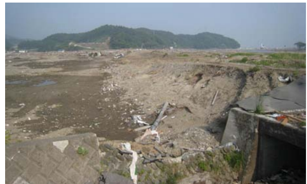
写真-15 水路東側（気仙川左岸、竹駒駅付近、図-7中の213）
