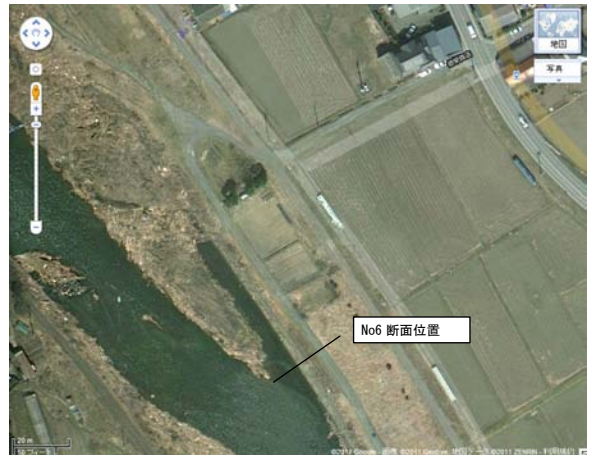
写真-25 地震後の状況（気仙川左岸，太田地区）
