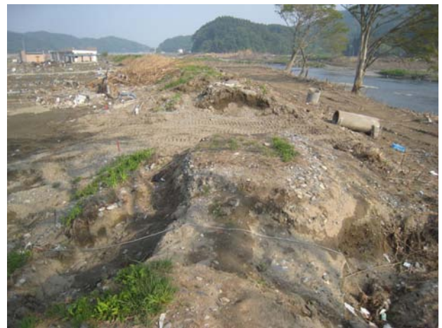
写真-20 破堤（気仙川左岸，鉄道橋下流部，図-7中の218）
