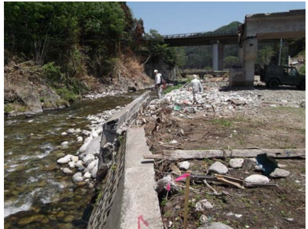
写真-35 護岸の変状(熊野川右岸, 鉄道橋付近, 図-11 中の 220)
