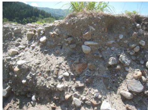
写真-29 堤体断面(熊野川左岸, 河口水門付近)
