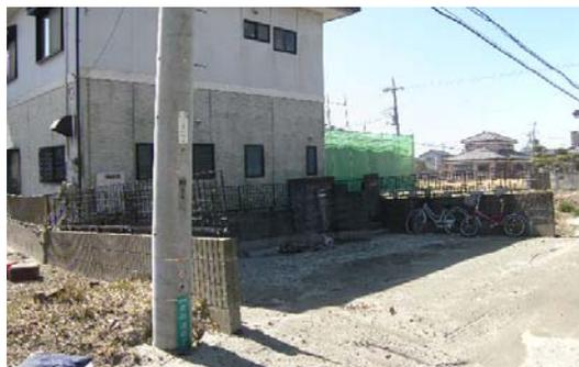
図-1.4 液状化による家屋の沈下
