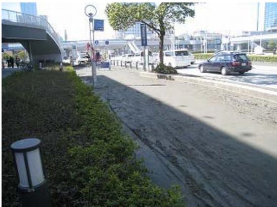
図-3 海浜幕張駅前の噴砂堆積状況
