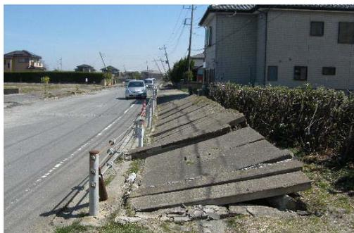
図-1.2 側溝の変状
