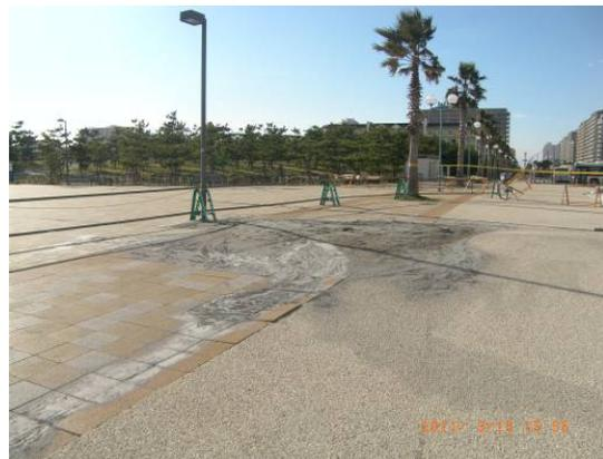
(写真) 日の出地区 最南東部の護岸付近の液状化被害
