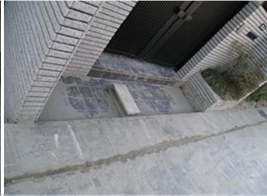
図-4 磯辺7丁目付近の住宅の沈下
