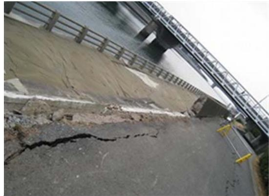
図-12 花見川右岸の擁壁の倒壊
