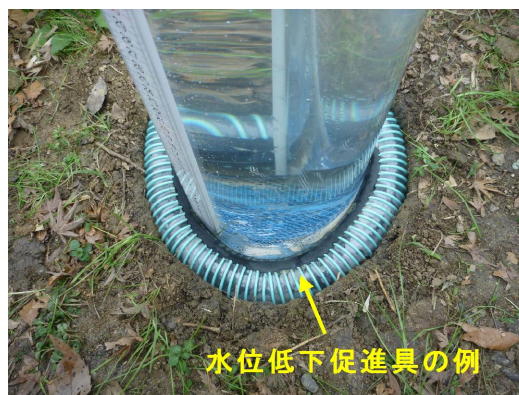
写真-3.7 水位低下促進具設置例
