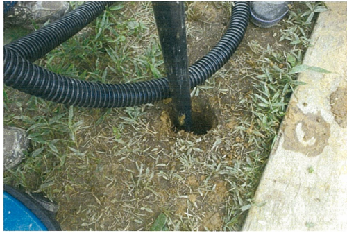
写真-3.3 掘り屑および整形土砂の吸引除去 7)
