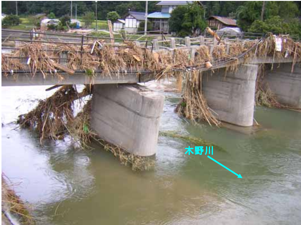
写真-2.3 侵食および氾濫による橋梁の被災（廿日市市浅原地区）
