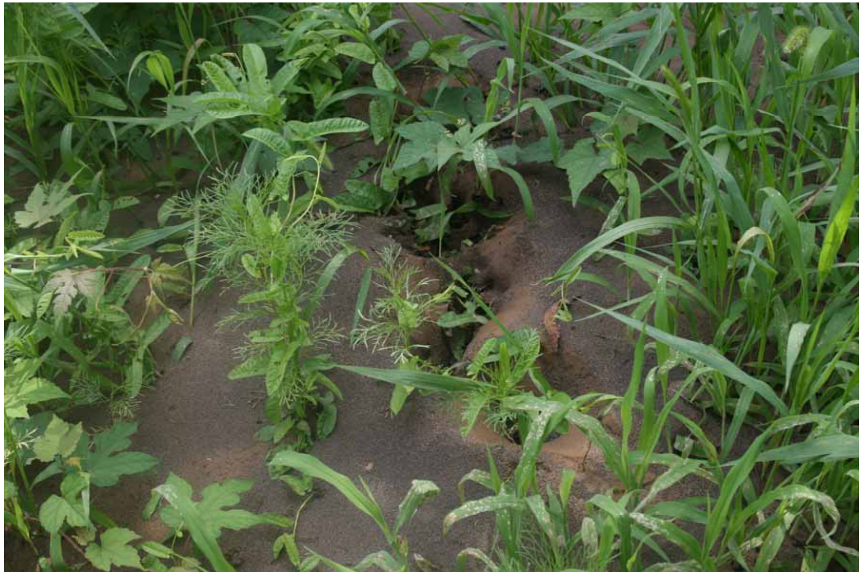
写真15 開運橋下流、右岸、旧河道を締め切った堤防の亀裂、延長20m程度
