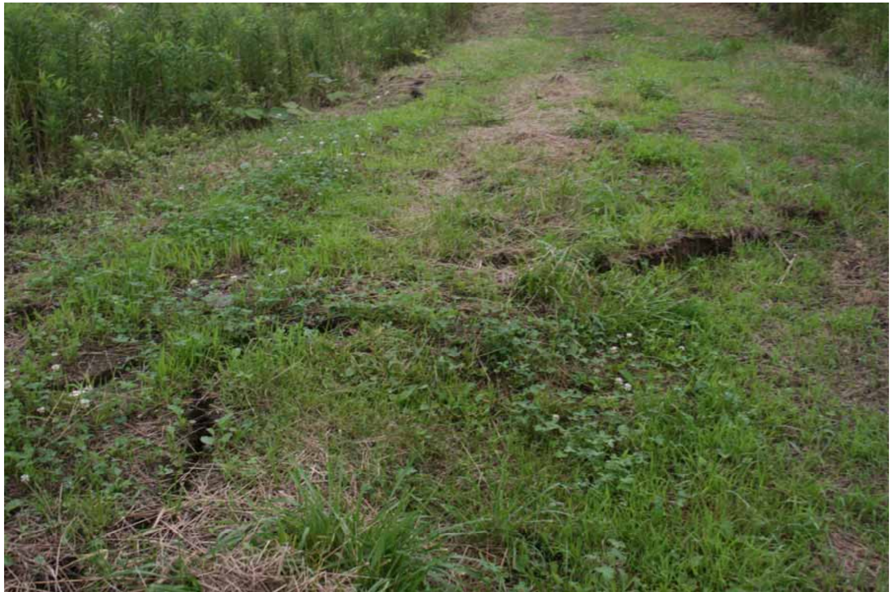
写真9 鯖石川開運橋下流左岸の堤防天端の亀裂
