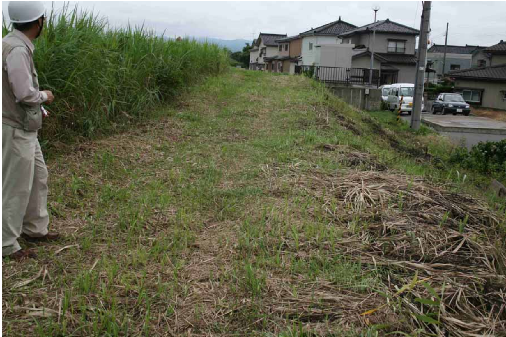
写真10 鯖石川左岸堤頂の沈下(左側が堤外)・・・堤防材料または堤防下地盤の液状化に伴う支持力不足・揺すり込みによって、手前側(開運橋側)が1m程度沈下
