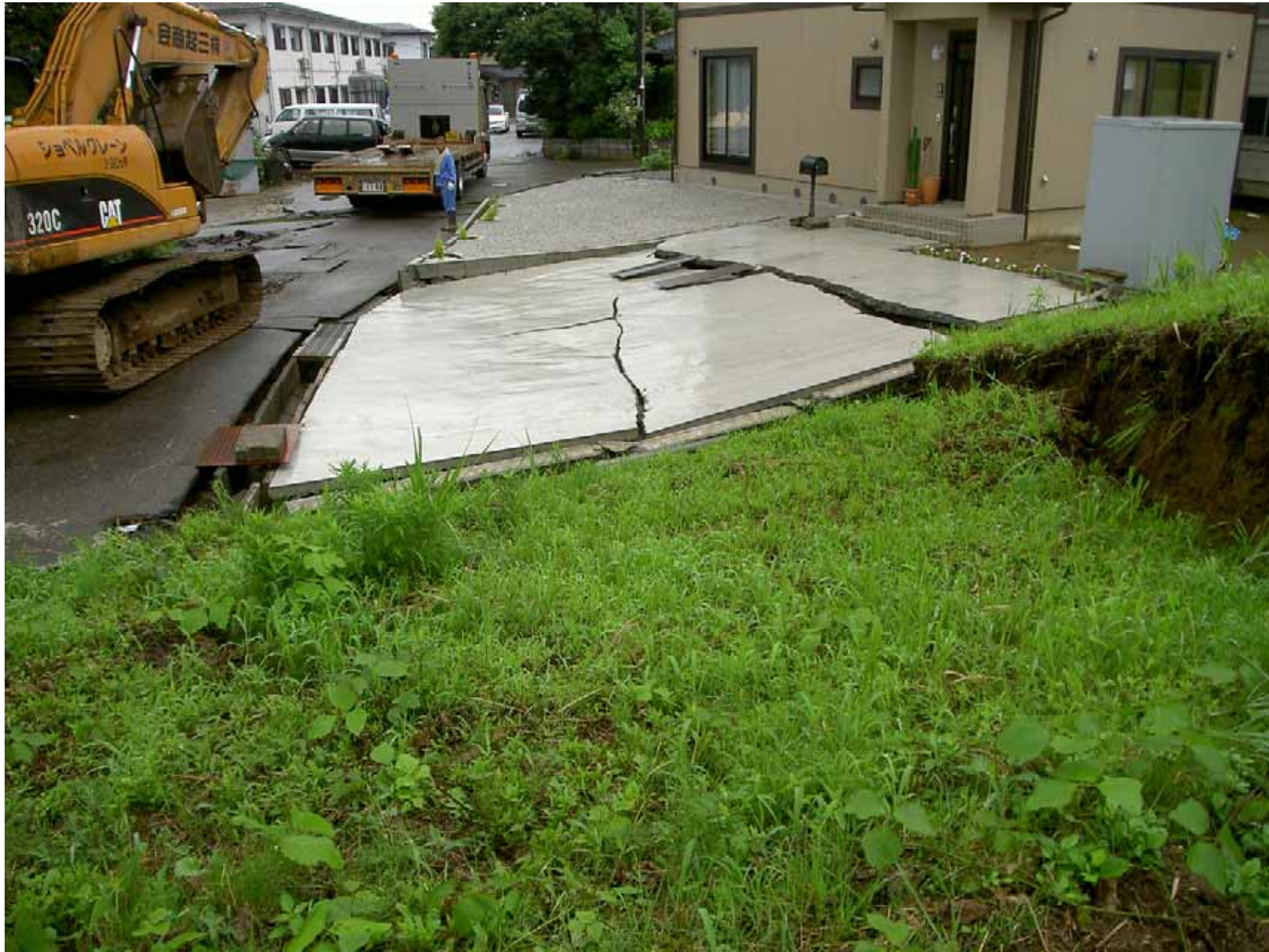
写真14 沈下した堤頂から橋場町内を臨む、前方宅地は旧河道上に立地 (新潟県柏崎地域振興局提供)
