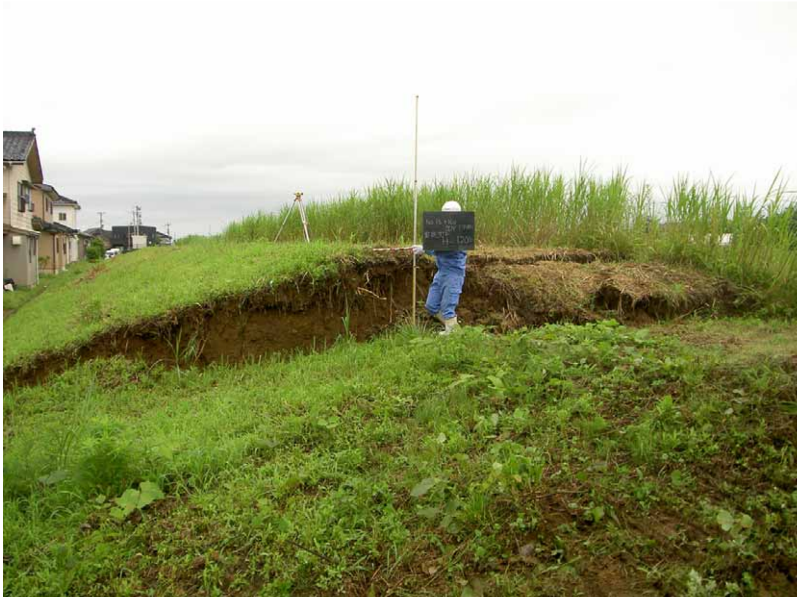
写真13 同上、この部分は左に蛇行する旧河道を締切り、直進河道に改修した箇所。締め切り堤防の締固め不足というよりも、旧河道の液状化が原因と考えられる。 (新潟県柏崎地域振興局提供)
