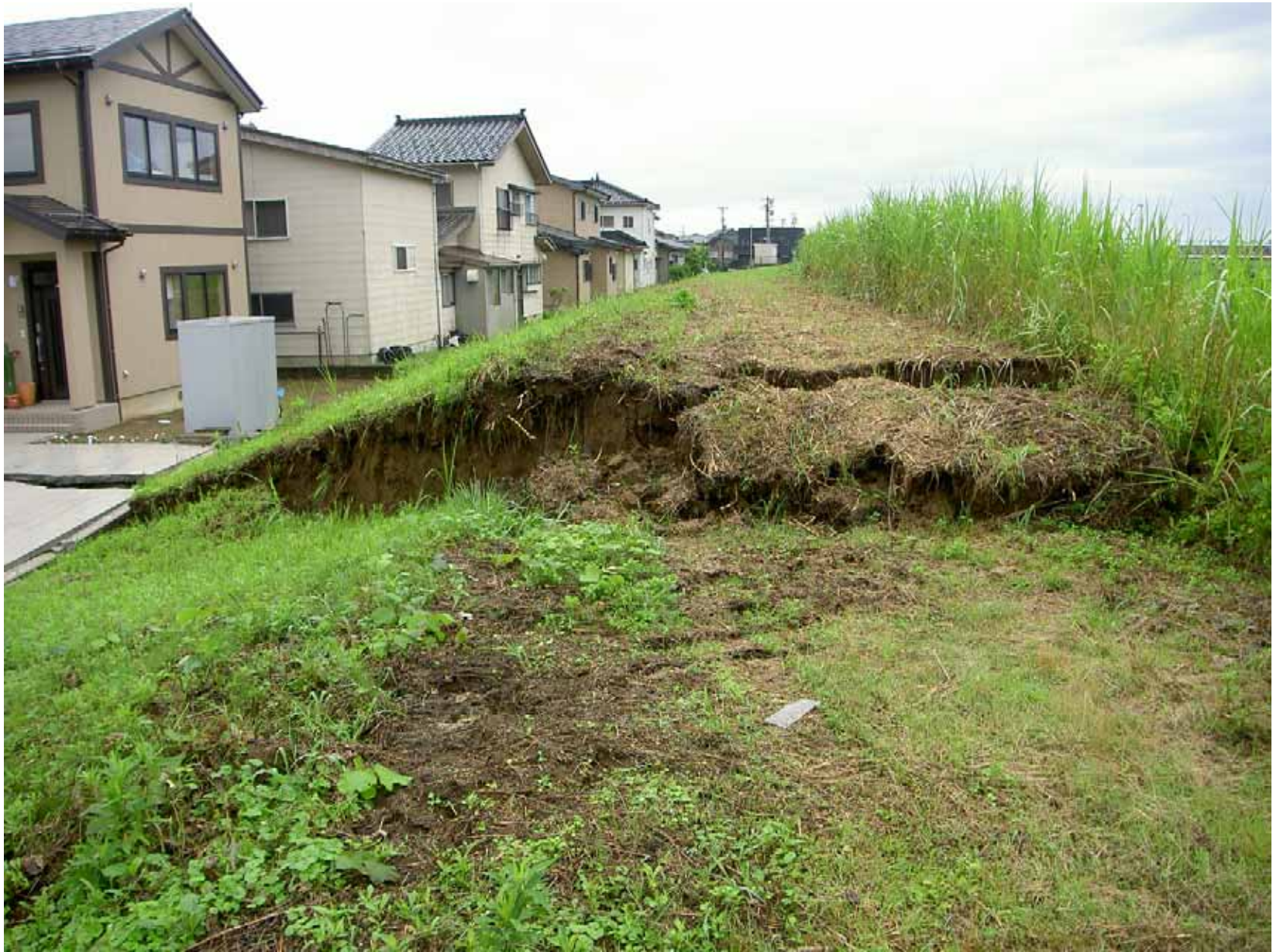
写真12 鯖石川開運橋上流100m地点、長さ50mに亘り左岸陥没(段差120cm) (新潟県柏崎地域振興局提供)
