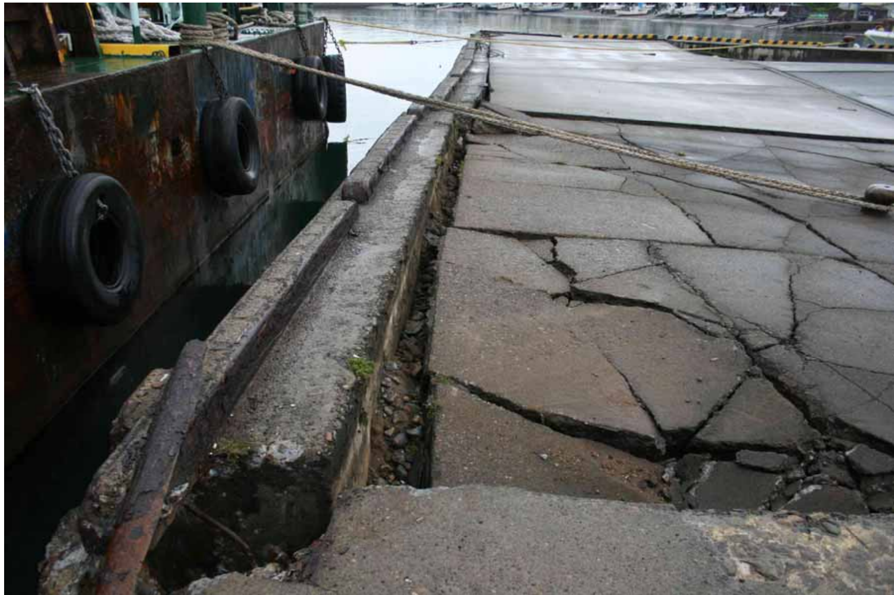
写真3 柏崎港中央埠頭中央岸壁エプロン部の沈下
