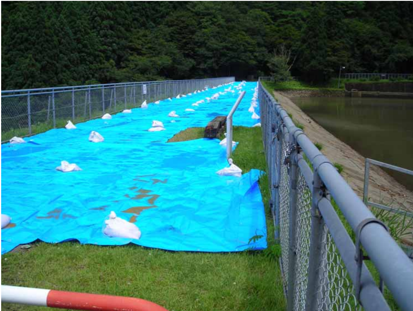
写真8 ロックフィルダムの堤体に亀裂発生
