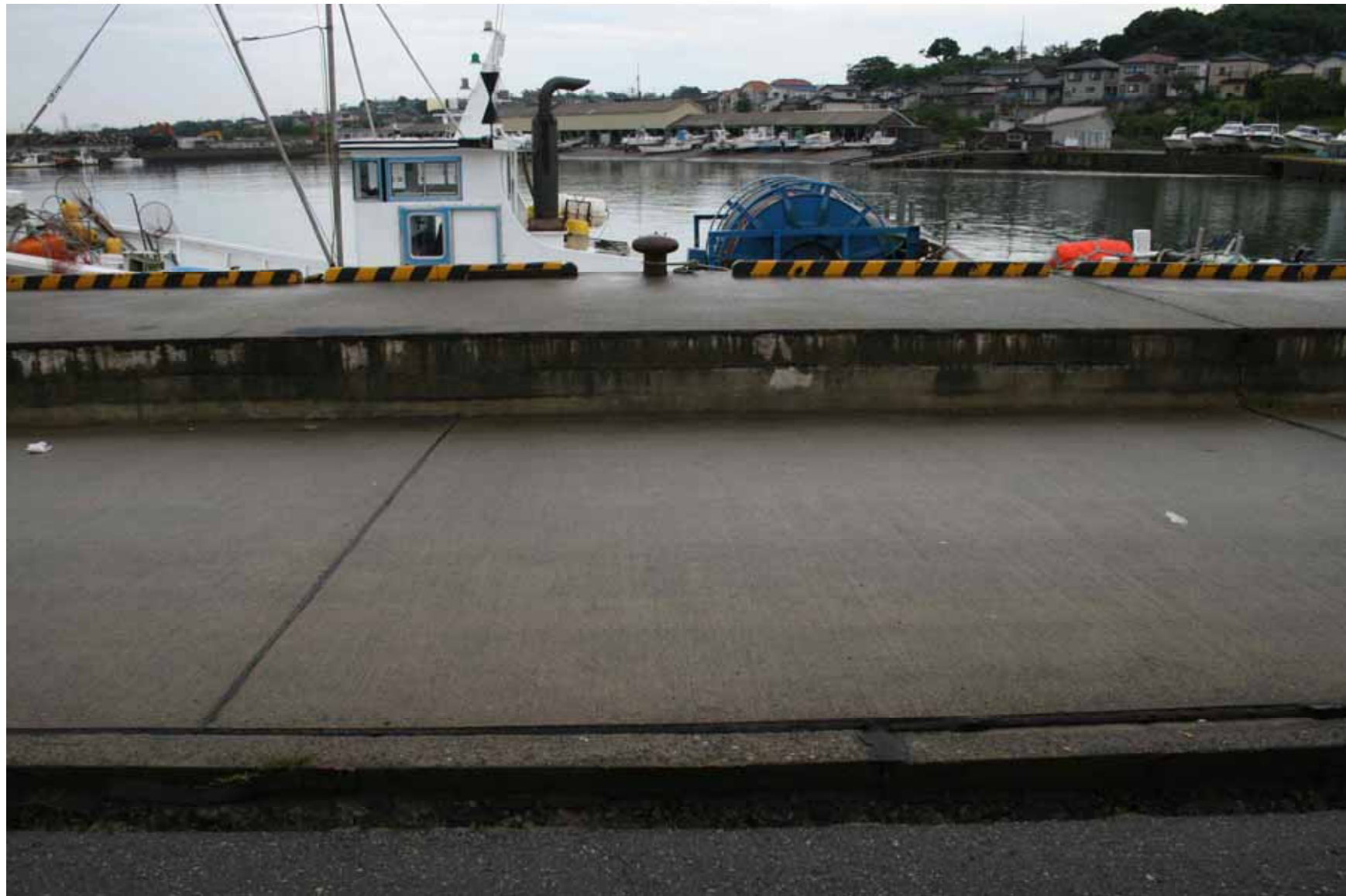
写真4 柏崎港中央埠頭東側岸壁取付護岸の海側への傾き・・・エプロン后背の沈下
