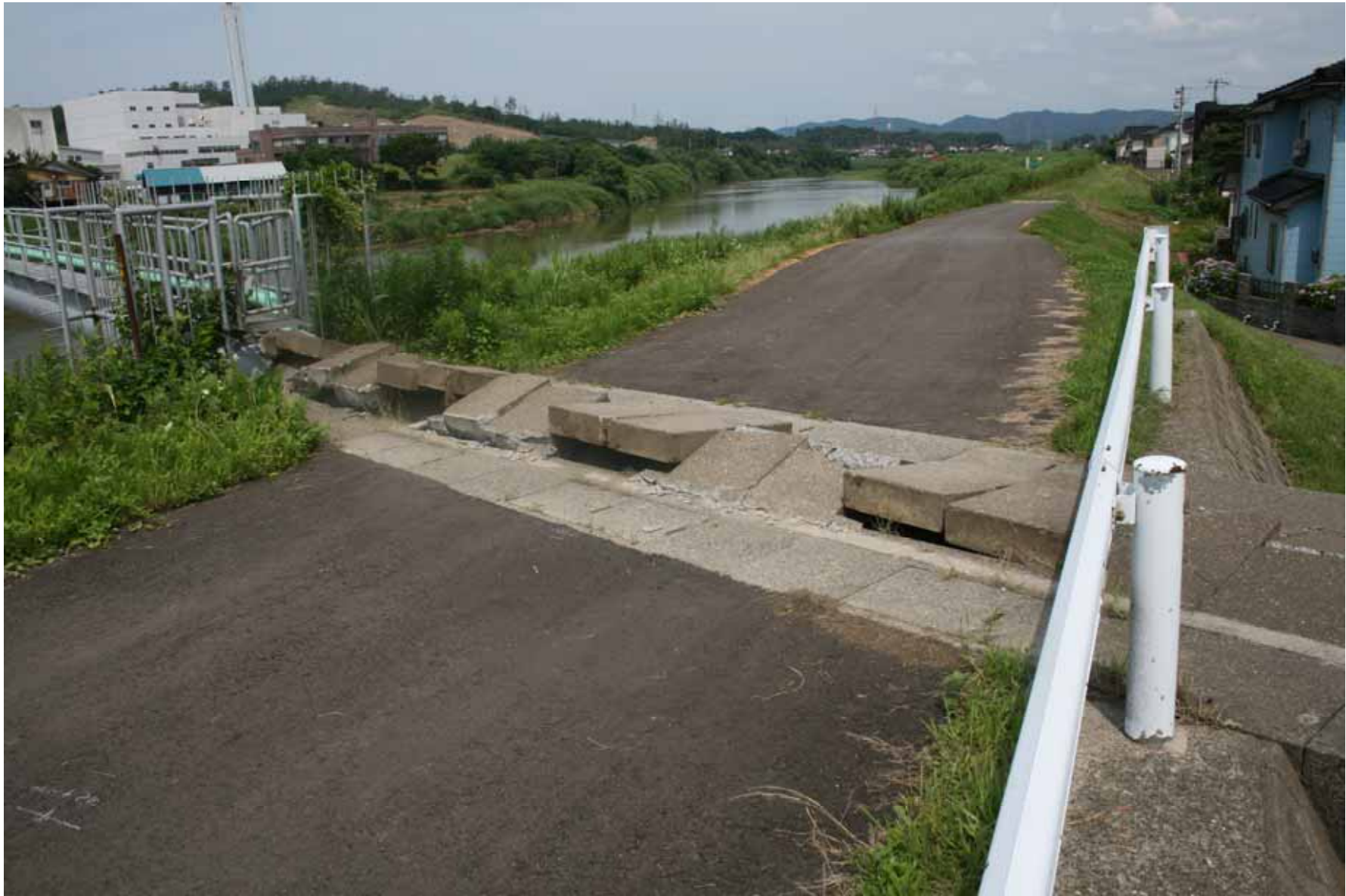
写真11 鯖石川開運橋上流、左岸。水道橋の覆工板懸垂 堤防天端が20cm沈下
