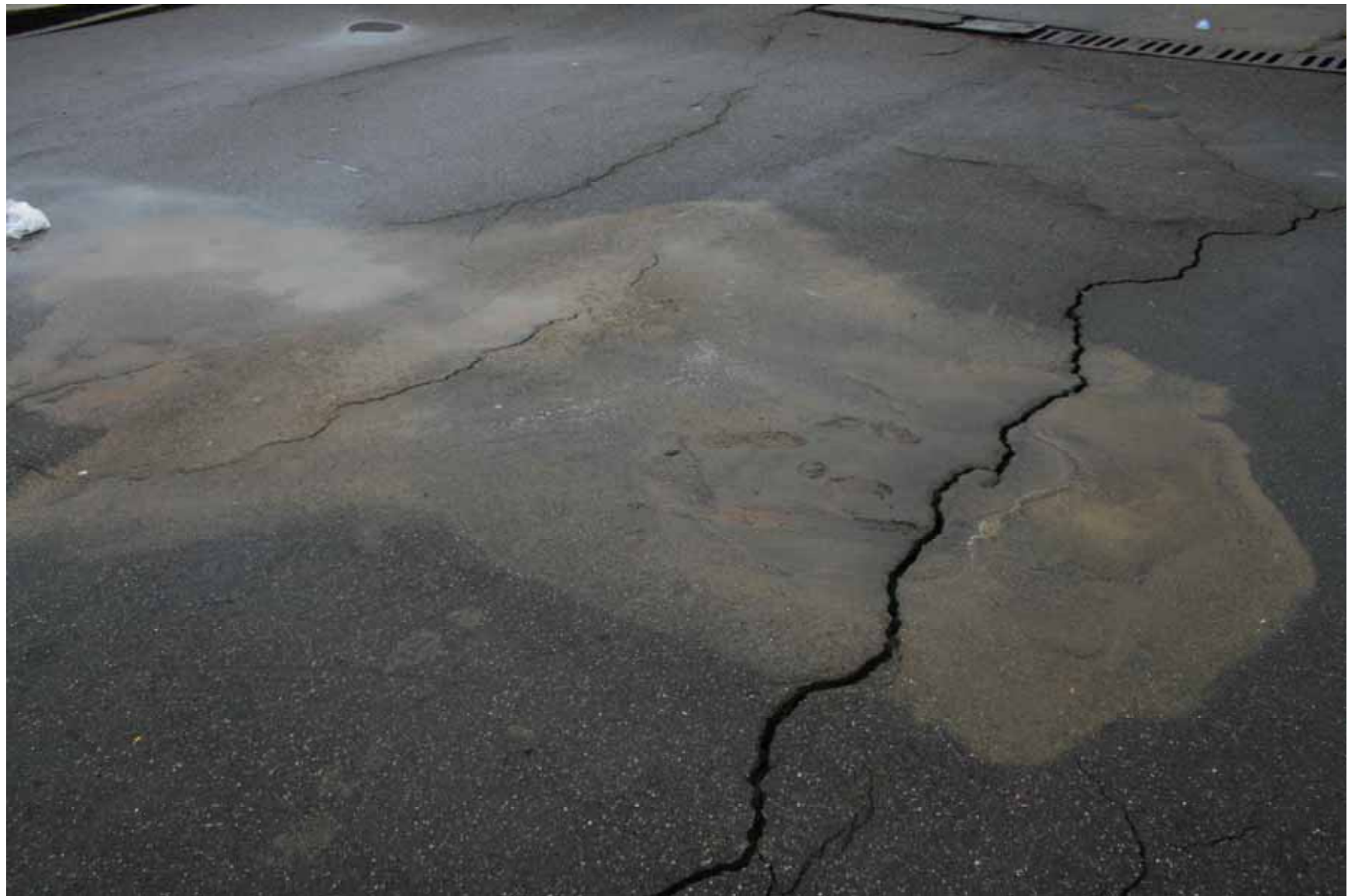
写真5 柏崎港中央埠頭中央部(後背地)の舗装下埋土の液状化痕(舗装上の噴砂)
