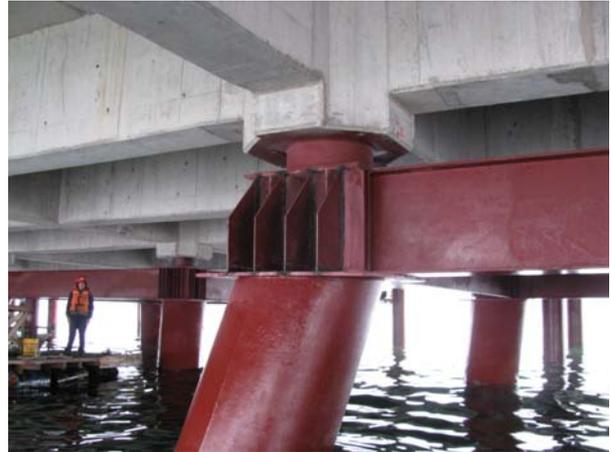
写真-7.3 斜杭で支えられたプラットフォーム上の鉛プラグ入積層ゴム支承
