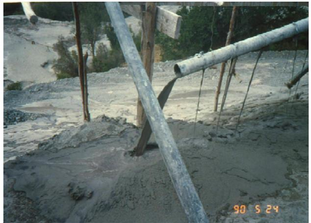
写真—9.3 鉱さいを流し込む方法 (Veta del Agua)
