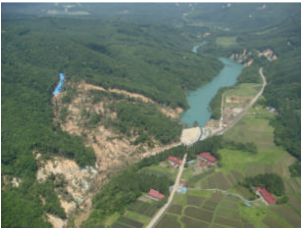
口絵写真 - 3 磐井川，市野々原地区の斜面崩壊と河道閉塞，上流側に堰止湖，堰止長約700m，左岸側に排水路（6月28日撮影）
