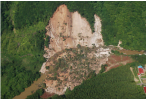
口絵写真 - 8 迫川，国道398号線，浅布地区，斜面崩壊による河道閉塞，堰止長約200m（6月18日撮影）
