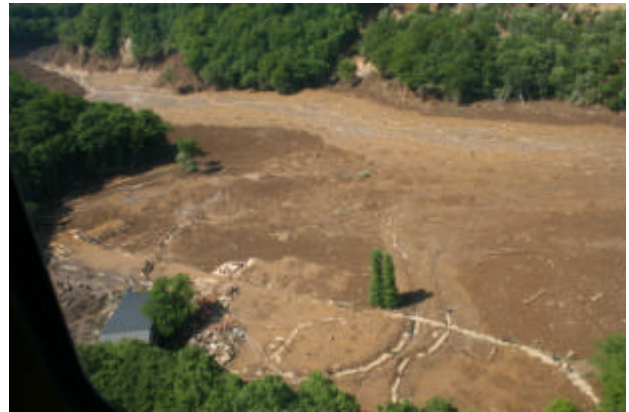
口絵写真 - 11 駒の湯温泉周辺，堆積した土砂が広がる，写真奥には現在のドゾウ沢の流路，手前には行方不明者捜索のために敷かれた足場（6月18日撮影）
