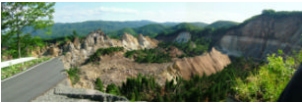
口絵写真 - 2 荒砥沢ダム上流部で発生した巨大地すべり，滑落崖付近で寸断された道路より撮影，ブロック状の移動体の側面とブロック間の陥没帯（6月15日撮影）
