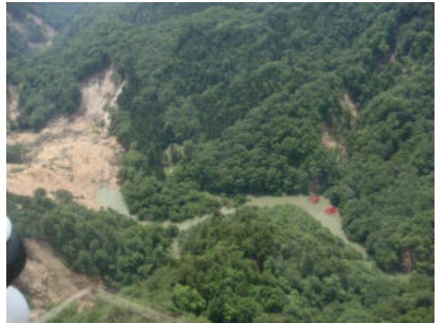
口絵写真 - 5 迫川，湯ノ倉温泉地区，斜面崩壊による河道閉塞，堰止長約700m，写真右側の堰止湖にみえる赤い屋根が2～3階建ての温泉宿であり，建物周辺の推定水位は15m以上（6月28日撮影）
