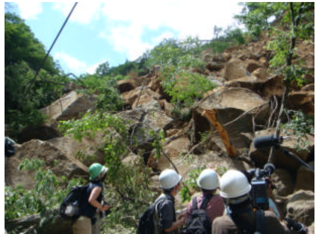
口絵写真 - 4 主要道築館栗駒公園線，岩盤斜面の崩壊による道路遮断，調査団はここで引き返した（6月15日撮影）
