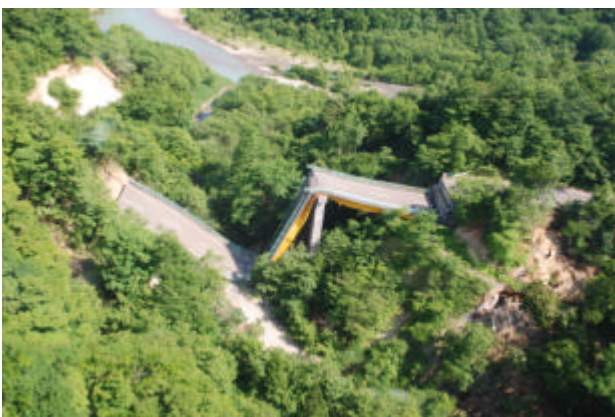
口絵写真 - 15 国道342号線，祭時大橋の落橋，左の岩手県側の橋脚が破壊，右の秋田県側の地山がせり出した可能性（6月18日撮影）
