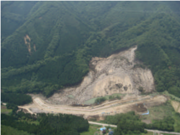
口絵写真 - 7 迫川，国道398号線，小川原地区，斜面崩壊による河道閉塞および道路封鎖，手前の道路上の崩壊土が撤去され，排水路工事が進行中（6月28日撮影）
