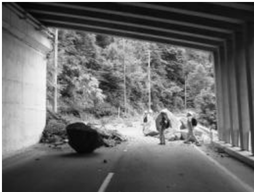
写真 - 2 落石の事例 (主要地方道 築館栗駒公園線)
