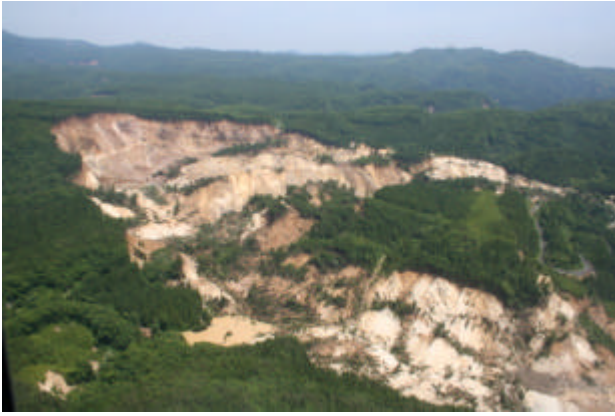
口絵写真 - 1 荒砥沢ダム上流部で発生した巨大地すべり（6月18日撮影）
