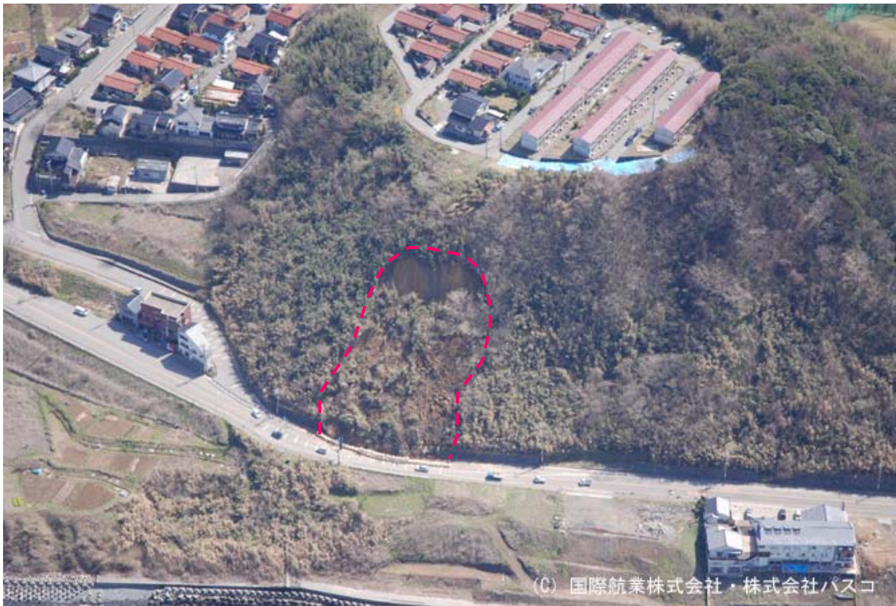
輪島市国道249大野町寅崎付近(国際航業HPより)
