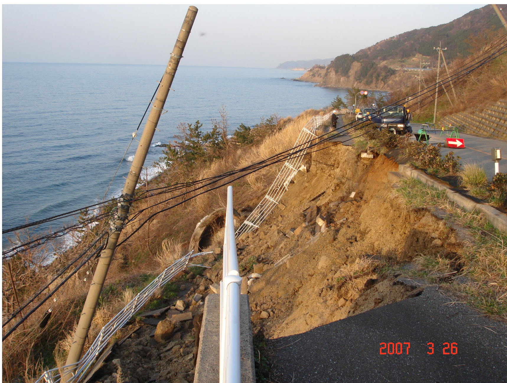
輪島市大野町寅崎付近(すり付け盛土の崩壊)
