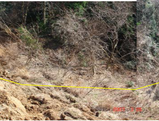
能登道路中島町谷内付近盛土崩壊(流動距離が長い)
