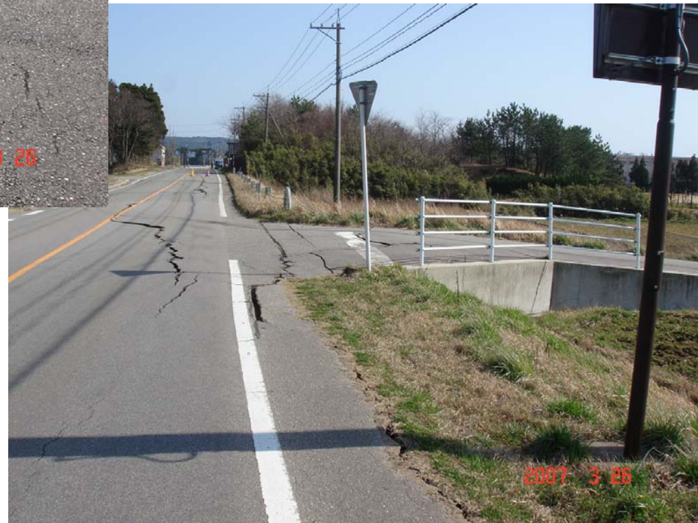
富来中浜道路盛土亀裂沈下
