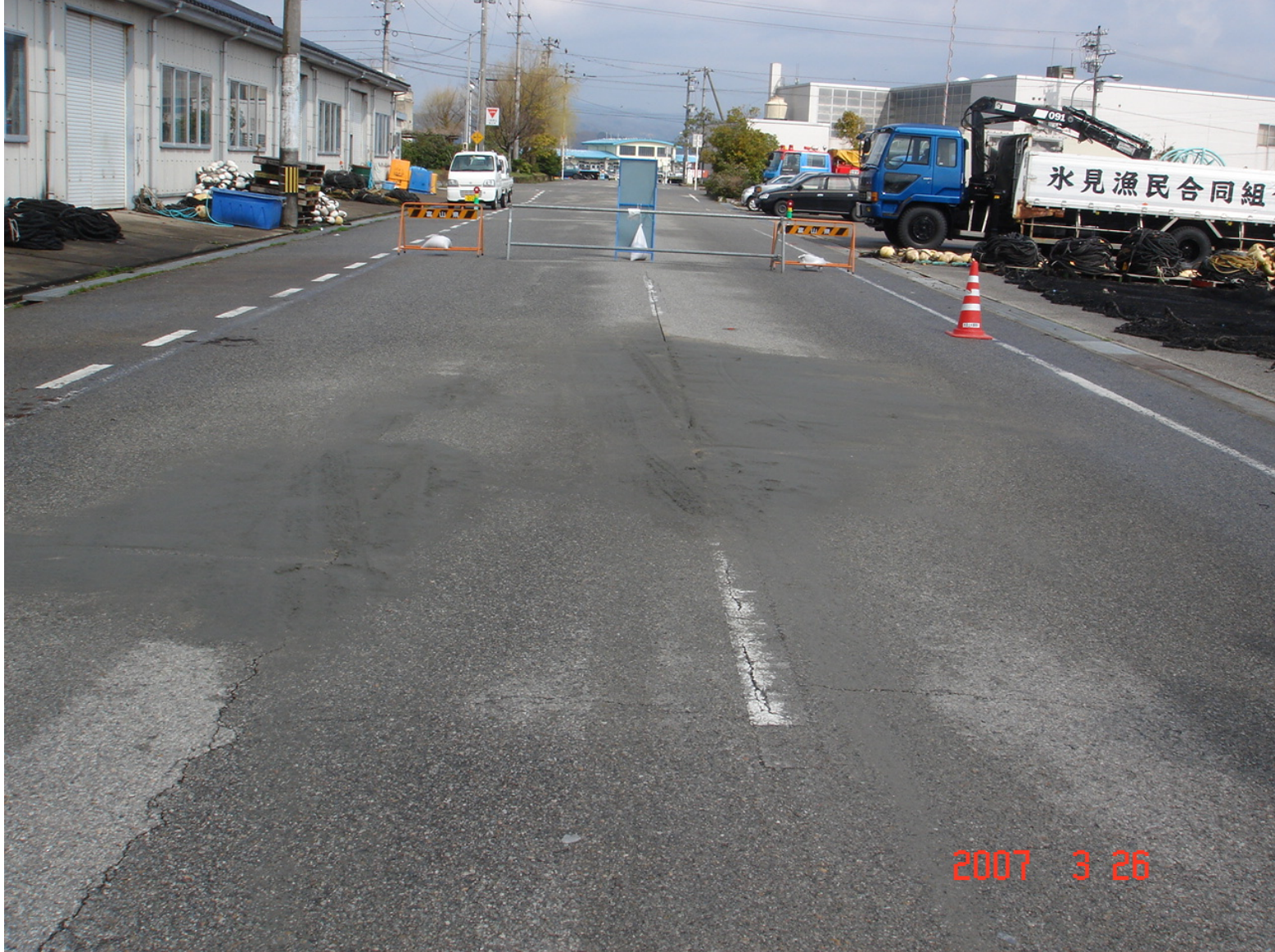
富山県氷見市氷見漁港岸壁 (背後地盤小規模液状化・目開き・沈下)
