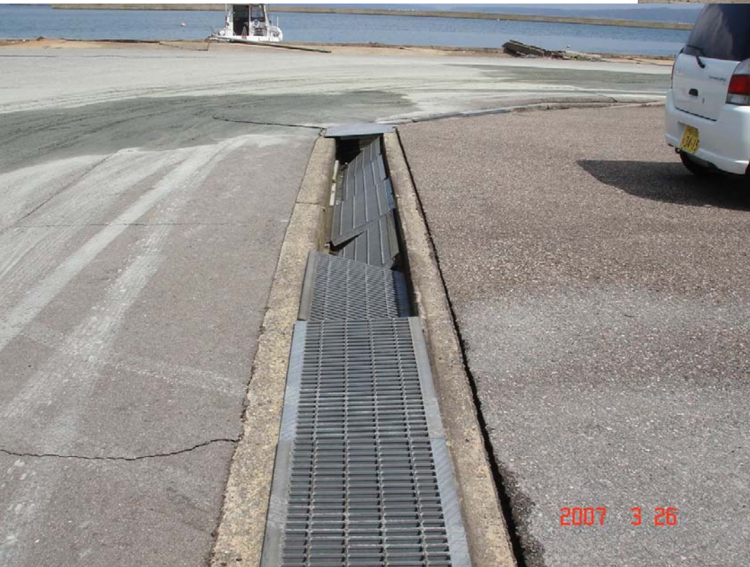
石川県七尾市七尾港岸壁 (背後地盤液状化・流動・沈下)
