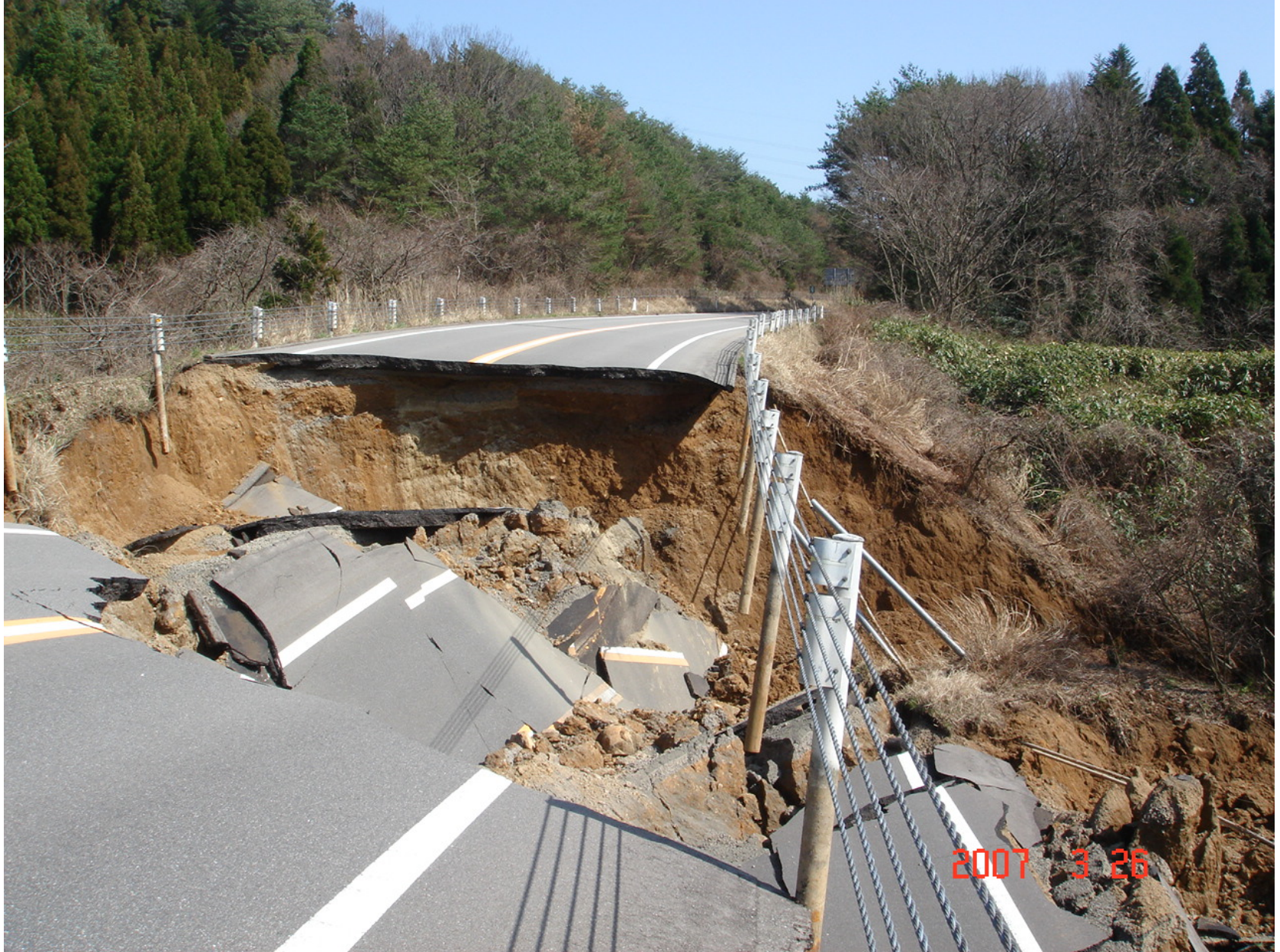
能登道路中島町谷内付近盛土崩壊(深い滑り陥没)
