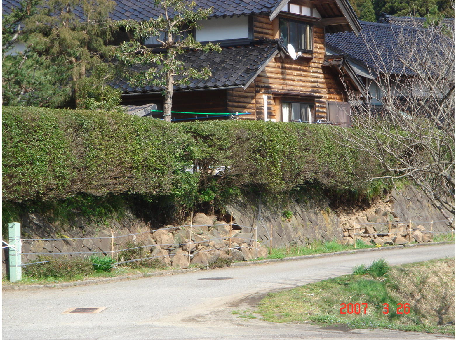
富来付近空積み石垣崩壊
