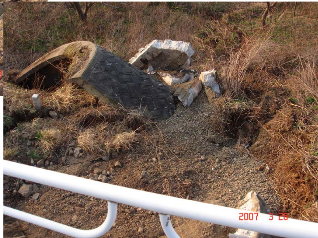
輪島市大野町寅崎付近(土留め壁倒壊)
