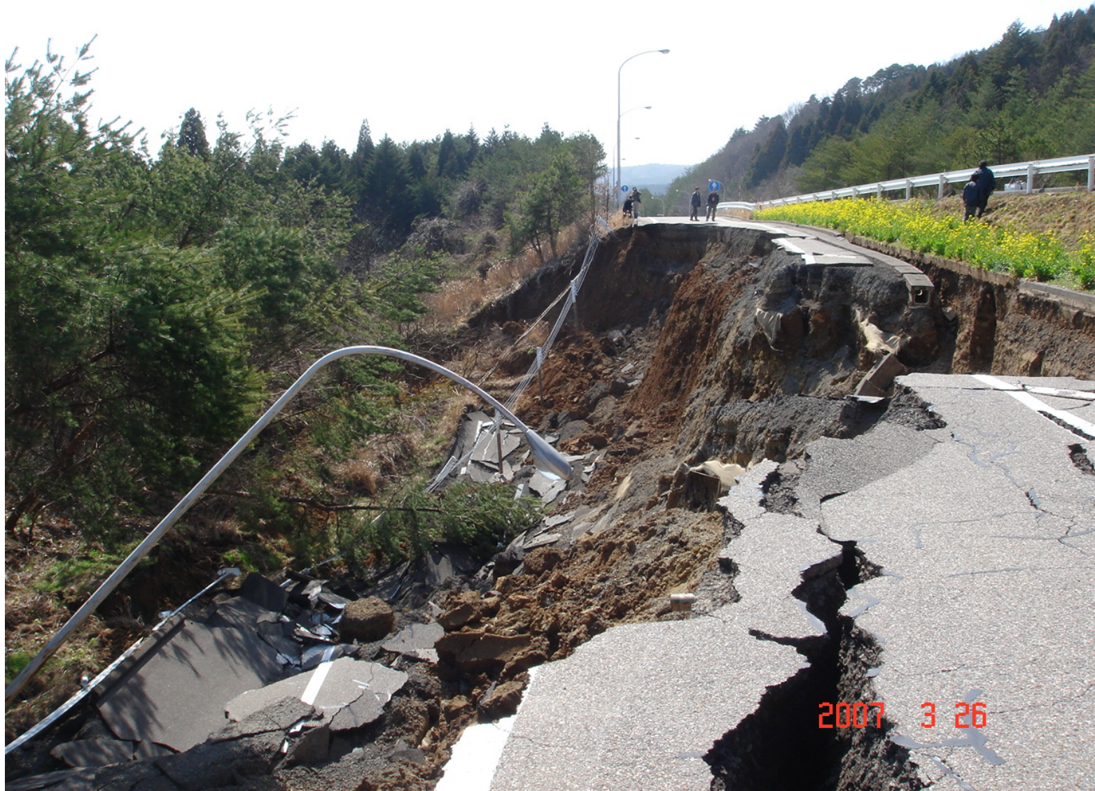
能登道路横田料金所付近盛土崩壊
