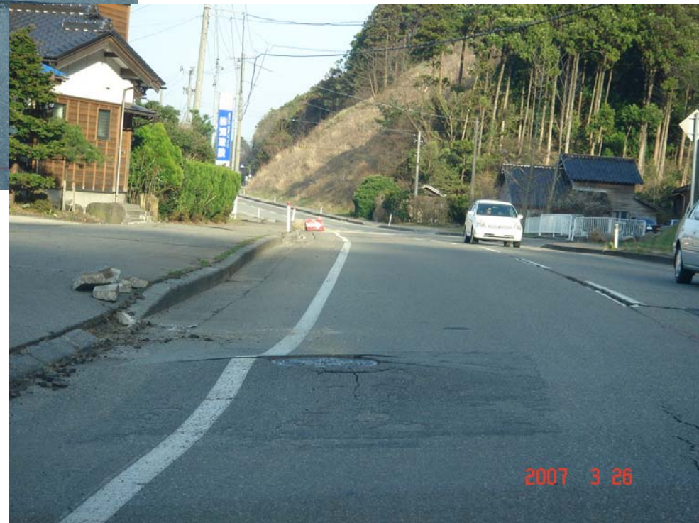
輪島市国道249下水マンホール付近段差
