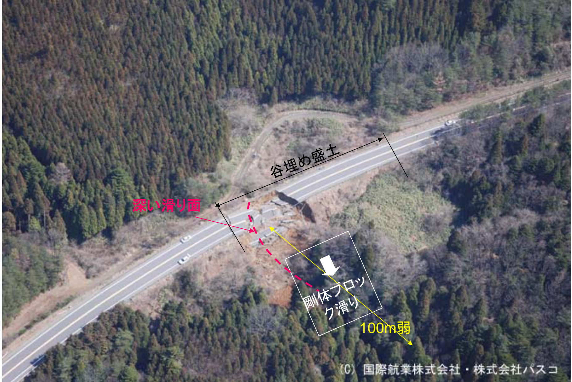
能登道路中島町谷内付近盛土崩壊(国際航業HPより)
