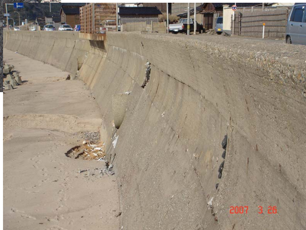
輪島市国道249海岸道路盛土の沈下
