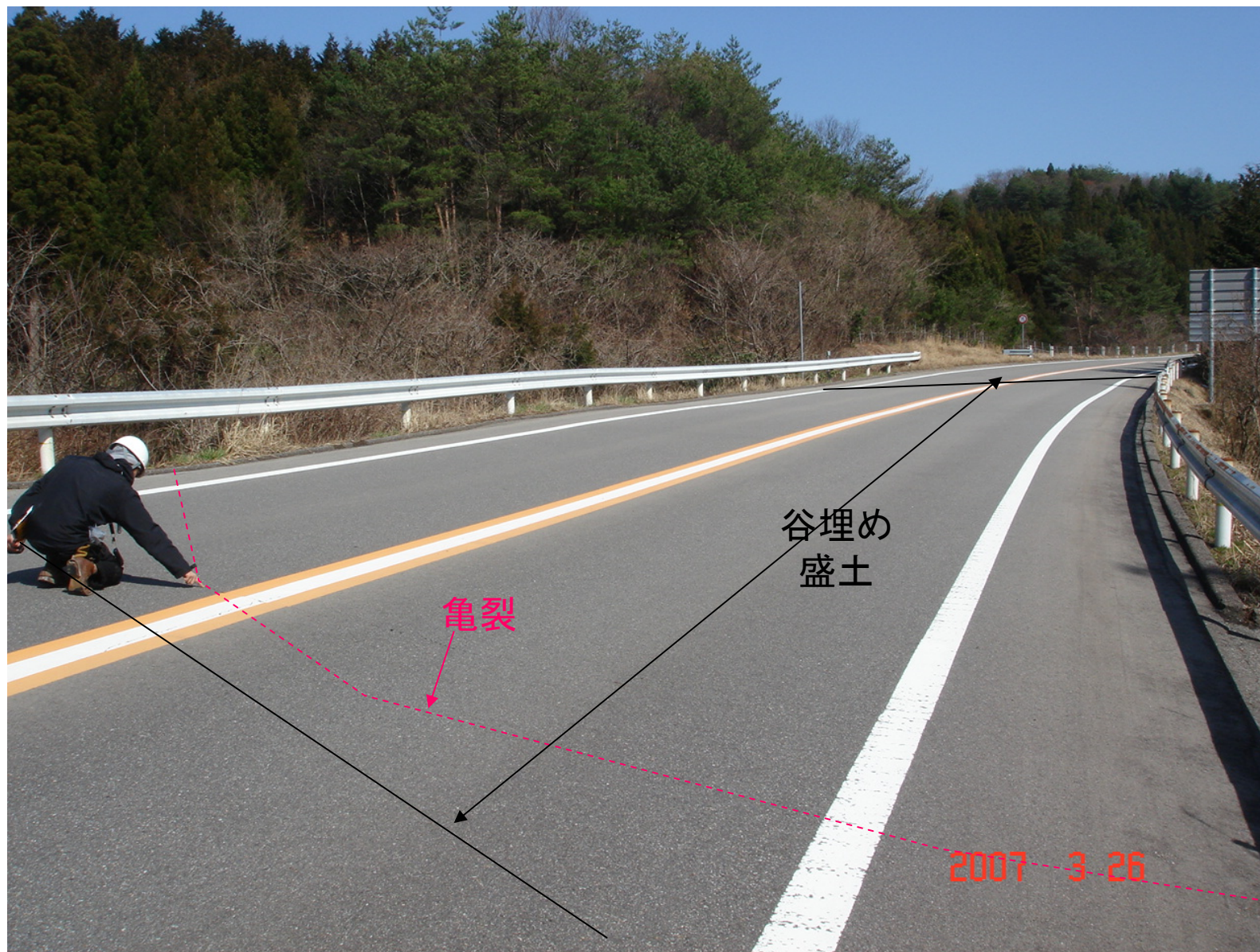
能登道路中島町谷内付近の谷埋め盛土(非破壊の例)
