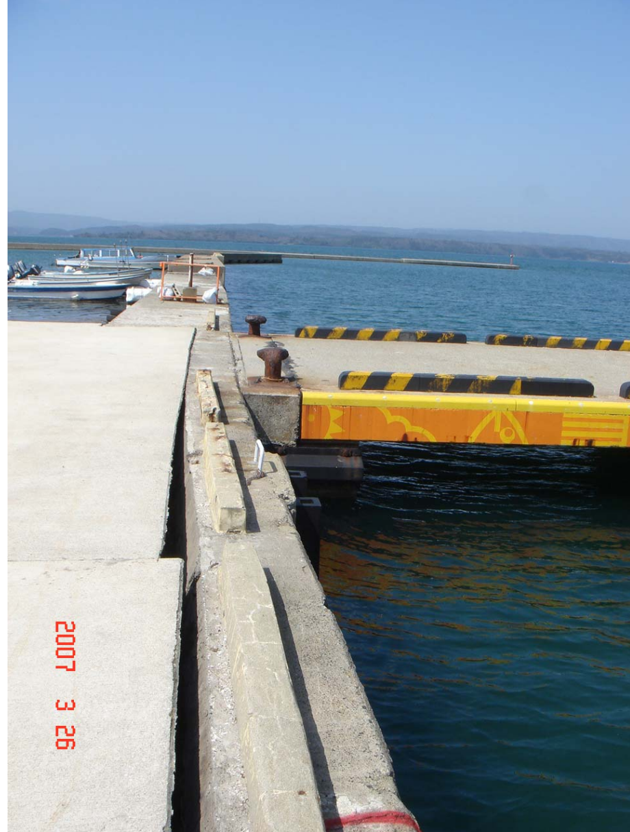
石川県七尾市和倉温泉(埋立護岸移動・背後地盤液状化・ 噴砂・沈下・流動)
