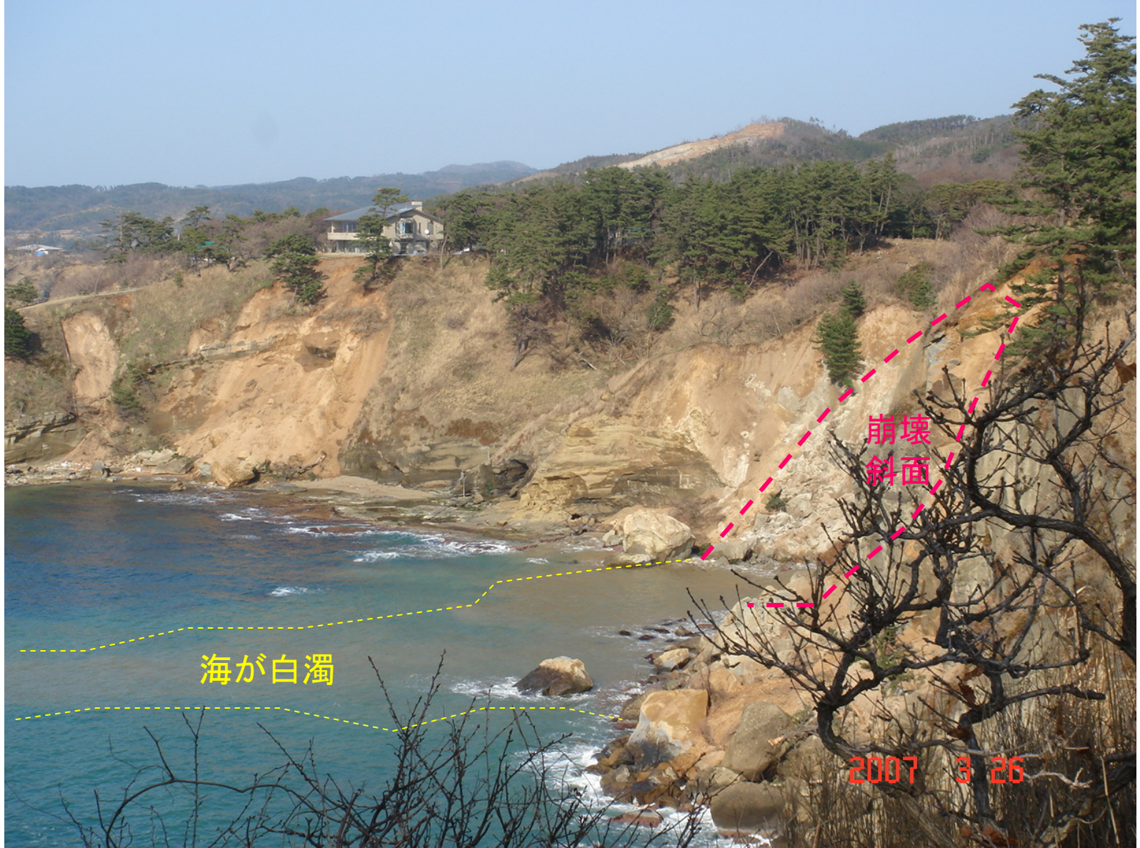
輪島市黒崎海岸斜面の崩壊
