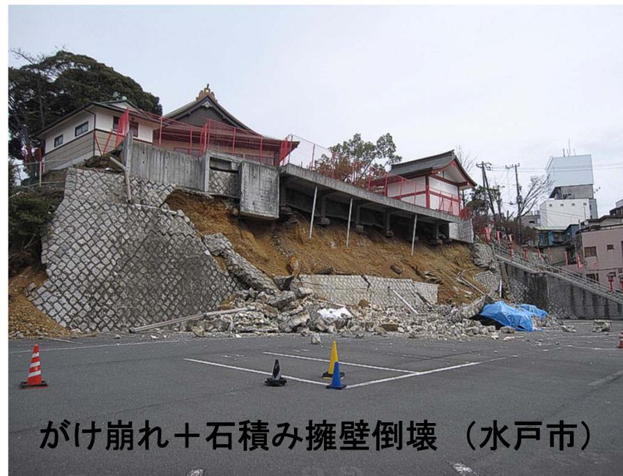
がけ崩れ+石積み擁壁倒壊 (水戸市)
