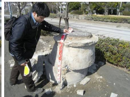
(写真) 明海地区のマンホール浮き上がり (最大 2m)
