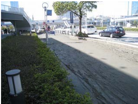
図-3 海浜幕張駅前の噴砂堆積状況
