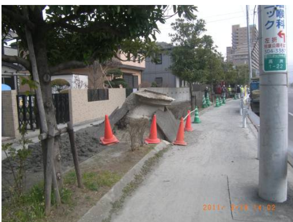
(写真) 高洲地区：(左) マンホールの浮き上がり(最大 1.5m)、(右) 小学校校舎の不陸(最大 60cm)
