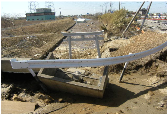
図-3.1 水路の変状
