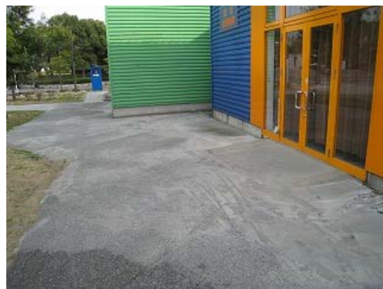
図-6 海浜幕張駅裏レストランの噴砂
