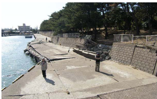
図-2.1 すべり破壊による岸壁のはらみ出し
