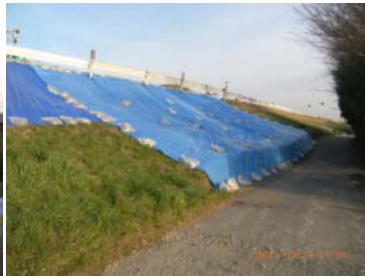
(写真) 利根川堤防の一部に亀裂。応急措置中。
