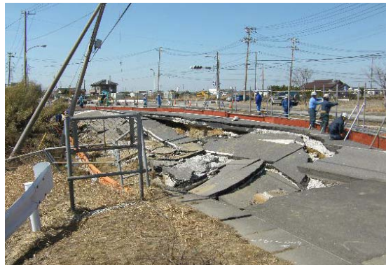
図-3.2 崩壊した道路
