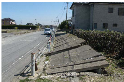
図-1.2 側溝の変状
