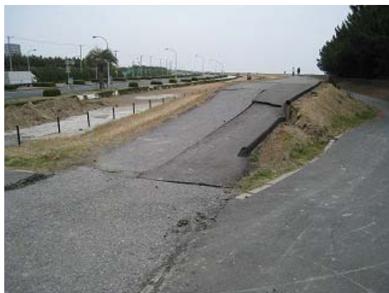
図-10 幕張海岸周辺道路の変状
