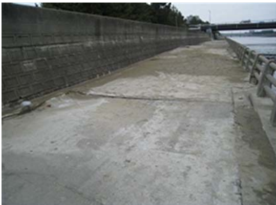
図-11 花見川右岸の護岸上噴砂
