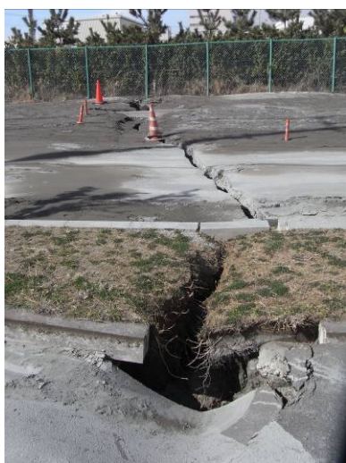
(写真) 千鳥地区 : (右) 50cm 程度倉庫周りの地盤が沈下。
