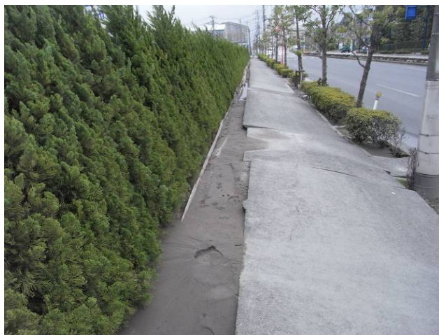
(写真) ディズニーリゾートパーク第5周辺道路：バス停、支柱の傾きおよび歩道の変状
