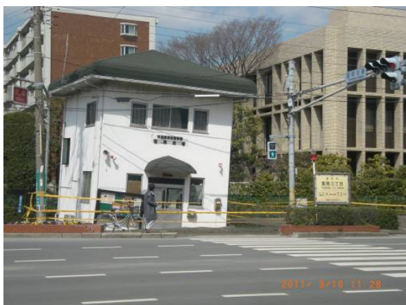
(写真) 富岡地区の交番の傾斜
