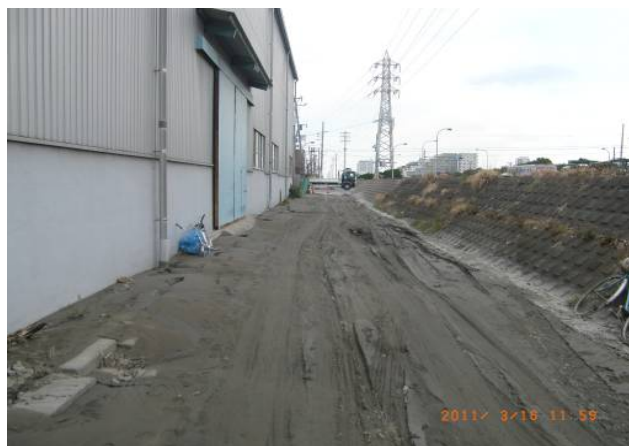
(写真) 鉄鋼通り地区 : (左) 産業用道路の噴砂が片付けられていた (右) 南東側は噴砂多い。
