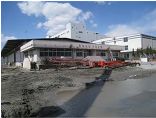
図-7 葛南中央埠頭の上屋脇の液状化
