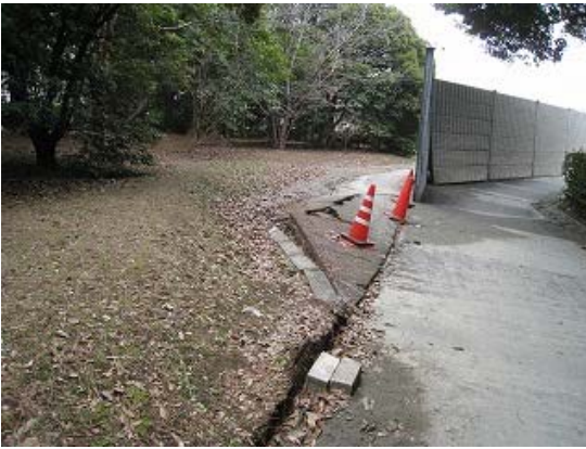
図-9 東関道脇の道路歩道の座屈
