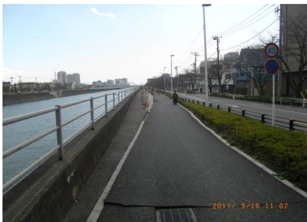
(写真) 境川の堤防付近の地盤沈下
