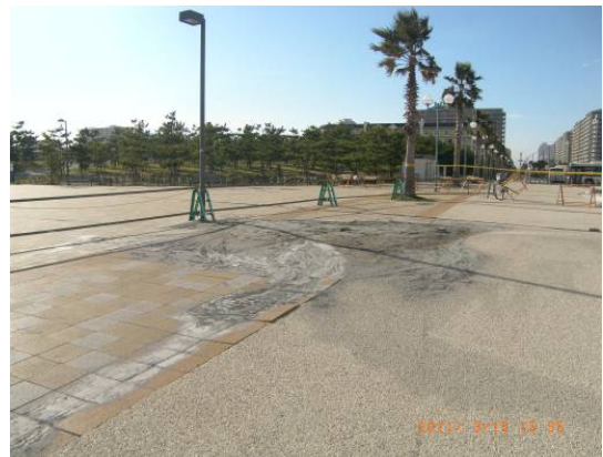
(写真) 有明 5 丁目 公園敷地に直線上のクラック。このクラックの北西側 (JR 側) では液状化が発生し地盤が沈下している。一方でこのクラックより南東 (海側) ではほとんど液状化が見られない。これは、上記の被害の有無の境界線上に位置する。
