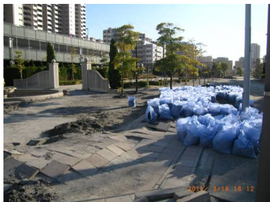
(写真) 日の出地区の液状化被害
