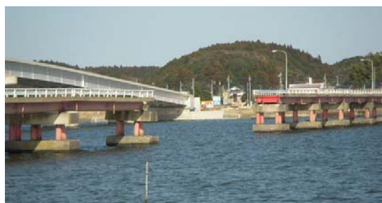
図-4.2 鹿行大橋の落橋箇所
