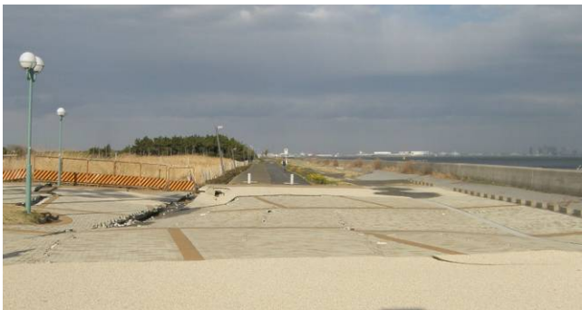
(写真) 日の出地区 最南東部の護岸付近の液状化被害
