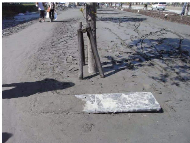
(写真) 明海地区の液状化被害
