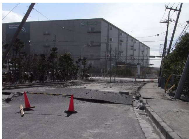
(写真) 港地区 : ここは倉庫地区。噴砂は少ない。 (写真) 千鳥地区 : 噴砂が多く、道路の被害大。
