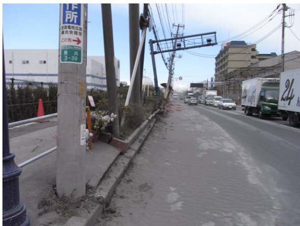
(写真) ディズニーリゾートパーク第5周辺道路：バス停、支柱の傾きおよび歩道の変状
