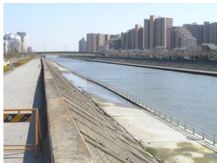
(写真) 境川左岸堤防 明海2
