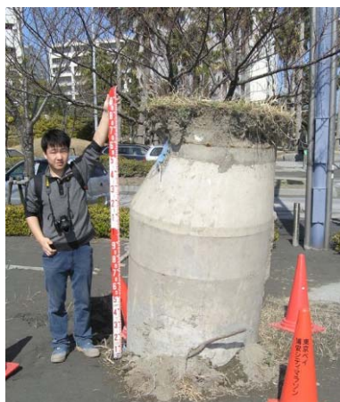
(写真) 明海地区のマンホール浮き上がり (最大 2m)
