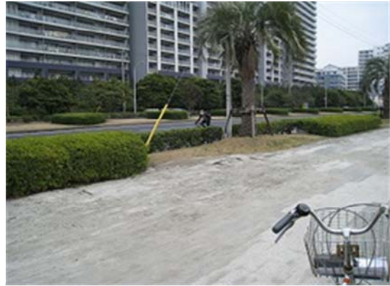
図-8 打瀬地区の高層住宅と周辺道路の噴砂
