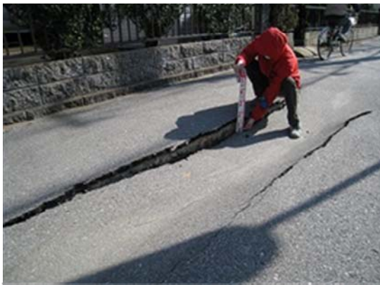
図-5 磯辺7丁目付近の道路の陥没
