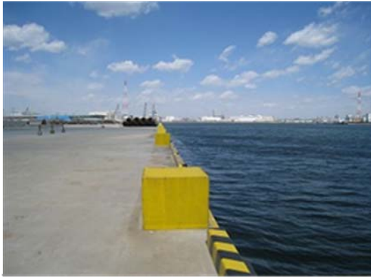
図-5 被害のない葛南中央埠頭の護岸
