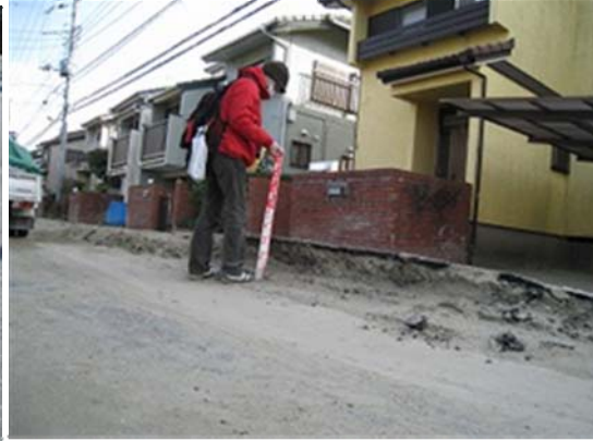
図-6 磯辺8丁目付近の道路の段差
