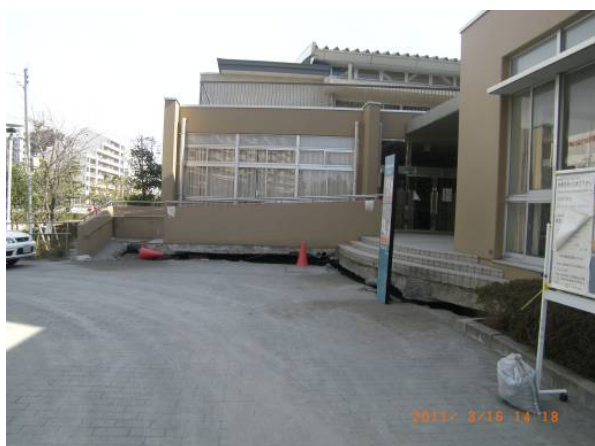
(写真) 高洲地区：(左) マンホールの浮き上がり(最大 1.5m)、(右) 小学校校舎の不陸(最大 60cm)
