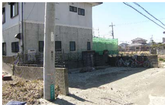
図-1.4 液状化による家屋の沈下
