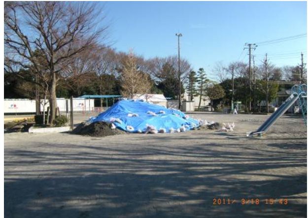
(写真) 東野地区：約 9ha の宅地の噴砂を片付けた土砂が公園に集められていた。目測で約 60m 3 。
