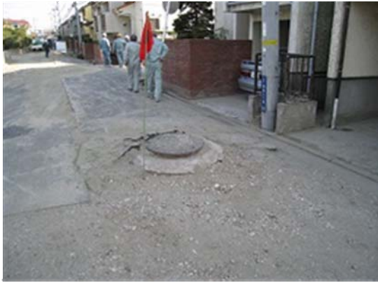
図-3 磯辺7丁目付近のマンホールの浮上
