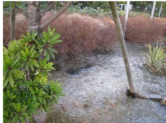
図-4 アパホテル前の水道管の破裂
