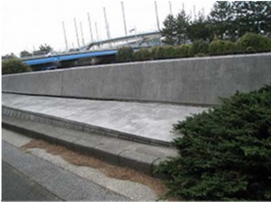
図-7 浜田川護岸の目地開き
