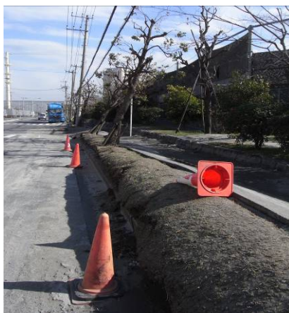
(写真) 千鳥地区 : (右) 50cm 程度倉庫周りの地盤が沈下。
