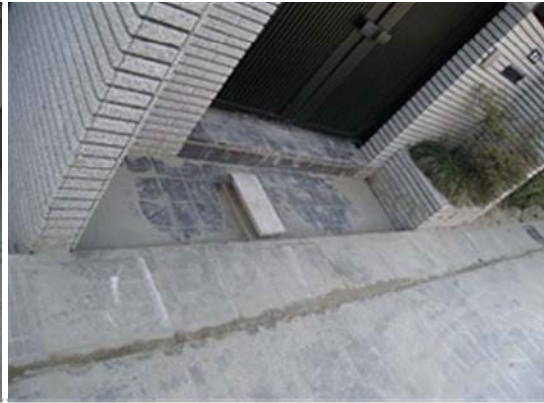
図-4 磯辺7丁目付近の住宅の沈下
