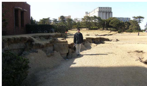
図-2.2 港公園内のすべり破壊
