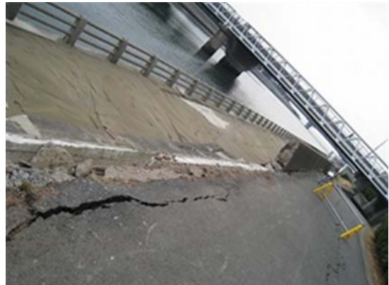
図-12 花見川右岸の擁壁の倒壊
