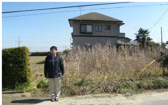
図-1.3 液状化による家屋の傾斜
