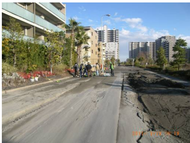
(写真) 明海地区の液状化被害
