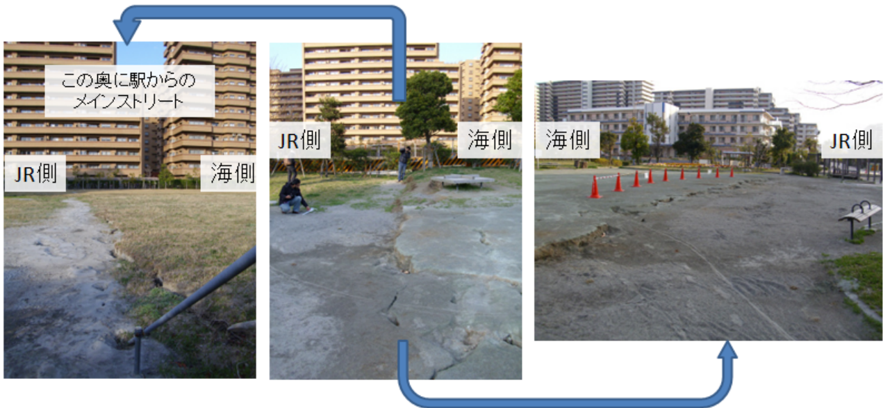
(写真) 有明 5 丁目 公園敷地に直線上のクラック。このクラックの北西側 (JR 側) では液状化が発生し地盤が沈下している。一方でこのクラックより南東 (海側) ではほとんど液状化が見られない。これは、上記の被害の有無の境界線上に位置する。
