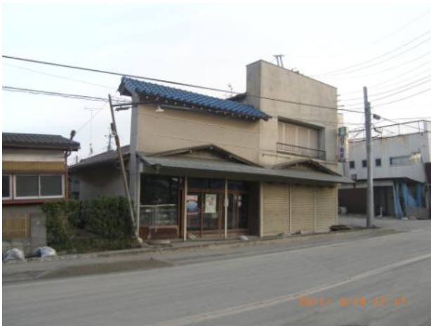
(写真) 上記の通り沿いで、沈下、傾斜した建物
