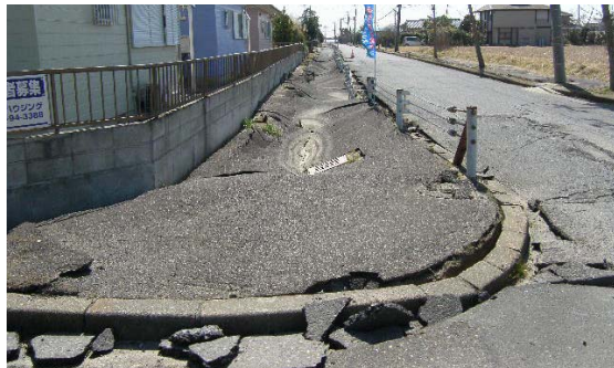
図-1.1 液状化による歩道の陥没
