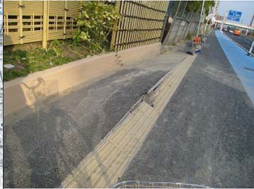
図-2 国道14号歩道の変状
