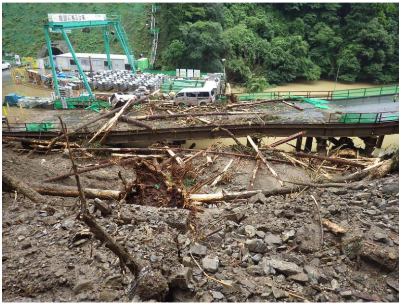
崩土・倒木が仮設プラントまで流れ込む
