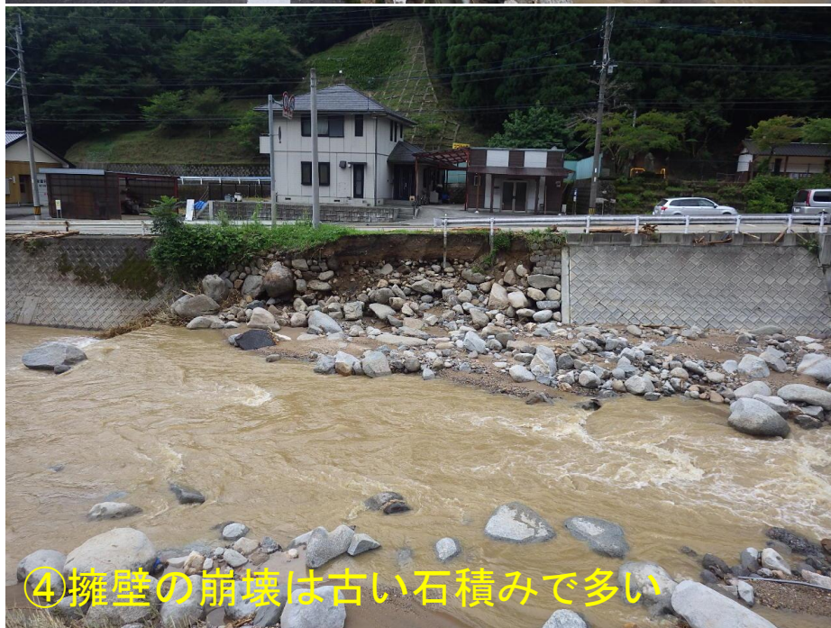
④河川沿いの道路は断続的に崩壊 片側車線の盛土部が崩壊したと思われる
