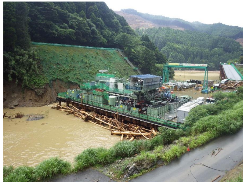
斜面崩壊による流木が滞留
