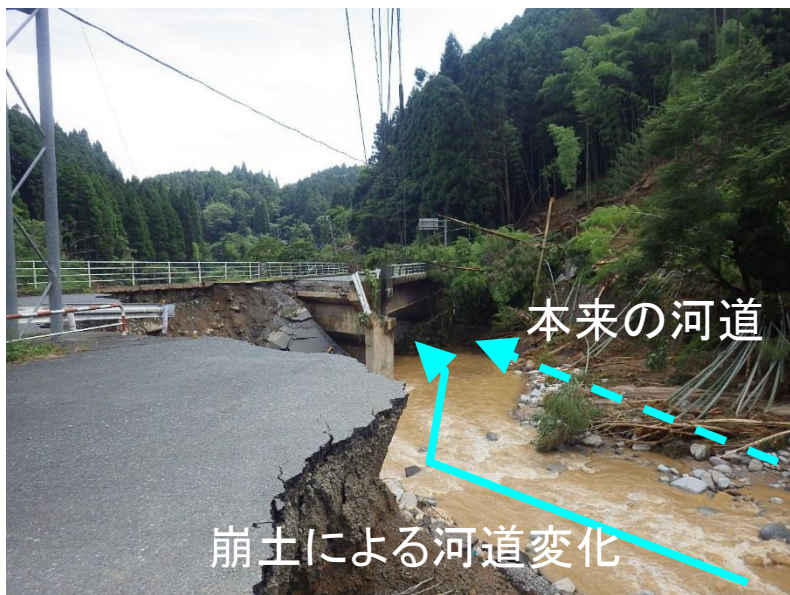
②河道が改変し、橋台背面を直撃
