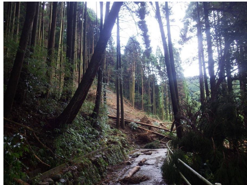
①の対岸を通る町道も斜面崩壊で寸断
