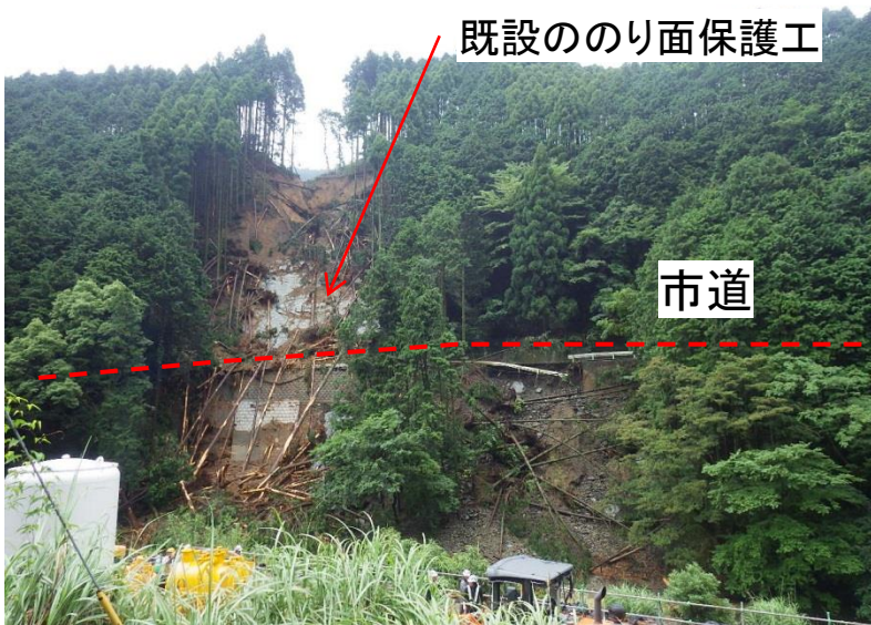
のり面保護工の上部斜面が崩壊し、市道を寸断した。
