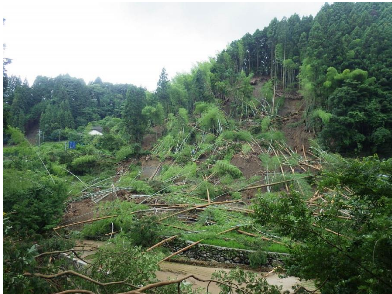
①幅100m程度の表層崩壊で国道寸断
