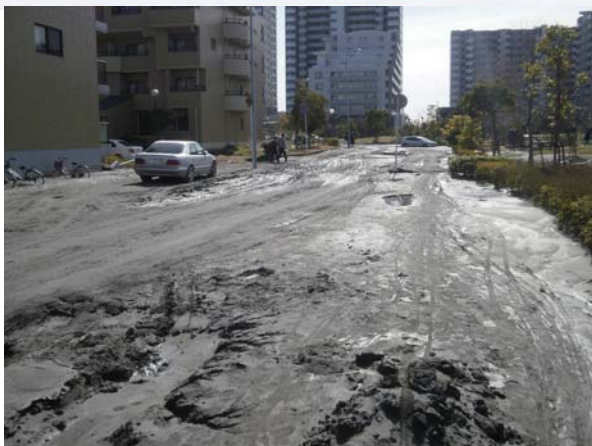
▲東北地方太平洋沖地震 液状化の噴砂で砂場ようになった市街地
