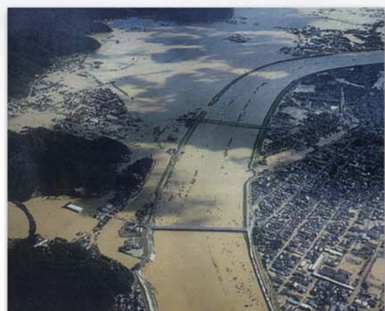
▲ 豪雨による河川堤防の決壊 (提供：国土交通省豊岡河川国道事務所)
