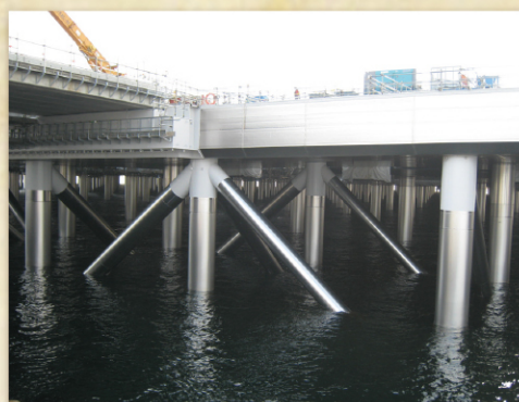
▲ 東京国際空港（羽田空港）D滑走路の栈橋構造
