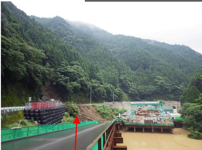
斜面の崩壊土砂・倒木が道路を塞ぎ、更に仮設プラントを巻き込んだ。
