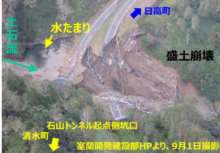
一般国道274号 日勝峠（8合目付近）の被災状況
