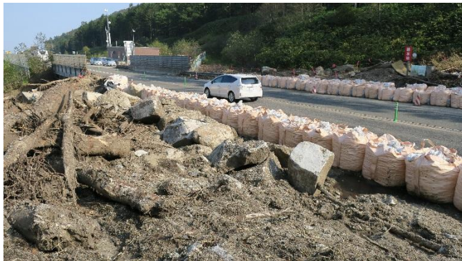
道東道狩勝第二トンネル(十勝清水側)
