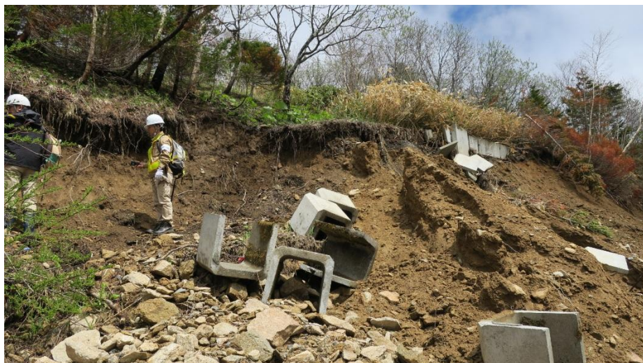
日勝峠の排水溝・横断管の被災状況
