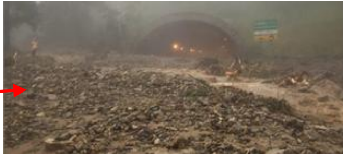
上流からの土石流により道路上に土砂が堆積しているが、上からの水は、降雨の時に少し流れている程度で、常時はほとんど流れていない状況
