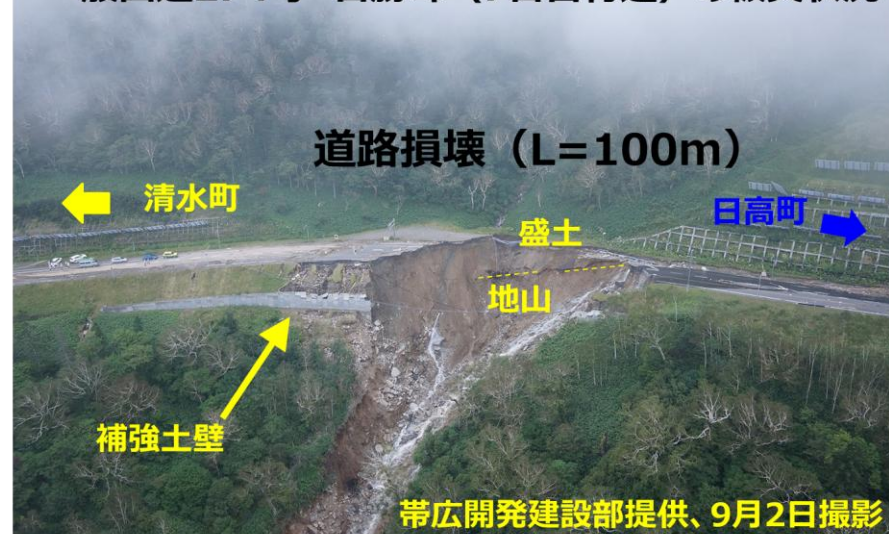
一般国道274号 日勝峠（7合目付近）の被災状況
