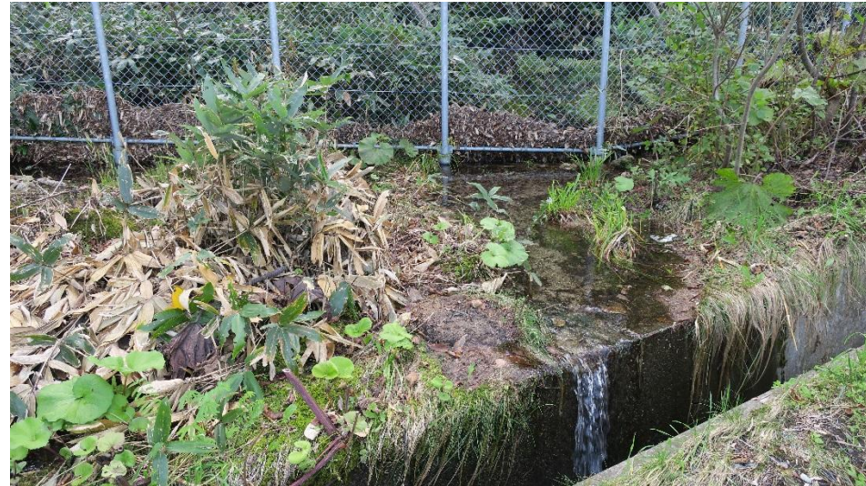
2段目切土部後背地に新たな水道ができ、地盤の排水機能・能力が変化
