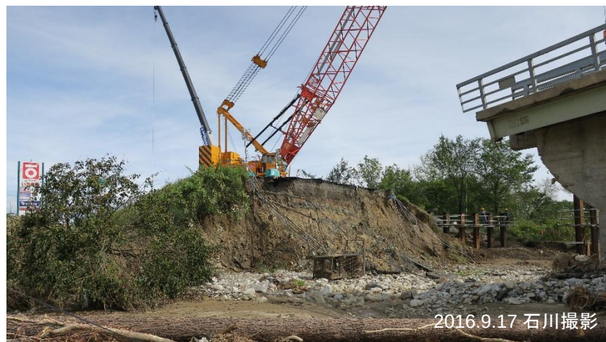
国道38号清見橋(清水町)
