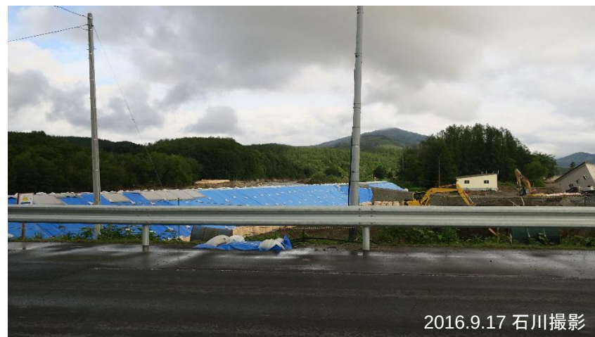
国道38号空知川太平橋付近(南富良野町)
