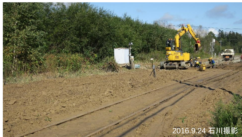
十勝清水駅構内(帯広側から撮影)
