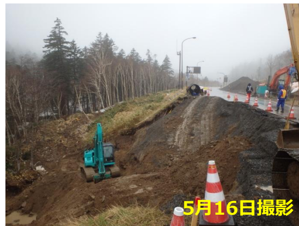
現場状況(谷側日高側を望む)
