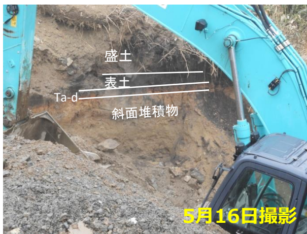
現場状況(崩壊断面)
