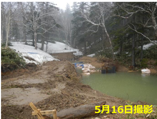
現場状況(山側)
