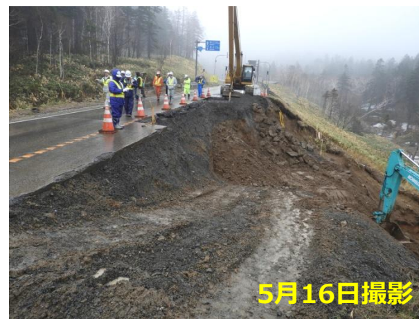
現場状況(谷側帯広側を望む)
