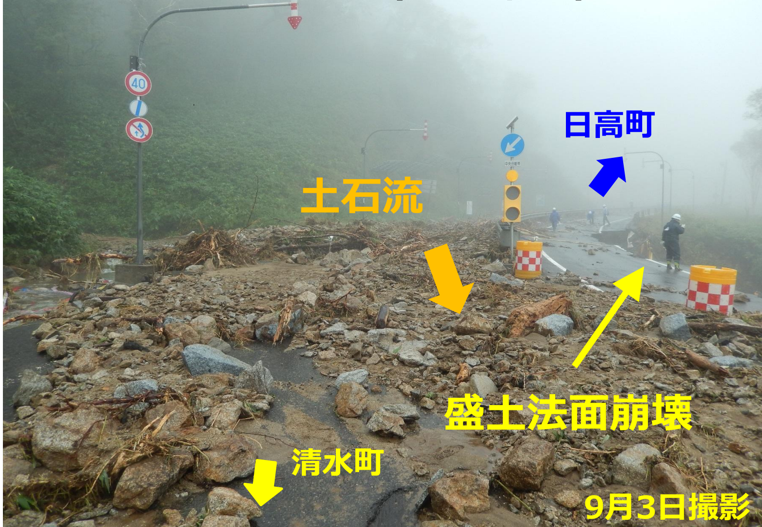
路面に土砂・石・樹木が堆積
