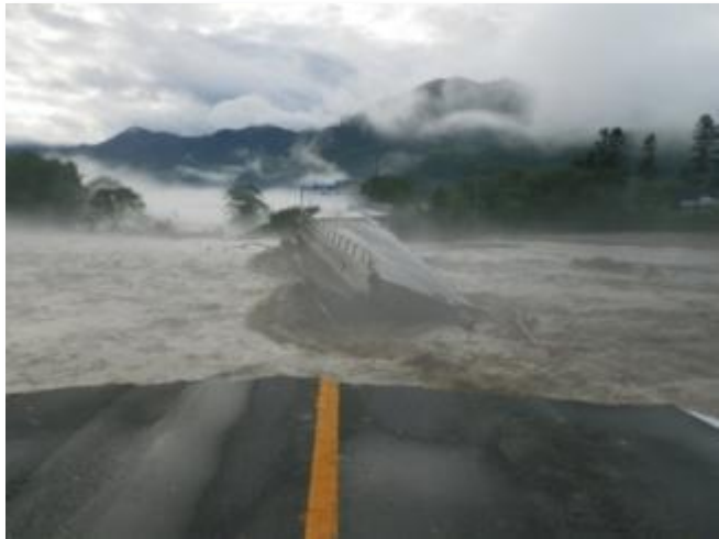
△落橋状況 (H28.8.31)
