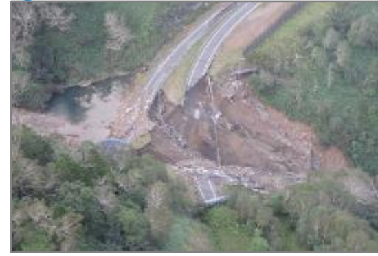
③⑧ 帯広側8号目付近盛土崩壊
