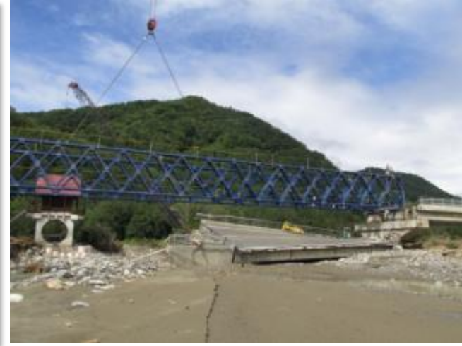
△復旧作業用仮橋架設状況 (H28.9.9)
