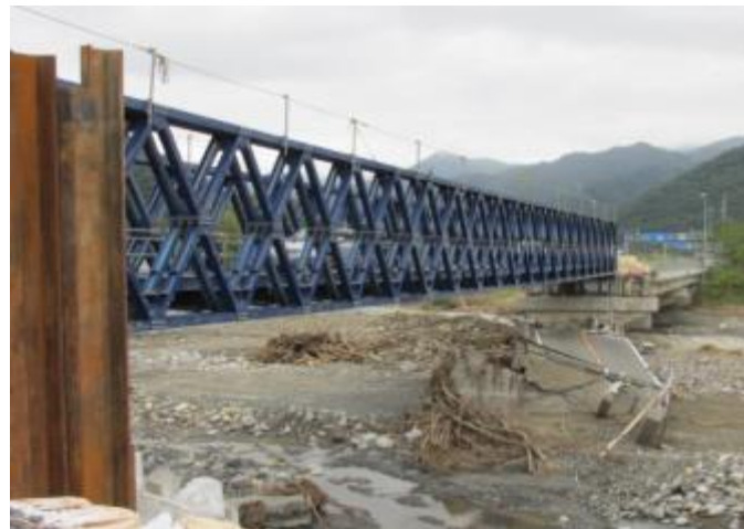
△仮設完了状況 (H28.9.13)
