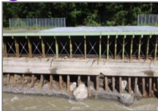
⑩ 清瀬覆道損傷
