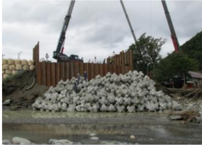
△道路洗掘防止工完了 (H28.9.5)
