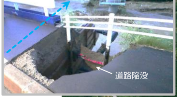
橋台背面盛土の変状
