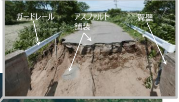
橋台背面盛土の流失
