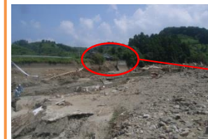
ため池右岸護岸崩壊箇所上の建物崩壊箇所、背後からの流水跡が確認される。
