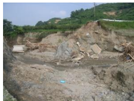
堤体が大きく流亡している。
