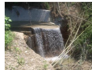
水吐部下流側及び側部は大きく浸食・洗掘されている。流路右側に当たる堤体法面は、洗掘に伴い崩壊している。
