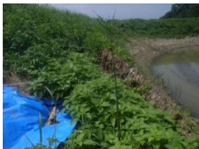
痕跡水位は天端より低く、越流は発生していないものと考えられる。
