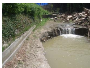
堤体下流側の流路部には多数の浸食・洗掘跡が確認される。
