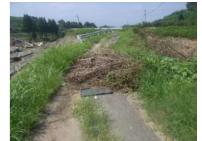
ため池右岸護岸崩壊箇所では背後からの流水跡や、これに伴う浸食・洗掘跡が確認される。
