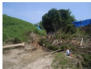
堤体下流側の流路部には多数の浸食・洗掘跡が確認される。
