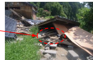
ため池右岸護岸崩壊箇所上の建物崩壊箇所、背後からの流水跡が確認される。
