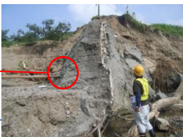
堤体右岸崩壊部にすべり破壊に伴いクラック・段差が確認される。洗掘の進行に伴うすべり破壊跡？
