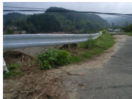
天端・袖部道路付近に明瞭な越流跡が確認される。
