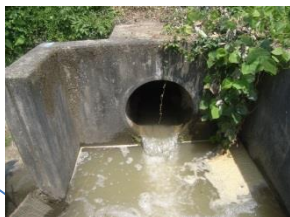
堤体下流側のり面、法尻部に有意な変状の発生は見られない。
