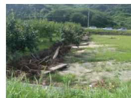
ため池左岸耕作地に越流に伴う浸食・洗掘跡が確認される。
