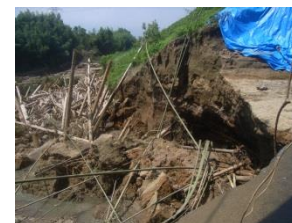
水吐部下流側及び側部は大きく浸食・洗掘されている。流路右側に当たる堤体法面は、洗掘に伴い崩壊している。
