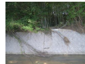
水吐部には流木の堆積が見られ、コンクリート壁上部の樹木、堤体部に痕跡水位が確認される。
