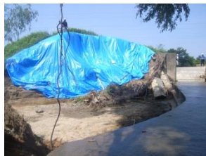
水吐部付近の堤体土砂が流出しており、流路護岸部が崩壊している。
