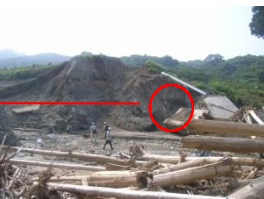
堤体左岸崩壊部にパイピング孔及び地下水の浸出が確認される。
