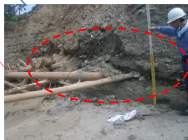
堤体右岸崩壊部にすべり破壊に伴いクラック・段差が確認される。洗掘の進行に伴うすべり破壊跡？
