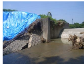
水吐部付近の堤体土砂が流出しており、流路護岸部が崩壊している。
