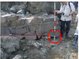
堤体中央深部に古い石積みが確認される。土砂の流出跡が見られる。
