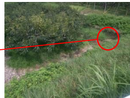
ため池右岸袖部に越流に伴う洗掘跡が確認される。
