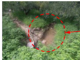
ため池右岸袖部に越流に伴う洗掘跡が確認される。
