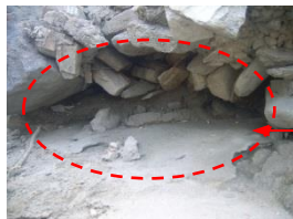
堤体中央深部に古い石積みが確認される。土砂の流出跡が見られる。
