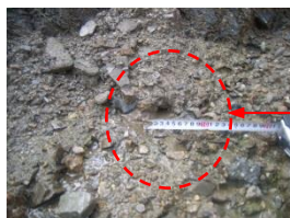
堤体左岸崩壊部にパイピング孔及び地下水の浸出が確認される。
