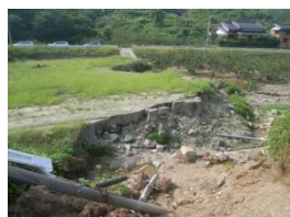
ため池左岸耕作地に越流に伴う浸食・洗掘跡が確認される。
