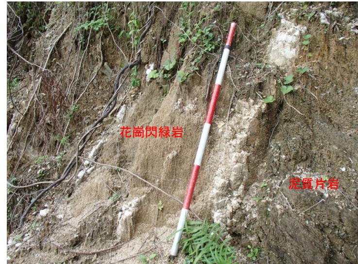
境界部の状況(北川)
