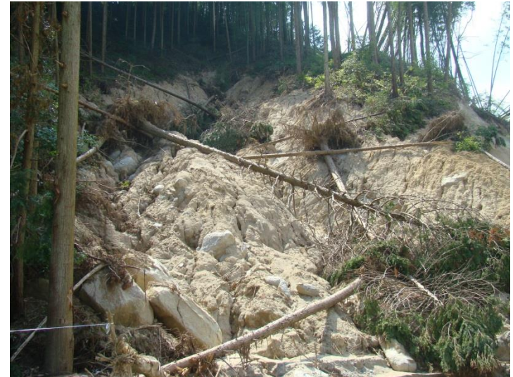
岩芯が玉石状に残留する強風化部
