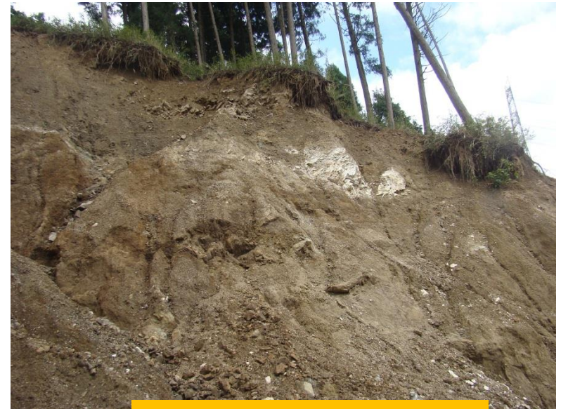
寒水川源頭部 崩壊面
