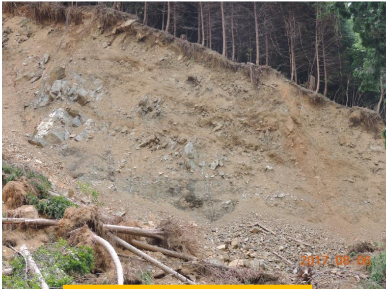
乙石川源頭部 崩壊面
