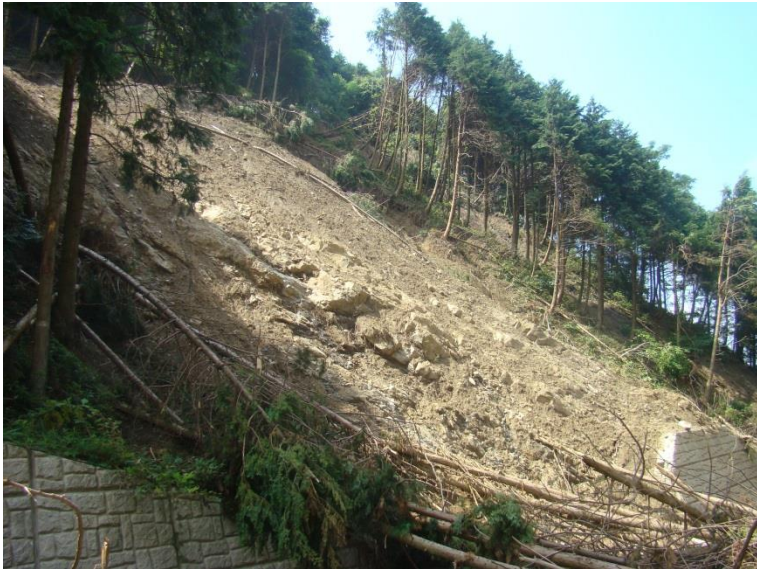
奈良ヶ谷川溪岸崩壊
