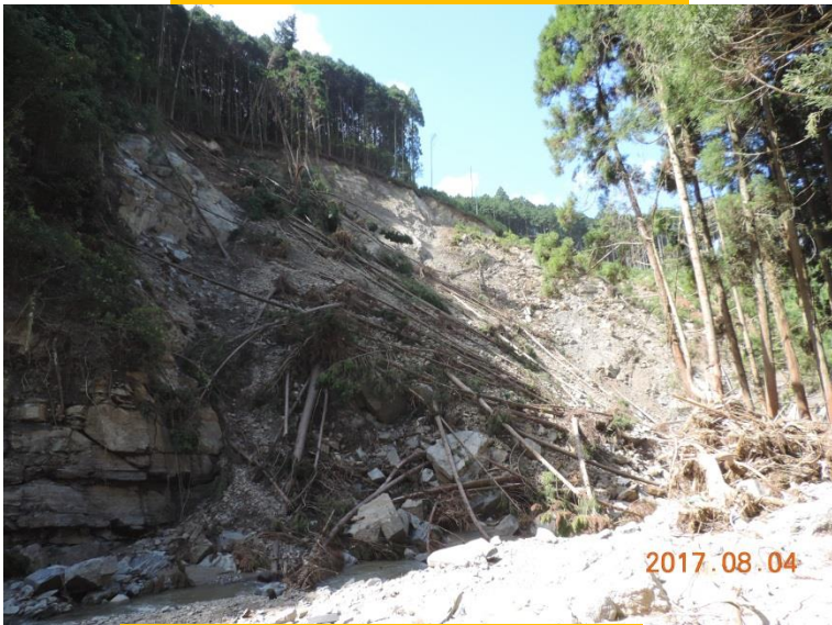
黒川溪岸の洗掘崩壊
