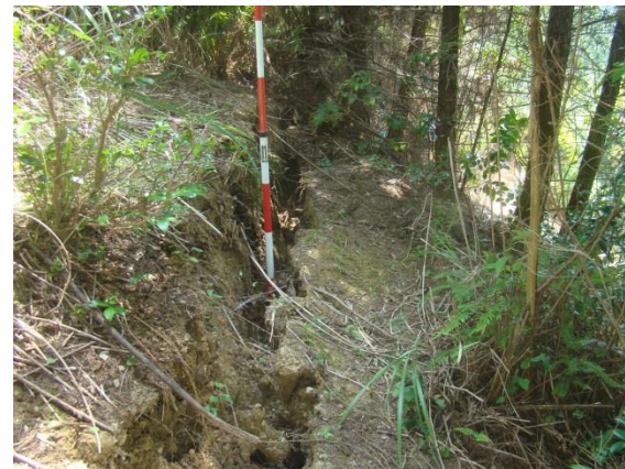
滑落崖より上の亀裂
