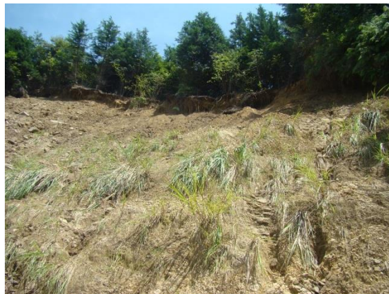
崩壊頭部 崩壊深は浅く勾配は30°
