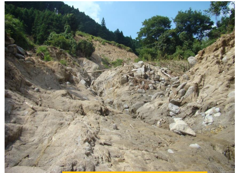
北川中流域溪岸崩壊
