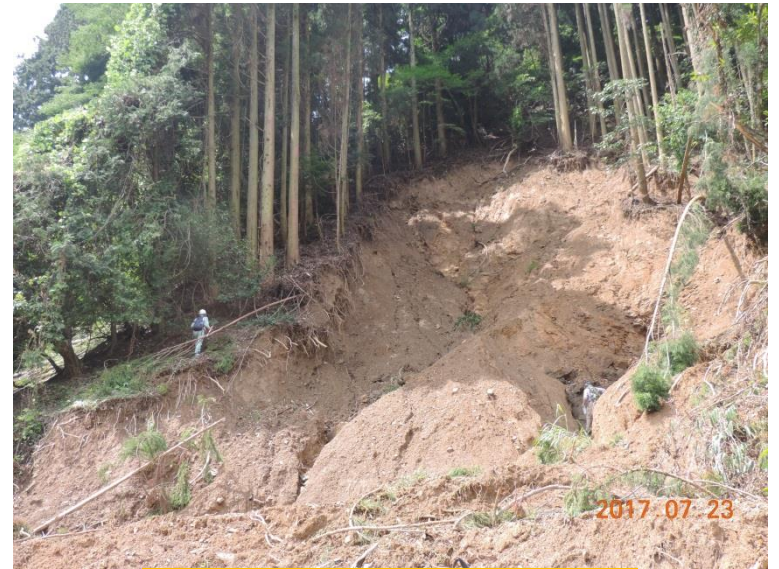
国道211号斜面の崩壊
