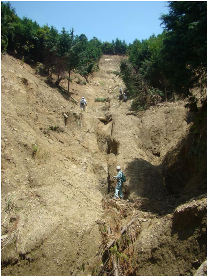
左岸側溪岸斜面の大規模崩壊
