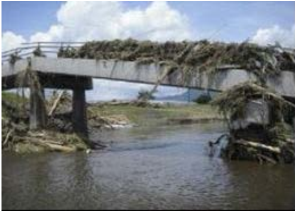
写真-1 集中豪雨における RC 橋脚に関する研究検討 (葛西ら)
