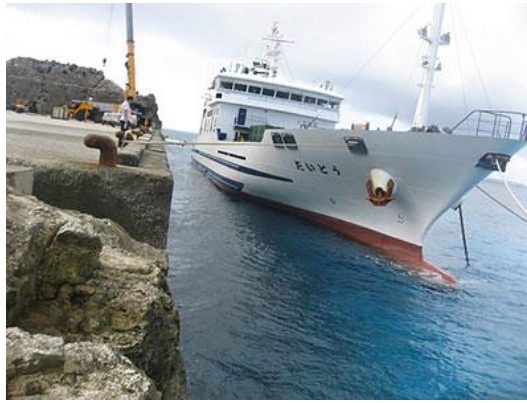
写真 4-4-1 北大東島における船舶の係留状況。防波堤がなく波が直接来襲するため、船体の損傷を避けるために岸壁から一定の距離を置いて係船し、乗船客の乗り降りや貨物の荷役は移動式クレーンによって行われている。(笹川平和財団 HP より https://www.spf.org/_opri/newsletter/410_2.html )
