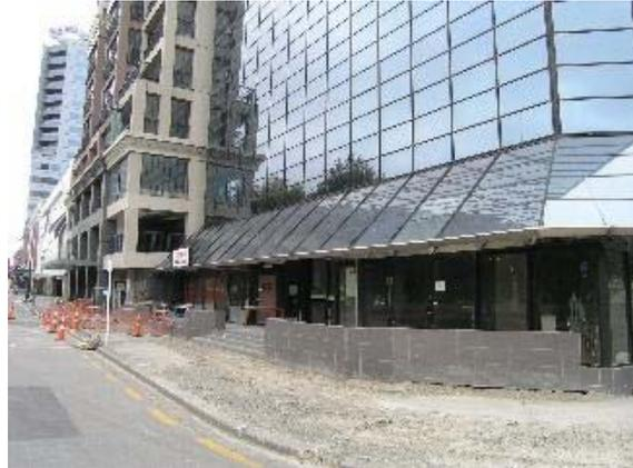
Figura 9 Falla por hundimiento e inclinación de un edificio de buena calidad, luego de un evento sísmico, debido a un subsuelo no adecuado
