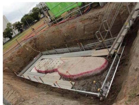
Figura 6 Labor de asesoría geotécnica para la recuperación luego del terremoto de 2011 (desarrollo técnico de paredes reticulares subterráneas en terrenos proclives a sufrir de licuefacción)
