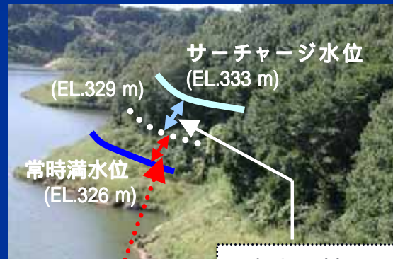
試験湛水後の湖畔の林
