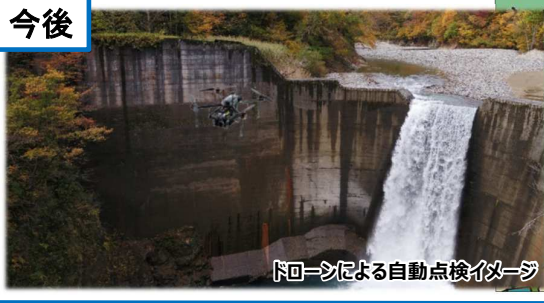
ドローン（目視飛行）による施設点検
