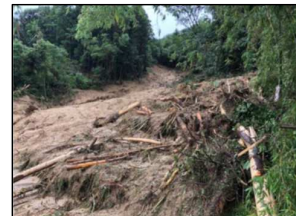
被災状況写真
