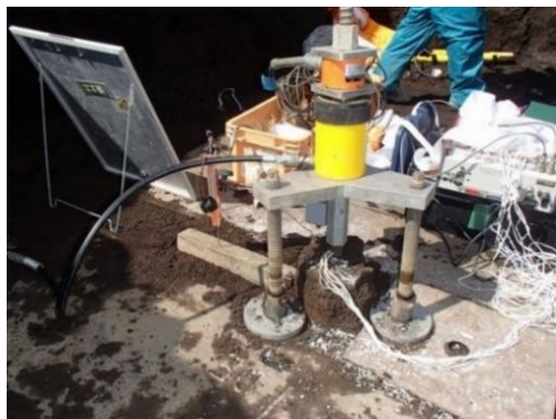
図-8 補強材の引抜試験状況
