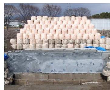
図 2 実大試験盛土全景
