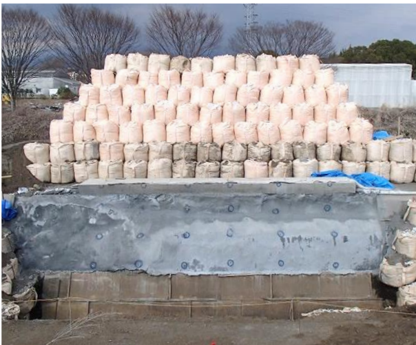
図-12 荷重（大型土のう 5 段積み）完了後の試験盛土の状況 正面図
