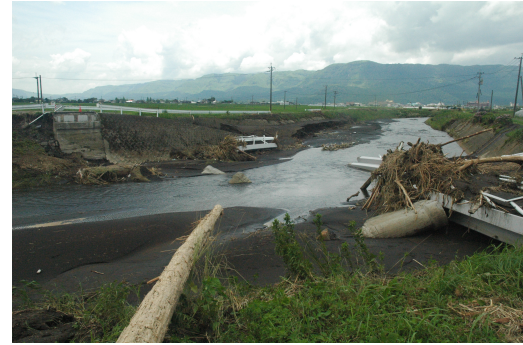
写真-5 黒流橋の被災状況
