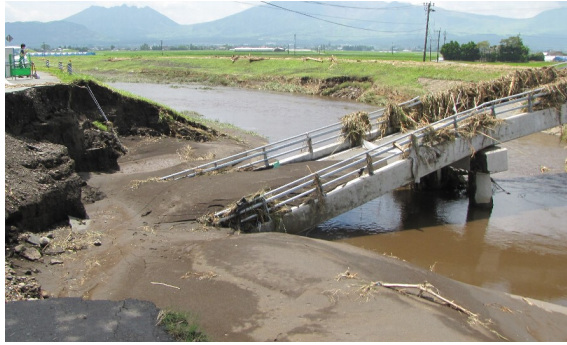
写真-4 橋台の沈下 (7月15日における鷺の石橋)
