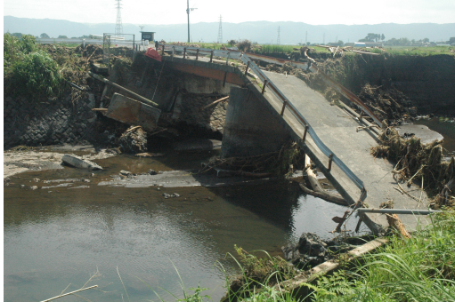
写真-6 西浜橋の被災状況
