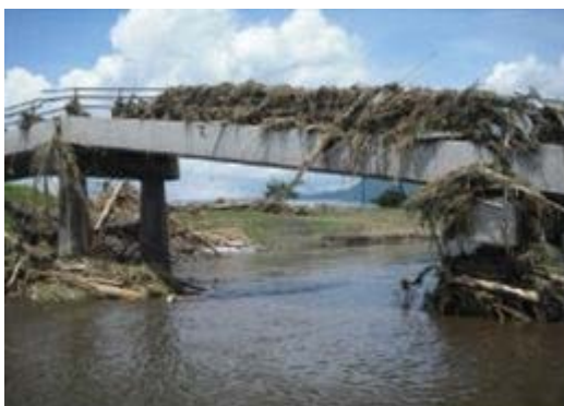
写真-1 鷺の石橋 現地調査写真
