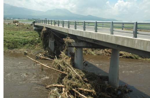
写真-7 山田橋の被災状況
