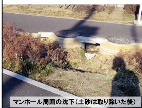
マンホール周囲の沈下(土砂は取り除いた後)
