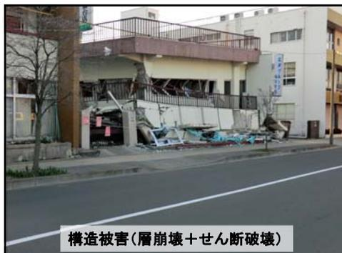
構造被害(層崩壊+せん断破壊)
