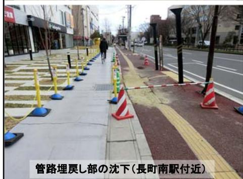
管路埋戻し部の沈下(長町南駅付近)
