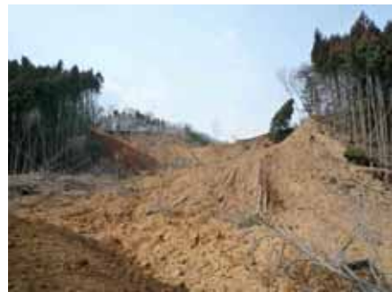
写真-1 葉の小平地区の斜面崩壊
