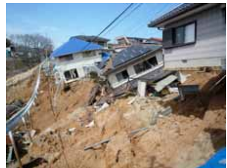
写真-2 あさひ台団地の盛土斜面崩壊
