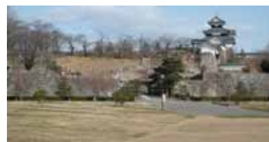
写真-5 小峰城石垣の崩壊
