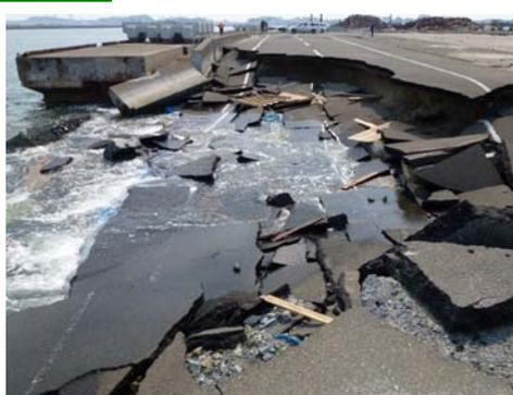
破壊された護岸(アスファルトの下の土は流出していた)
