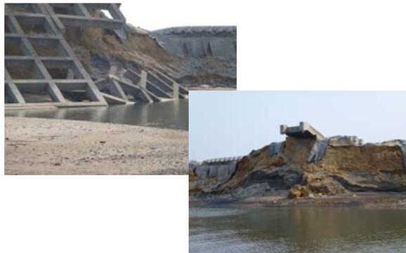
破壊された防潮堤の拡大図(内部の土が露出している)
