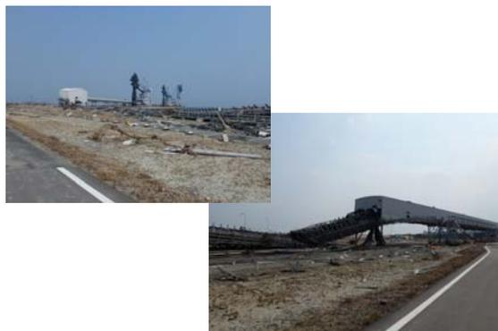
津波になぎ倒された石炭ベルトコンベア
