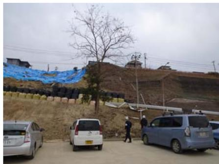
同地区では以前より、何度も崩壊が起きている。斜面右側は前回の崩壊箇所。修復時に補強がなされていた。垂直に近い角度の斜面となっているが、今回の地震ではほとんど変形が生じていなかった。
