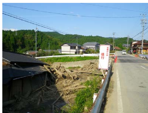
図-33 土石流の被災状況
