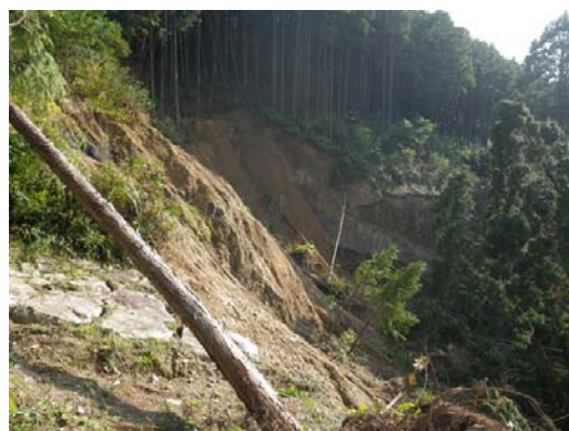
図-13 道路等を寸断した比較的規模の大きな斜面崩壊
