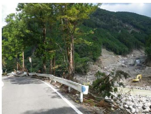
図-28 対岸への土石流被害状況
