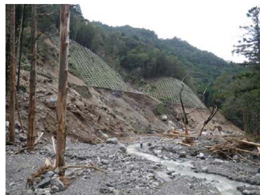
図-25 補強土壁等の崩壊状況
