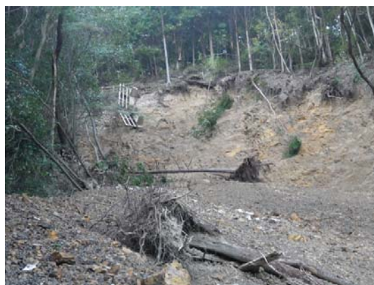
図-12 斜面崩壊状況
