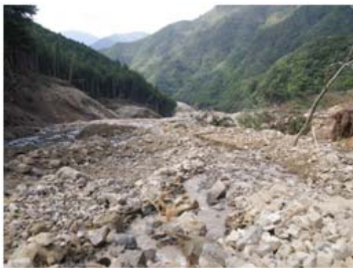
図-22 土石の流下状況
