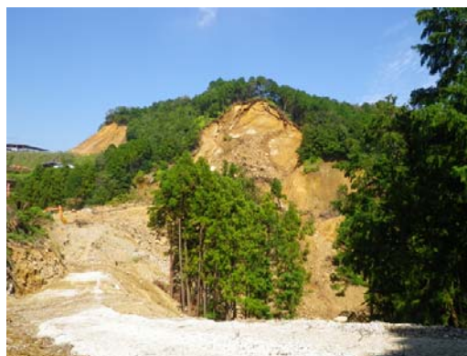
図-10 向かい側の斜面の崩壊状況
