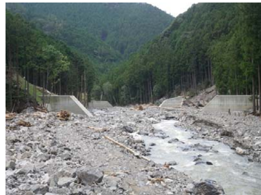
図-23 砂防堰堤の状況
