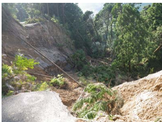
図-13 道路等を寸断した比較的規模の大きな斜面崩壊
